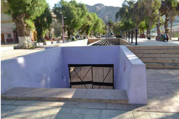
Foto: obra Alicanto.
