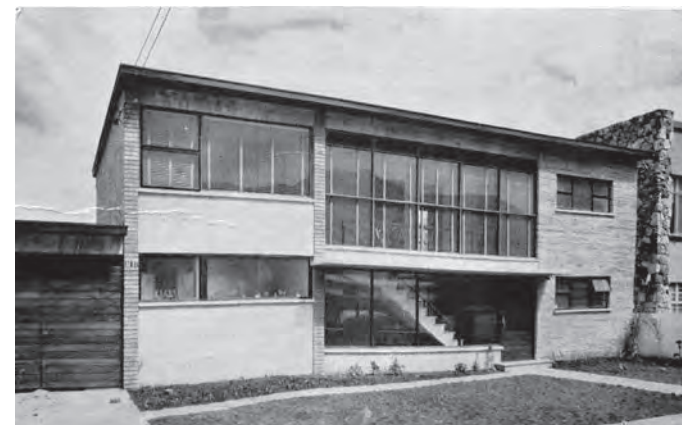
101a. Casa Liévano. Vista desde la calle. Fuente: Revista "PROA" No. 70 de 1953
