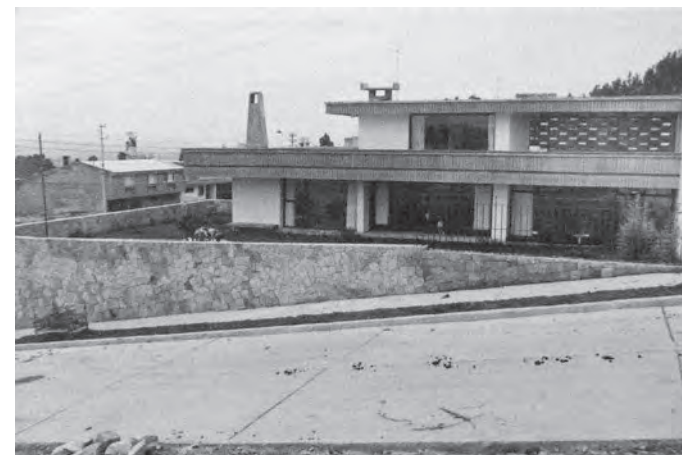
120a. Casa Pradilla. Vista desde la calle.
