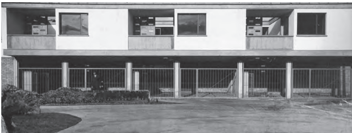
95. Fotografía de un conjunto de casas medianeras de RCP. Fuente: Archivo particular Olga Gómez de Prieto
