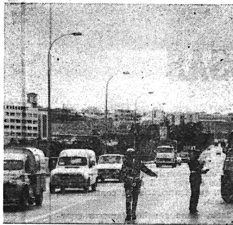
Carretera Nacional 340, de Valencia a Barcelona, junto al puente sobre el Francolí e inmediaciones del cruce de Torreforta.—(Foto Archivo)
