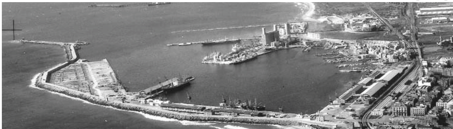
▲ Puerto. Vista aérea de las obras del dique de Levante
