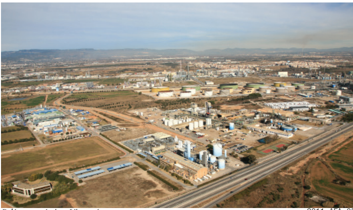
Polígono químico. Vista aérea
