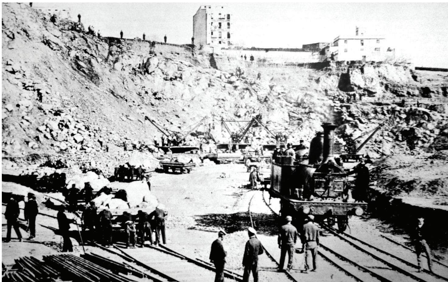
Instantánea de los trabajos en la pedrera cercana al puerto. 1865
