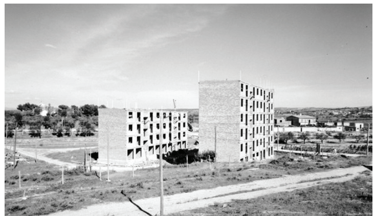
Viviendas en construcción en Torreforta
