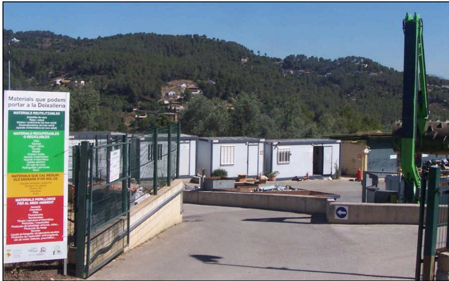
Figura 6.5: Deixalleria de Corbera de Llobregat.
