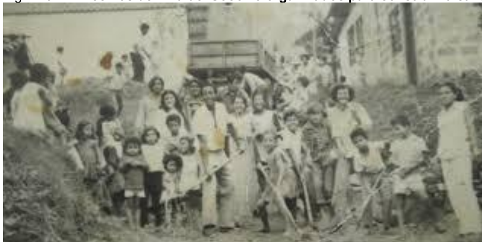
Figura 6. 21: Vecinos de Villa del Socorro organizados para construir la calle
