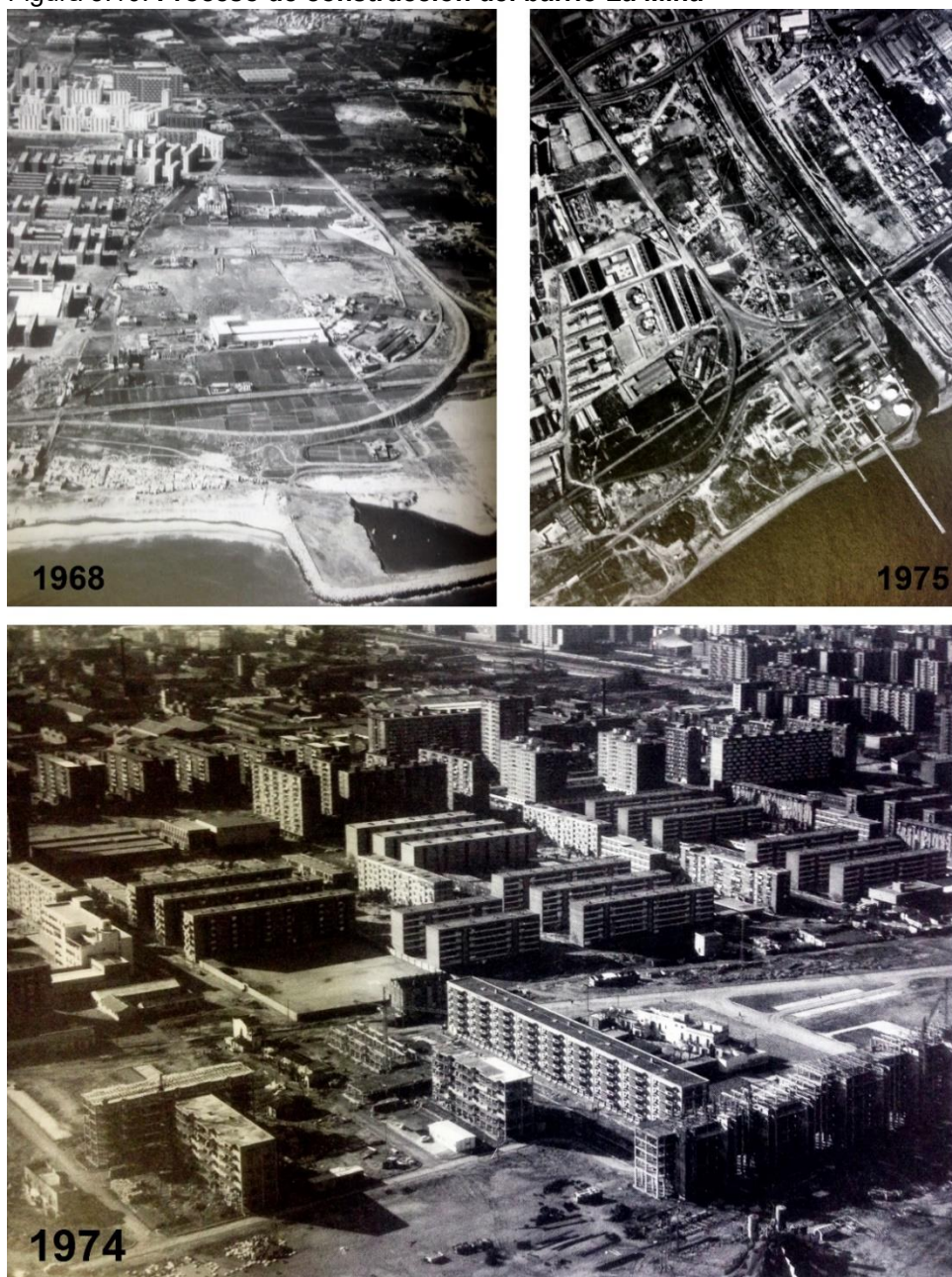
Figura 5.10: Proceso de construcción del barrio La Mina
