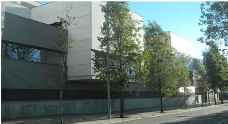
Figura 5.36: Nueva infraestructura Instituto
