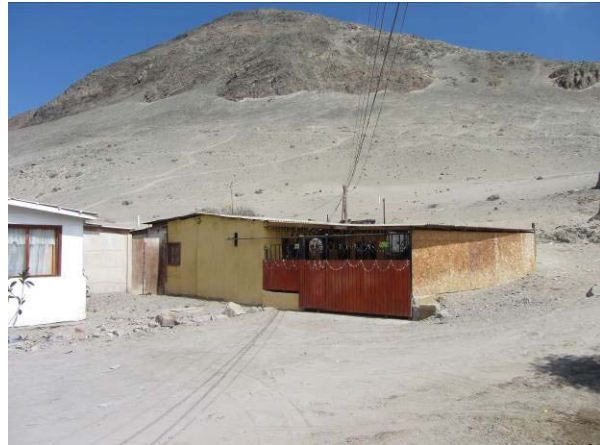
Construcción mixta localizada en borde oriental del sector D
