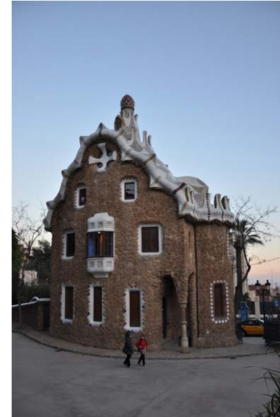
Figura 74: Obra La Portería, localizada en el Parc Güell
