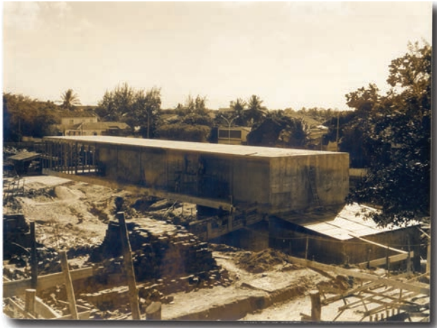
36. Fotografía de la construcción del Mausoleo del General Castelo Branco, caracterizado por la audacia estructural del gran vuelo de 30 metros. Fuente: Ídem
