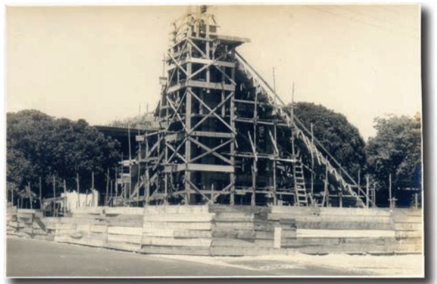
31. Fotografía la construcción de la capilla. Fuente: Ídem.
