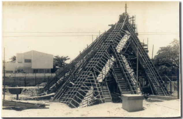
30. Fotografía la construcción de la capilla. Fuente: Archivo de Sergio Bernardes/ Núcleo de Investigación y Documentación - NPD - FAU/UFRJ.
