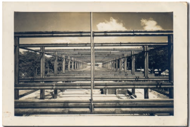
33. Fotografía de la secuencia de pórticos estructurales construidos con dobles tubos de acero del Palacio de gobierno. Fuente: Ídem.
