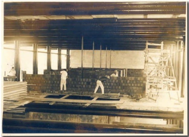
34. Fotografía de la construcción de la compartimentación interior mediante ladrillo cerámico del Palacio de gobierno. Fuente: Archivo de Sergio Bernardes/ Núcleo de Investigación y Documentación - NPD - FAU/UFRJ.
