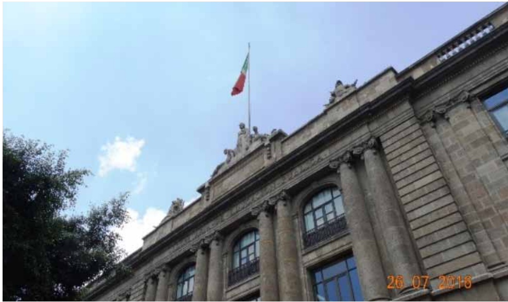
Fachada principal del edificio de la Secretaría de Educación Pública, en la actual Calle de la República de Guatemala. En el remate se puede ver el frontón con el conjunto escultórico de Minerva, Dionisos y Apolo. Foto: Rubén Espinosa Cabrera, 2017.
