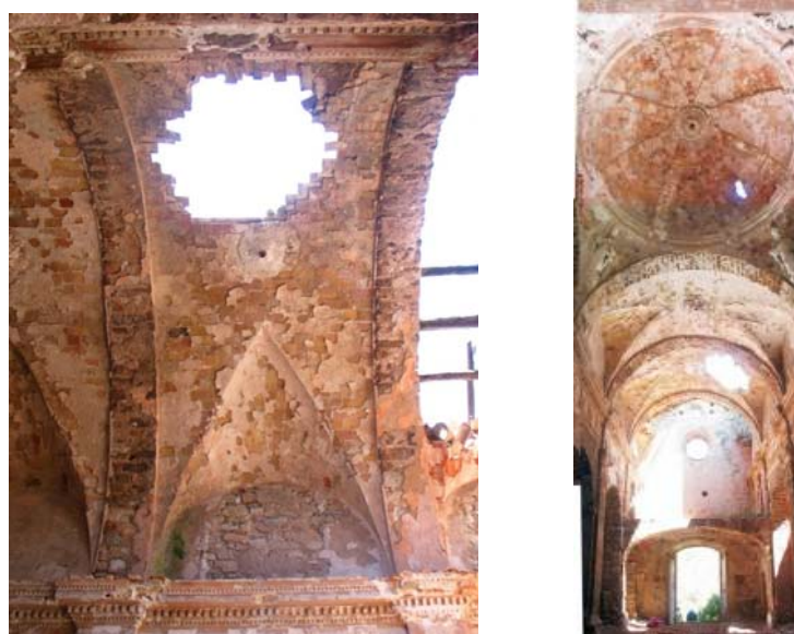
Fig.126 Església de Gaià. Les voltes i els arcs són estables malgrat les perforacions.
