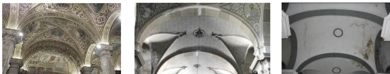
Fig. 84 A l'esquerra, volta e creueria peraltada sobre arcs de mig punt al Saló Sant Jordi. Al centre, volta de canó amb llunetes de l'església de Barberà de la Conca, maig 2014. A la dreta, volta de mocador de Rocafort de Queralt, juliol 2015.
