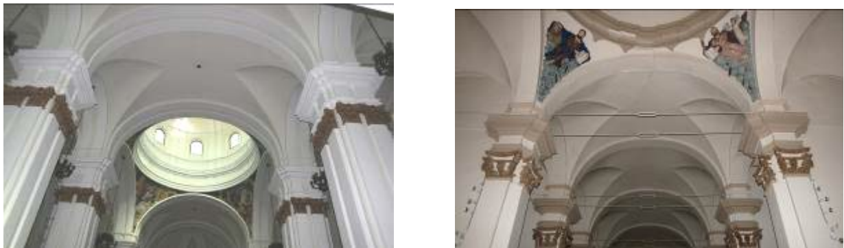
Fig. 67 Esquerra Aitona, agost de 2014. Dreta Algerri, juny de 2014. Les llunetes d'Algerri són lleugerament bombades, mentre que les d'Aitona no.
