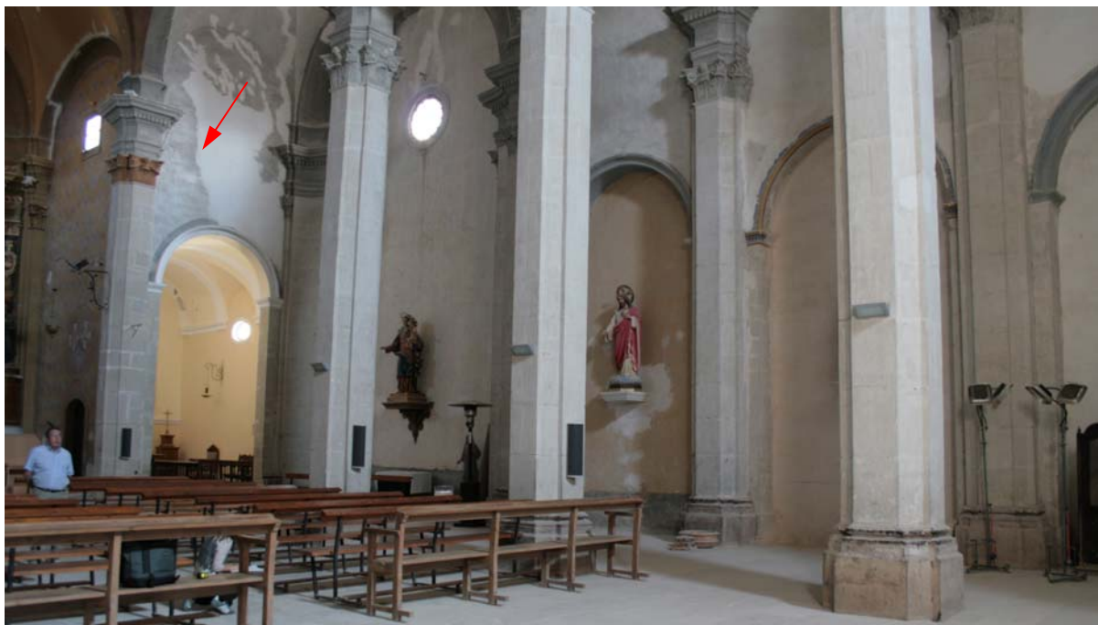
Fig.14 Esquerda a 45° del mur que es va tancar en la darrera intervenció, i el gran testimoni de quix no ha tornat a esquerdar.
