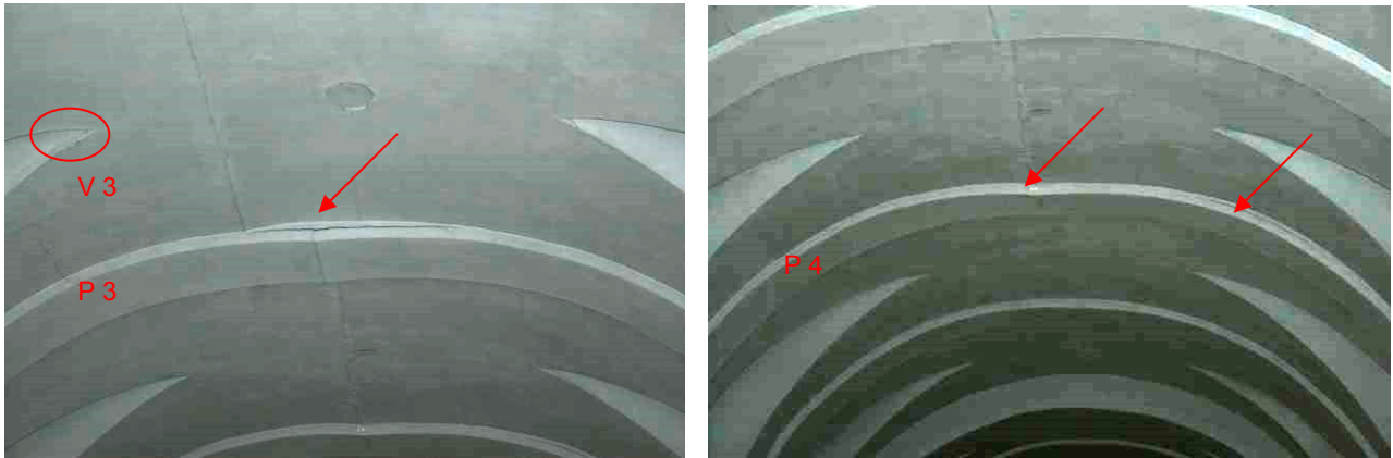
Fig.9 Voltes i arcs de rajola doblada
