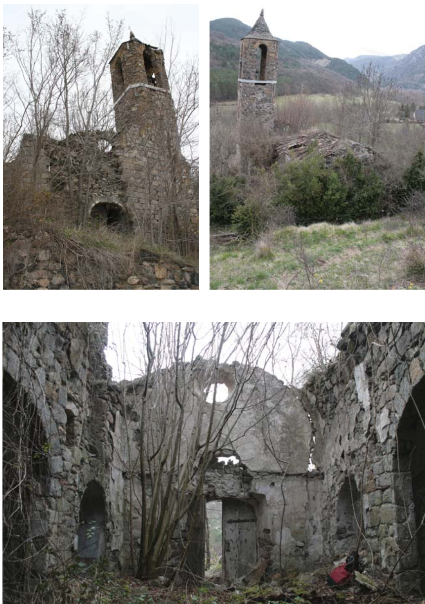
Fig.1 Fotografies de l'estat actual. Visita realitzada.
