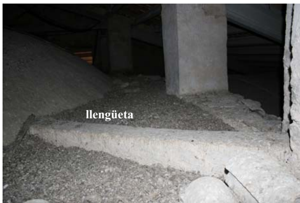
Fig.21 Llengüeta de la volta de mocador del creuer (esquerra), a la dreta configuració de la coberta actual, amb les restes de la pilastra central que sosté una bigueta de fusta corresponent a una coberta anterior.
