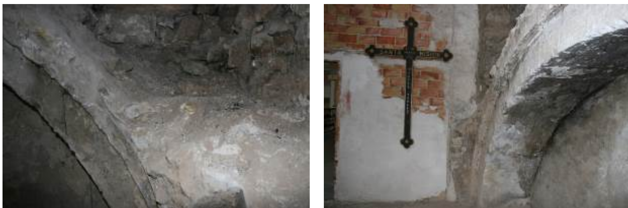
Fig.25 Vestigi de l'església de Mas de las Matas, agost de 2015, s'observa la de rajola doblada que solapa sobre els arcs formers.
