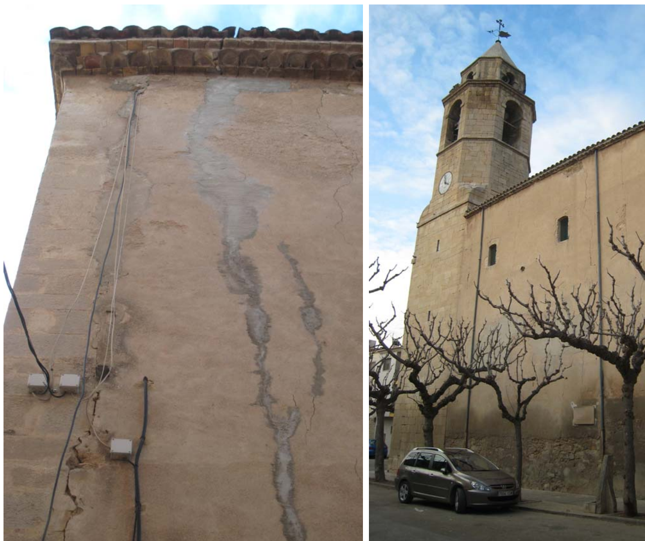
Fig.28 Esquerdes verticals als murs. Fotografies proporcionades per Ramon Padullés.
