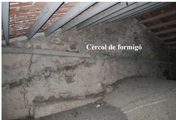
Fig.20 Fotografies de la volta de canó amb llunetes de la primera crugia d'accés a l'església. S'observa com el mur de façana es va estrebar per l'interior amb un cercol de formigó. S'observen les esquerdes verticals del mur.
