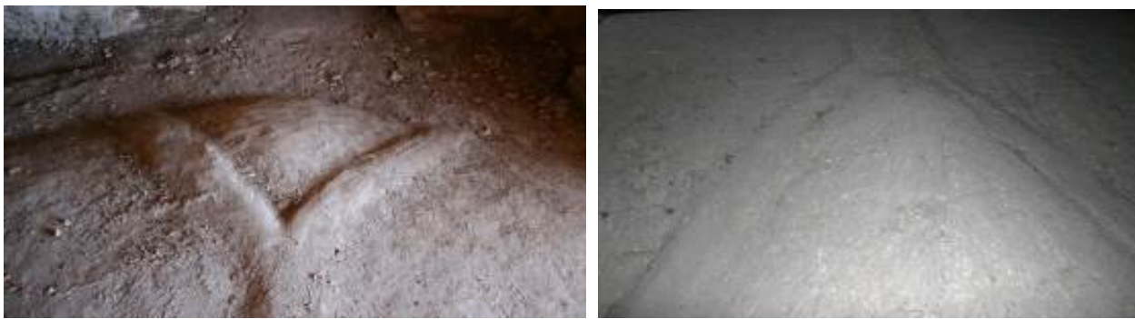
Fig.91 Església d'Algerri, juny 2014, i Església de Vinyols i els arcs, maig 2014, nervis de la lluneta regruixats per l'extradós.
