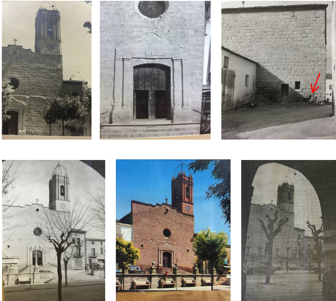
Fig.4 Fotos històriques de l'Arxiu Gavín. Humitats a la façana SE. Actualment aquests carreus s'han canviat.
