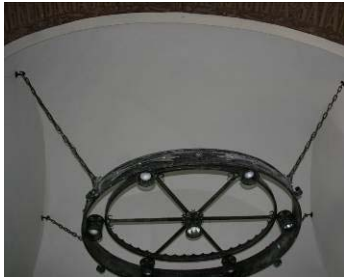
Crugia 1 nord-oest, reparada.
