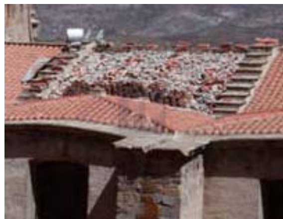
Fig.5 Fotografia de la façana lateral est de la Catedral. S'observa la coberta sobre la volta de rajola doblada. httpwww.alamy.com
