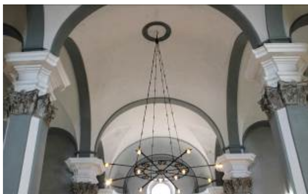
Fig. 76 Volta de mocador per a cobrir els trams de la nau central a les esglésies de Mont-roig del Camp i Guissona. Maig de 2014 i juliol de 2015 respectivament.
