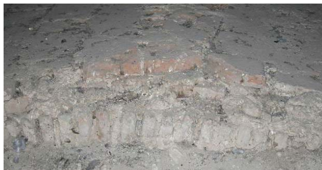
Fig.11 Església parroquial de Ginestar l'agost de 2014. Volta cavalca sobre els arcs formers i que és de dues voltes de rajola. Les influències del barroc francès van entrar amb la instal·lació de la monarquia borbònica, a través de la institució reial de l'Acadèmia Militar de Matemàtiques de Barcelona. Els mestres de cases del principat es formaven a l'acadèmia de Barcelona i posaven en pràctica els seus coneixements en els edificis parroquials. L'església de la Ciutadella de Barcelona, dissenyada el 1718 per l'enginyer flamenc Pròsper
