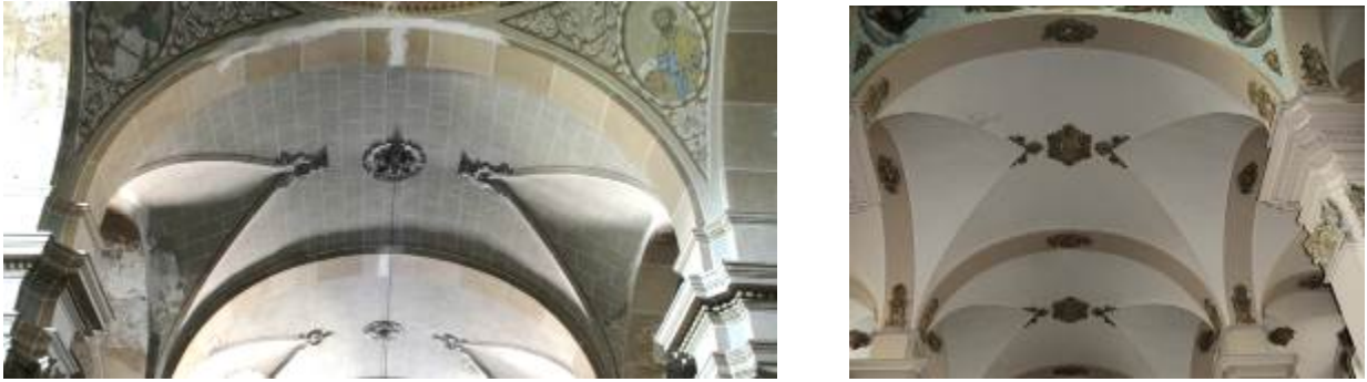
Fig.66 Església de Barberà de la conca, les llunetes ocupen la tercera part de la volta. Fotografies aig de 2014.
