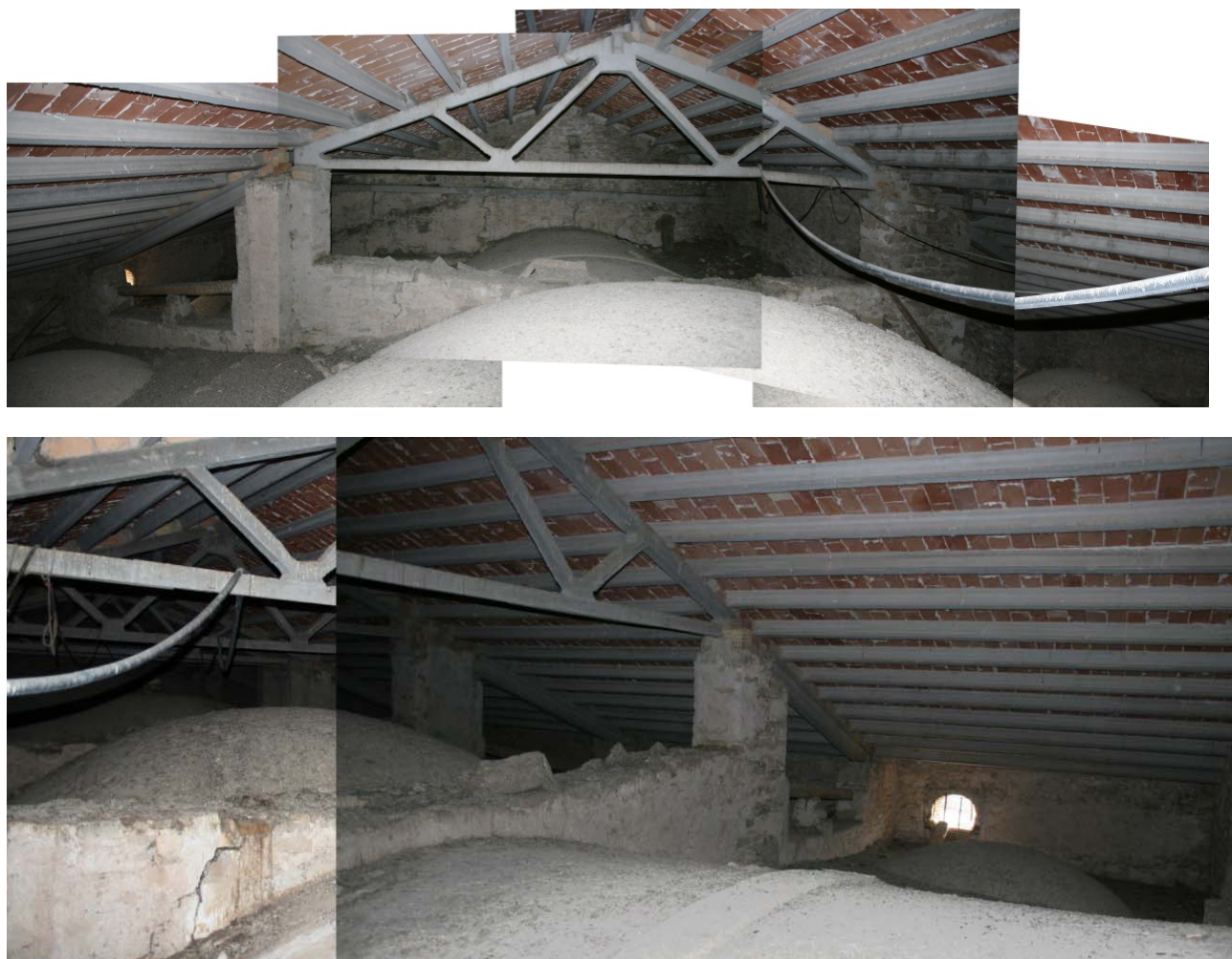
Fig.31 Imatges de l'extradós de les voltes.
