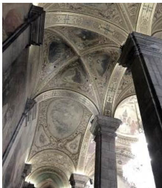
Fig. 73 Volta d'aresta a les naus laterals i de canó amb llunetes a les centrals de La Palma d'Ebre, Maldà i Vinyols i els Arcs. Octubre i maig de 2014.
