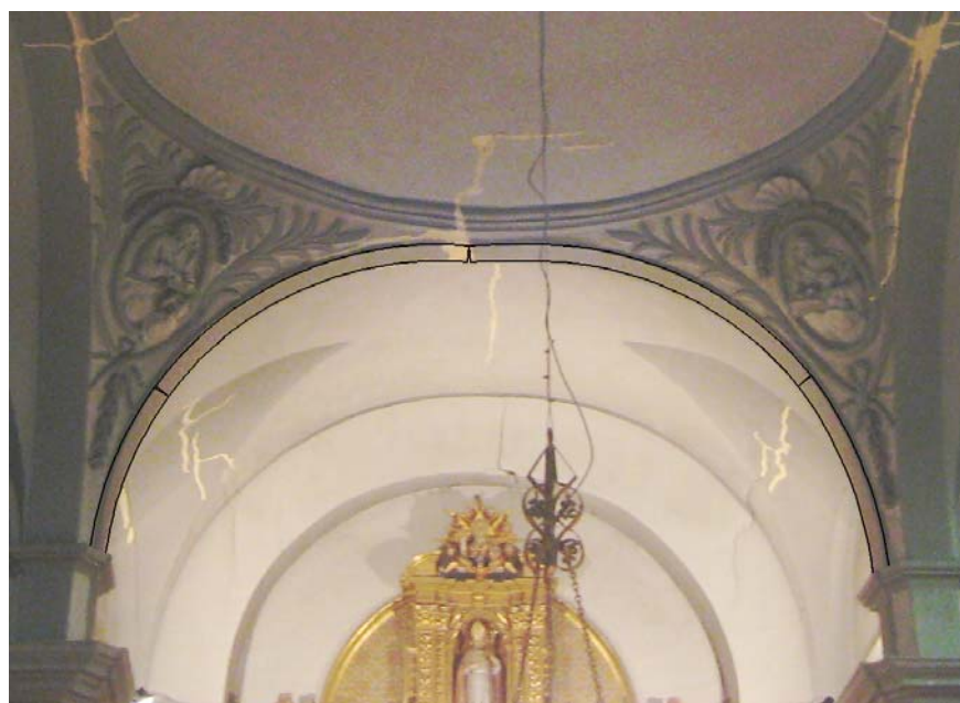
Fig.22 A l'esquerra arc former de la nau lateral i volta de la nau central. A la dreta arc i voltes de la nau central. Els arcs sobresurten respecte l'extradós de les voltes, i són de maó a sardinell. Fotografies proporcionades per Ramon Padullés.
