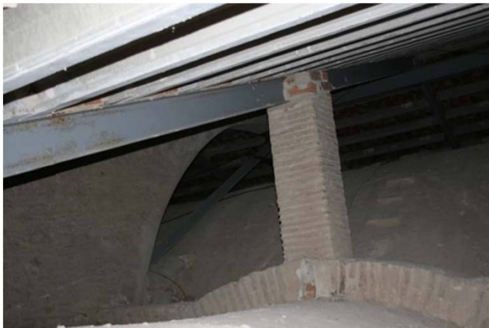
Fig.18 Pilastra sobre els arcs formers que recull pes de la coberta.
