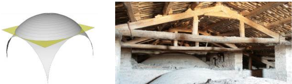
Fig. 79 Model d'una volta de mocador fent de cúpula. Extradós de la cúpula de mocador de Granyena de Segarra, juny de 2015.
