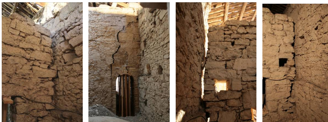
Fig.12 Imatges preses des de l'extradós de les voltes de mocador de la nau lateral sud-est.
