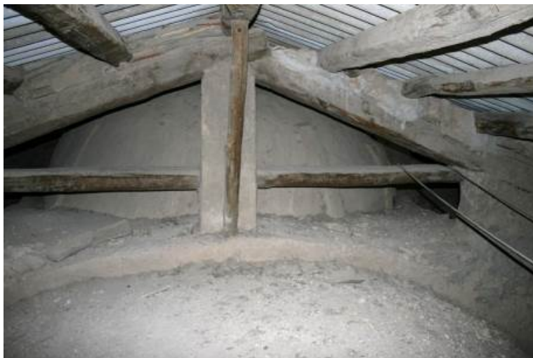
Fig.123 Rasquera, juny 2014. L'encavallada es recolza sobre els murs que hi ha damunt els arcs de les naus laterals.
