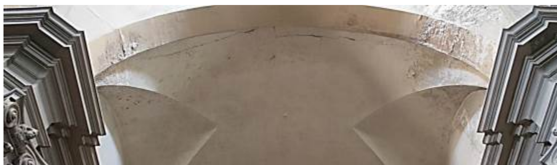
Fig. 98 Esquerdes paral·leles als arcs faixons però a certa distància d'ells a Falset, juny 2014.
