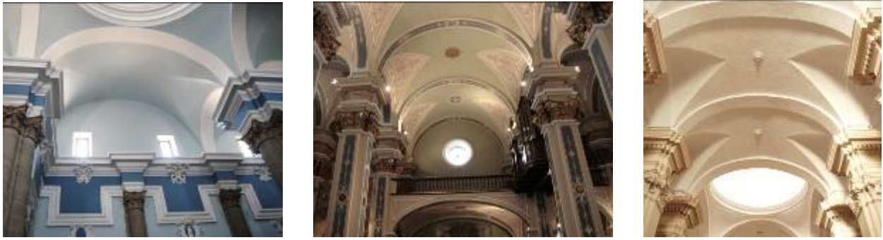
Fig.69 A l'esquerra volta de canó amb lluntes al creuer a l'església de Calaceit, s'observa com les lluntes són molt tímides i els arcs formers molt baixos. Les lluntes gairebé no trenquen la continuïtat del canó. Al centre volta de canó amb lluntes a l'església de l'Espluga Calba. Les lluntes gairebé no trenquen la continuïtat del canó. A la dreta volta de canó amb lluntes de El Cogul, on els arcs formers estan situats una mica més alts fent que el carener de les lluntes tendeixi més cap a la horitzontalitat. Fotografies preses l'agost de 2015, el juliol de 2015 i el juny de 2014 respectivament.
