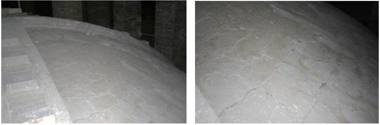
Fig.36 Extradós de les voltes a la catalana de la Catedral de Lleida, juliol de 2015.
