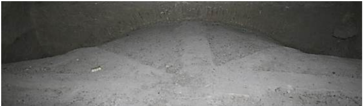
Fig.92 Església del Pla de Santa Maria, maig 2014, nervis regruixats per l'extradós.
