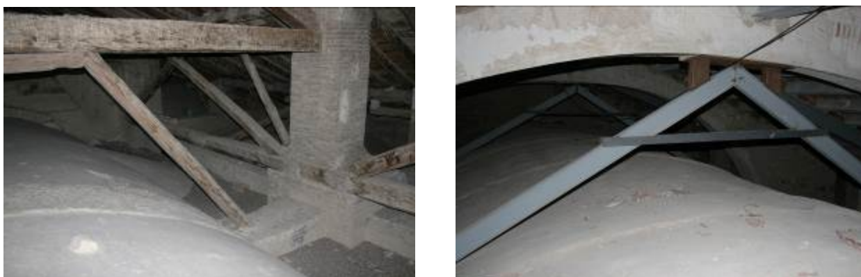
Fig. 96 Esquerdes a la clau de l'arc que es prolonguen cap a la volta. Extradós d'Alcañiz, agost 2015 (esquerra) i de Falset, juny 2014 (dreta).
