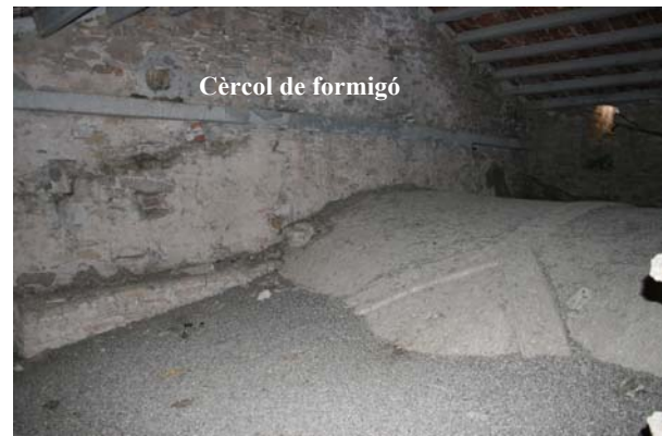
Fig.20 Fotografies de la volta de canó amb llunetes de la primera crugia d'accés a l'església. S'observa com el mur de façana es va estrebar per l'interior amb un cercol de formigó. S'observen les esquerdes verticals del mur.
