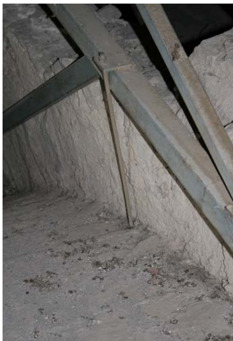
Fig.16 Geometria de la nau, planta sota-coberta. La fotografia mostra la solució de “penjar” els arcs.
