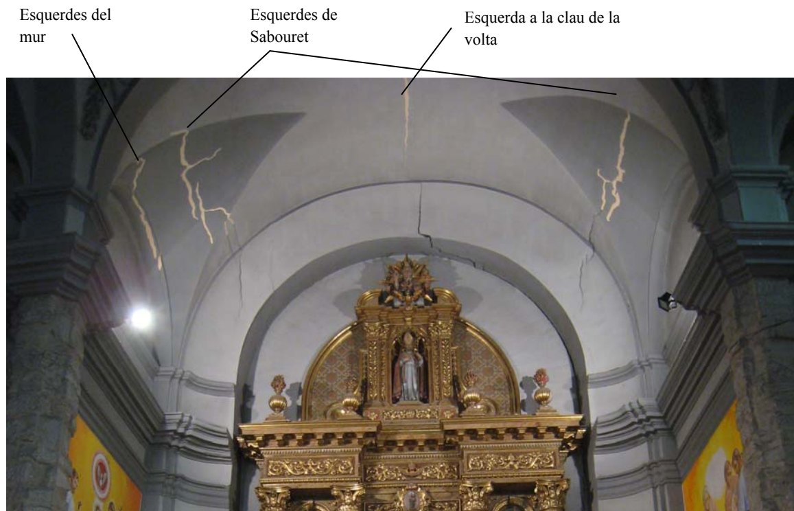
Fig.26 Esquerdas a la volta. Fotografia proporcionada per Ramon Padullés.
