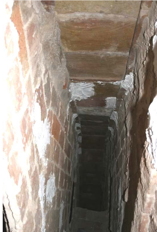
La coberta de taulers de fusta i teula sobre envanets
