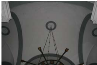
Esquerdas meridianes a la volta de mocador del creuer.
