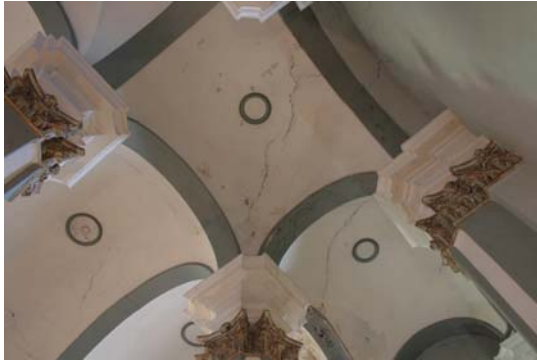
Esquerdas a la nau lateral est, corresponents al desplaçament del campanar en sentit nord-est.
