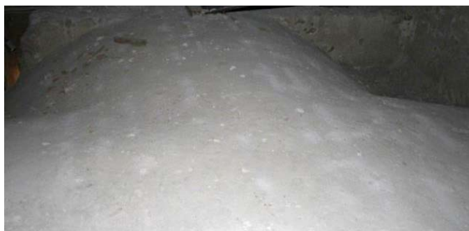
Fig.25 Voltes de Falset, amb una capa de compressió de formigó.
