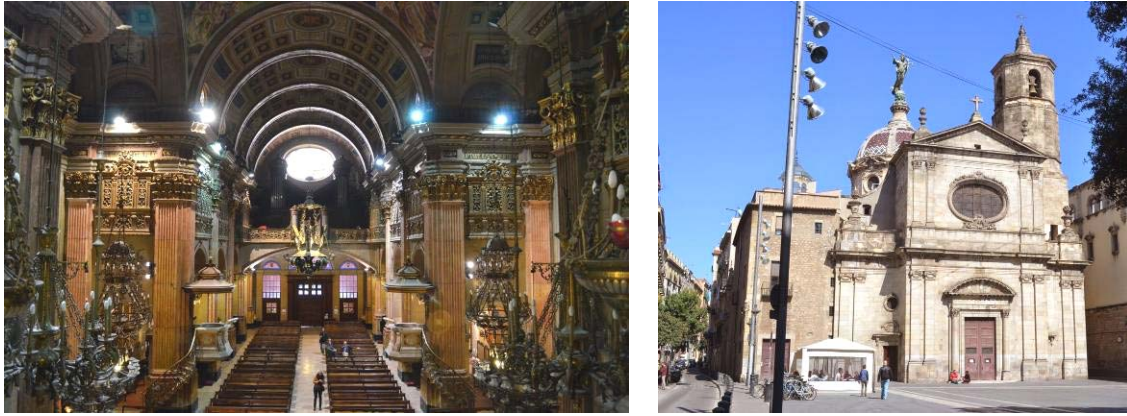
Fig.3 Interior de l'església de la Mercè amb les voltes de canó.
