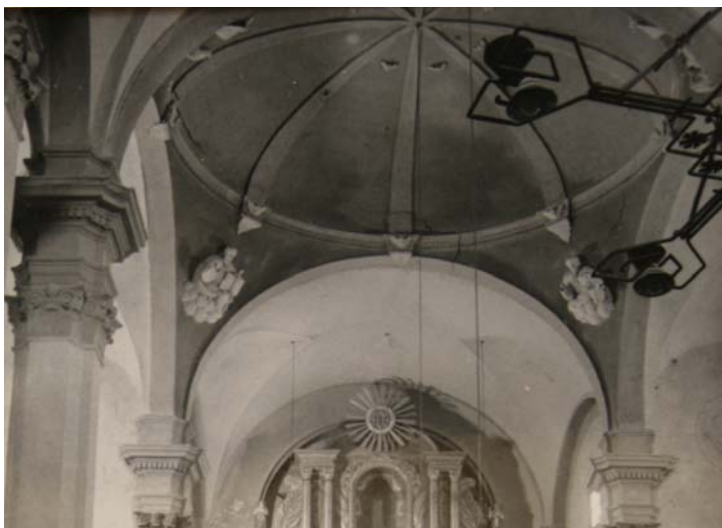
Fig.6 Volta de mocador del creuer i volta del presbiteri, 1978. Arxiu Gavín.
