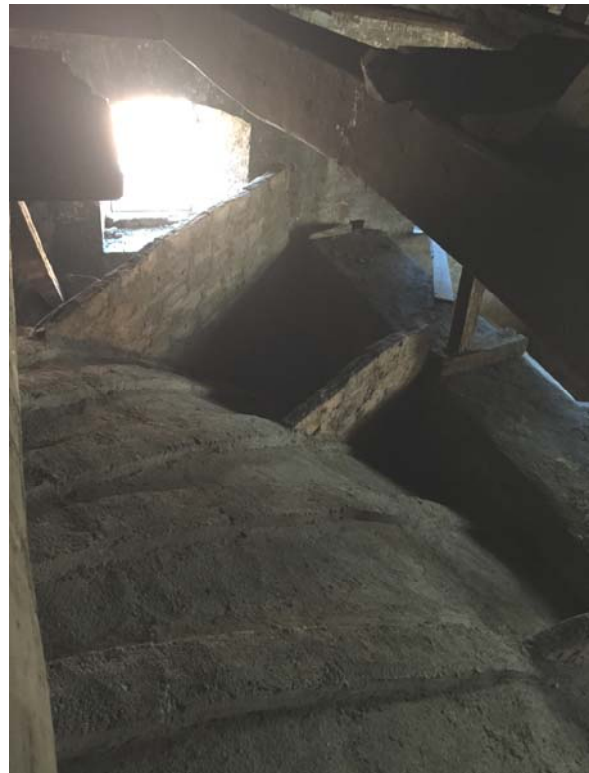
Fig.138 Diverses fotografies de l'extradós de les voltes de la Catdral de Bogotà. Desembre de 2015.
