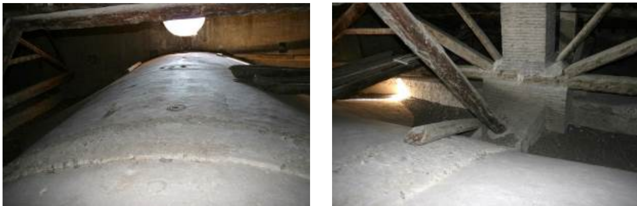
Fig.24 Voltes de maó vistes per l'extradós a la Col·legiata d'Alcañiz, a l'agost de 2015.
