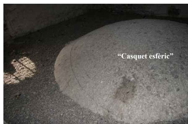
Fig.17 Les esquerdes anteriors vistes des de l'extradós de les voltes. També s'observen les llengüetes.
