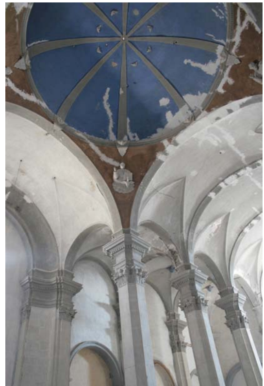
Fig.12 Esquerdes a les voltes de la nau.
