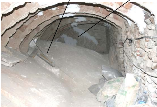
Fig.14 Elements que configuren l'extradós de les voltes.
