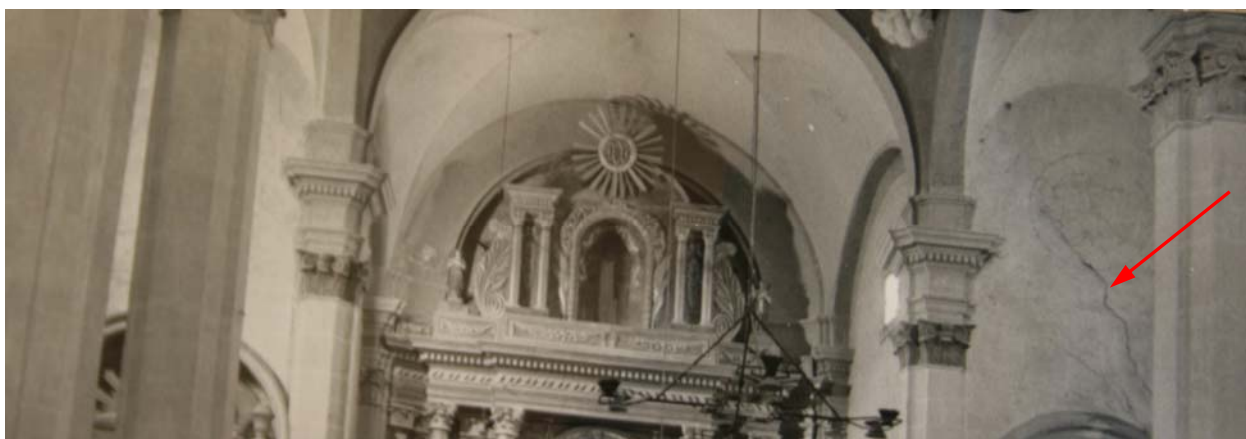
Fig.9 Detall de la volta del presbiteri el 1978. Arxiu Gavín. S'observa una esquerda a 45° al mur .
