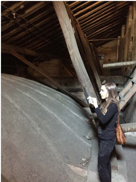
Fig.138 Diverses fotografies de l'extradós de les voltes de la Catdral de Bogotà. Desembre de 2015.
