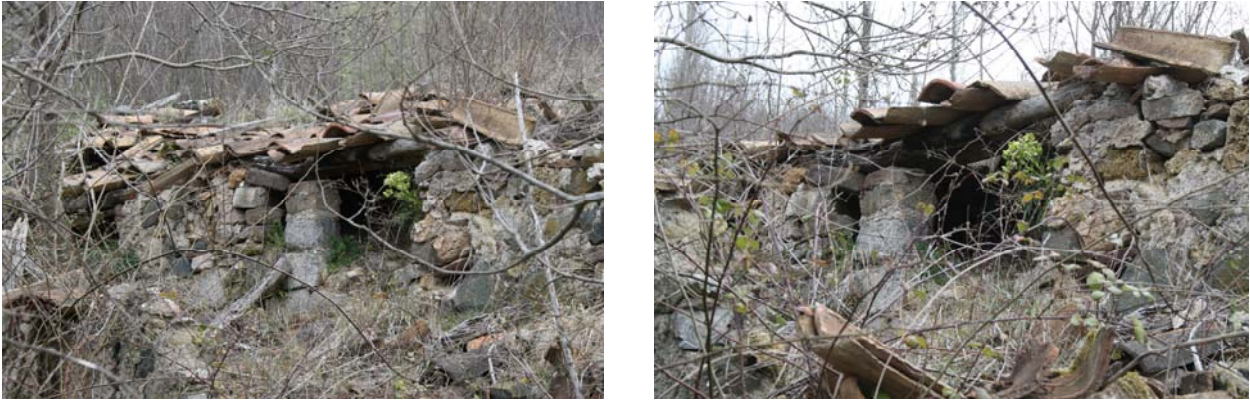
Fig. 21 Fotografies de les pilastres de coberta
