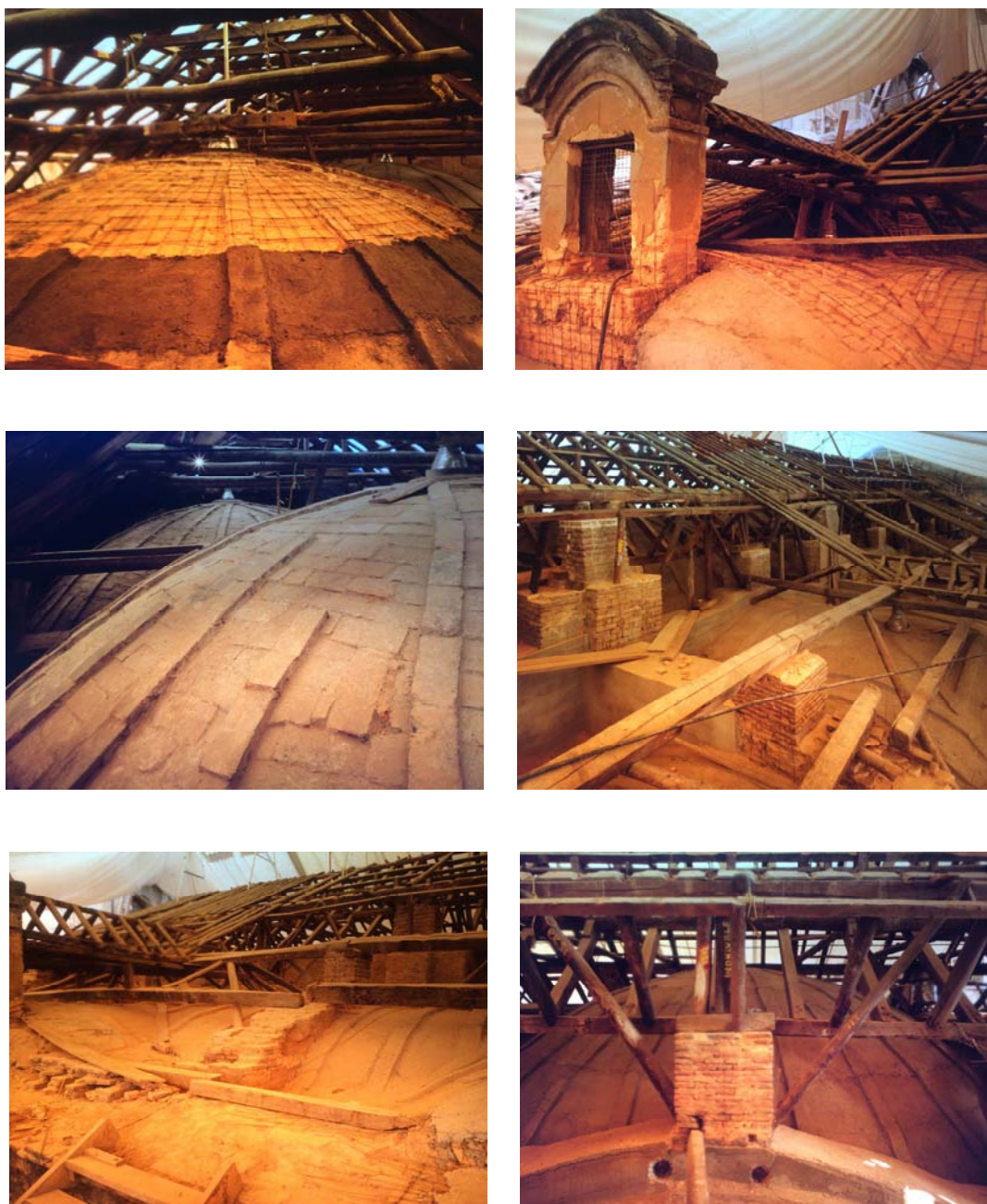
Fig.135 Diverses fotografies de la rehabilitació de l’extradós de la Catedral de Bogotà. Arxivo Histórico Diocesano de Bogotà.
