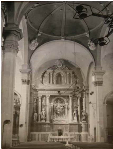
Fig.6 Volta de mocador del creuer i volta del presbiteri, 1978. Arxiu Gavín.
