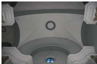
Esquerdas a la nau lateral est, corresponents al desplaçament del campanar en sentit nord-est.
