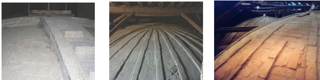
Fig.11 Nervis radials a la Catedral de Lleida (esquerra) (que serveixen per a circular per l'extradós), i a la Catedral de Bogotà.
