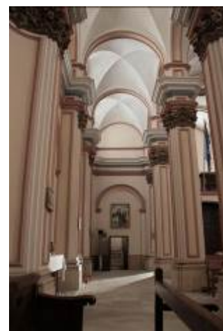
Fig. 71 Model de volta d'aresta i imatges de la volta d'aresta de l'església de la Cerollera, agost de 2015.
