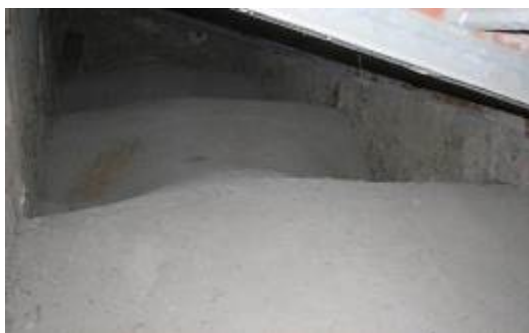
Fig.93 Voltes Algerri, juny 2014, amb capa de formigó Fig94 Voltes de Falset, juny 2014, amb una capa de compressió de formigó.
