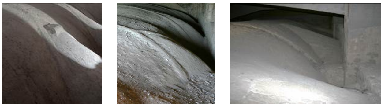
Fig. 65 A l’esquerra (Barberà de la Conca) s’observa com la lluneta és cònica i recta. Al centre (Algerri) s’observa com la lluneta és bombada. En el cas d’Algerri (dreta) els arcs formers es troben més elevats. A la dreta llunetes de El Cogul vistes des de l’extradós, s’observa com són molt rectes i gens inclinades. Fotografies de maig, juny i juny de 2014 respectivament.
