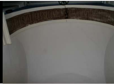
Crugia 6 nord-oest, reparada.
