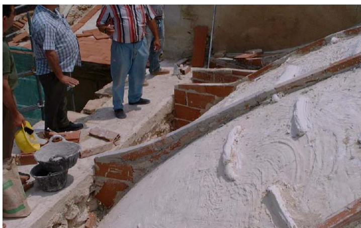
Fig.12 Volta barroca del presbiteri de l'església de Canet lo Roig restaurada per l'arquitecte Francisco Jurado. Font: JURADO, F., 1998. Restauración de la cúpula, bóvedas del crucero y cubiertas de la iglesia de San Miguel Arcángel en Canet Lo Roig. Castellón.
