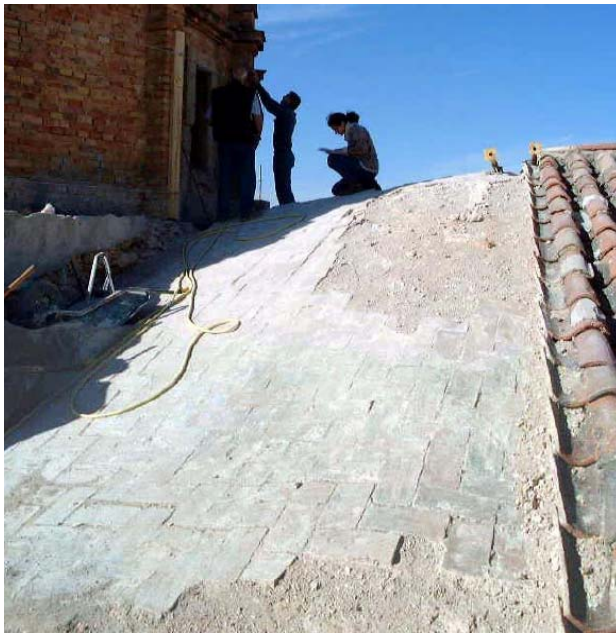
Fig.4 Coberta original de rajola que va aparèixer en retirar les teules de la nau principal gòtica. A JURADO, F., 1998. Restauración de la cúpula, bóvedas del crucero y cubiertas de la iglesia de San Miguel Arcángel en Canet Lo Roig. Castellón.
