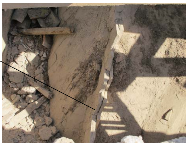
Fig.29 Llengüeta a l'extradós de les voltes. Fotografia cedida per Ramon Padullés.
