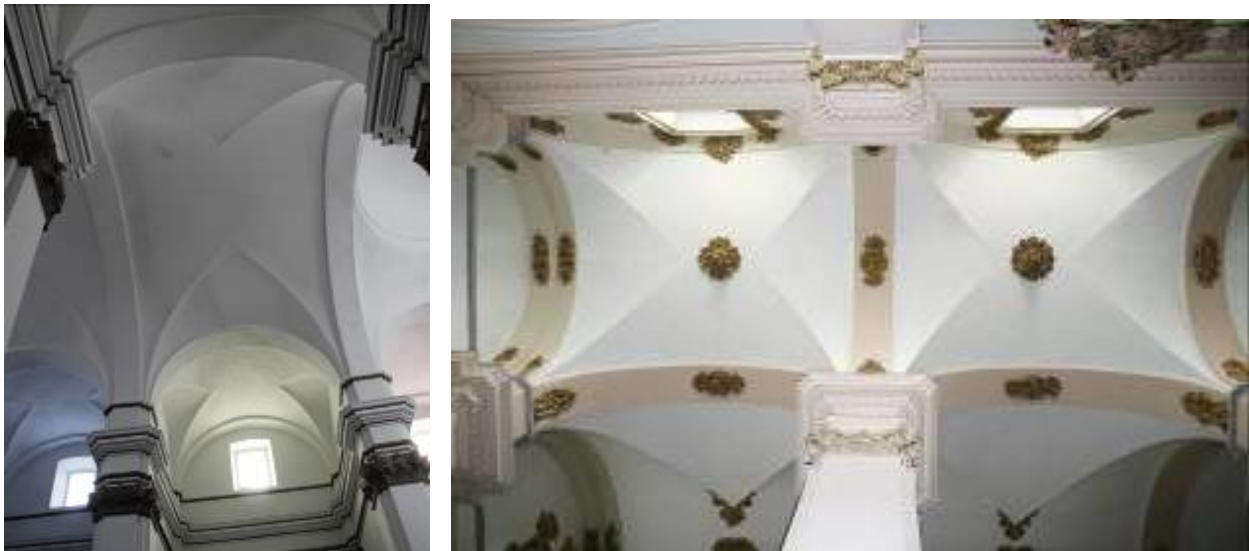
Fig.70 volta de canó amb lluntes a l'església de Rasquera (esquerra), el juny de 2014, i a l'església de Batea., el maig de 2014. S'observen les voltes de canó amb lluntes situades també a la nau lateral, les lluntes són molt avançades i fa la impressió de voltes d'aresta.
