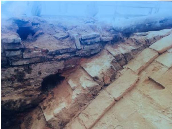
Fig.137 Diverses fotografies de la rehabilitació de l'extradós de la Catedral de Bogotà. Arxivo Histórico Diocesano de Bogotà
