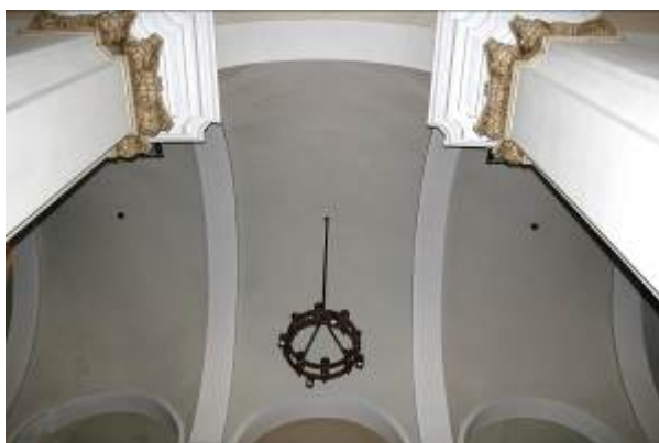
Fig. 76 Volta de mocador per a cobrir els trams de la nau central a les esglésies de Mont-roig del Camp i Guissona. Maig de 2014 i juliol de 2015 respectivament.
