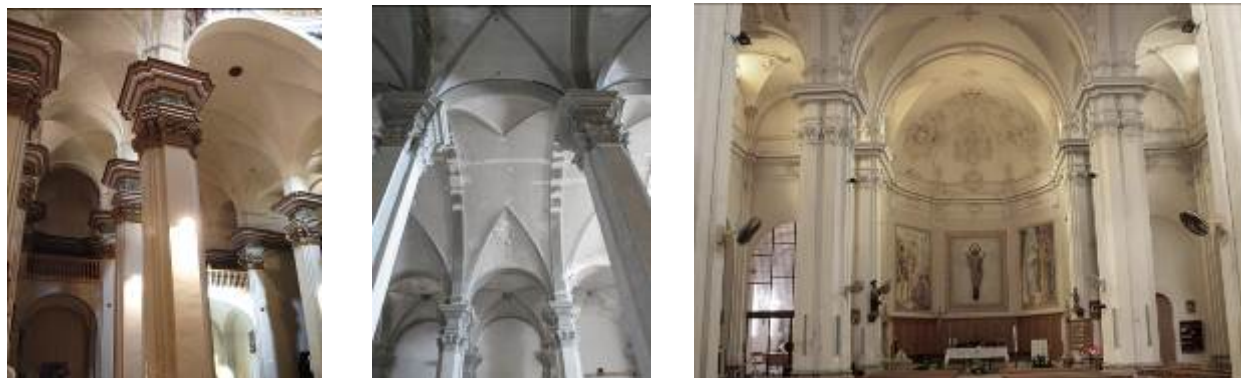
Fig. 73 Volta d'aresta a les naus laterals i de canó amb llunetes a les centrals de La Palma d'Ebre, Maldà i Vinyols i els Arcs. Octubre i maig de 2014.
