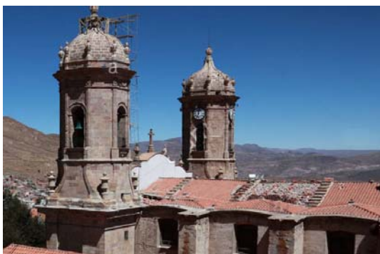
Fig.5 Fotografia de la façana lateral est de la Catedral. S'observa la coberta sobre la volta de rajola doblada. httpwww.alamy.com
