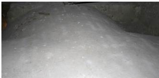
Fig.93 Voltes Algerri, juny 2014, amb capa de formigó Fig94 Voltes de Falset, juny 2014, amb una capa de compressió de formigó.
