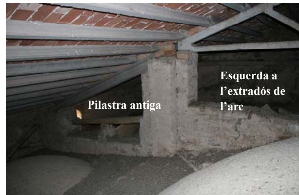
Fig.21 Llengüeta de la volta de mocador del creuer (esquerra), a la dreta configuració de la coberta actual, amb les restes de la pilastra central que sosté una bigueta de fusta corresponent a una coberta anterior.
