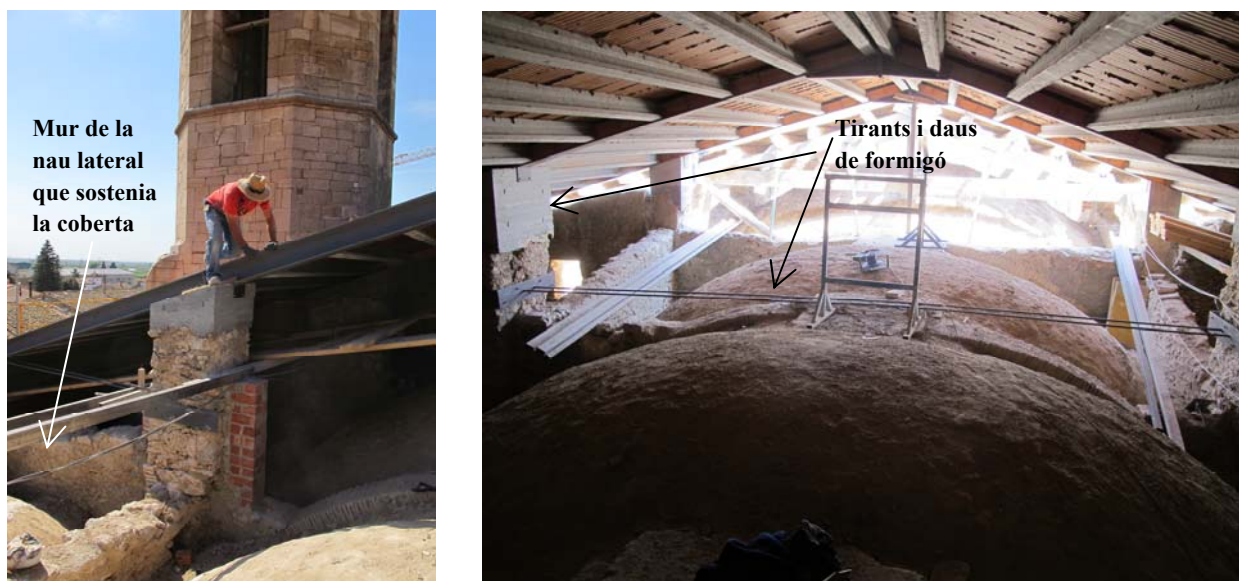
Fig.2 Execució de les obres el 2011. Font: Ramon Padullés.
