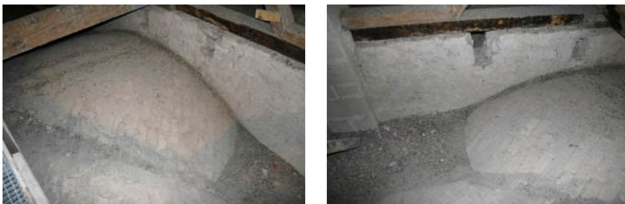
Fig.32 Vista de l'extradós de les voltes a la catalana de la Capella de la Universitat de Cervera, juliol de 2015.
