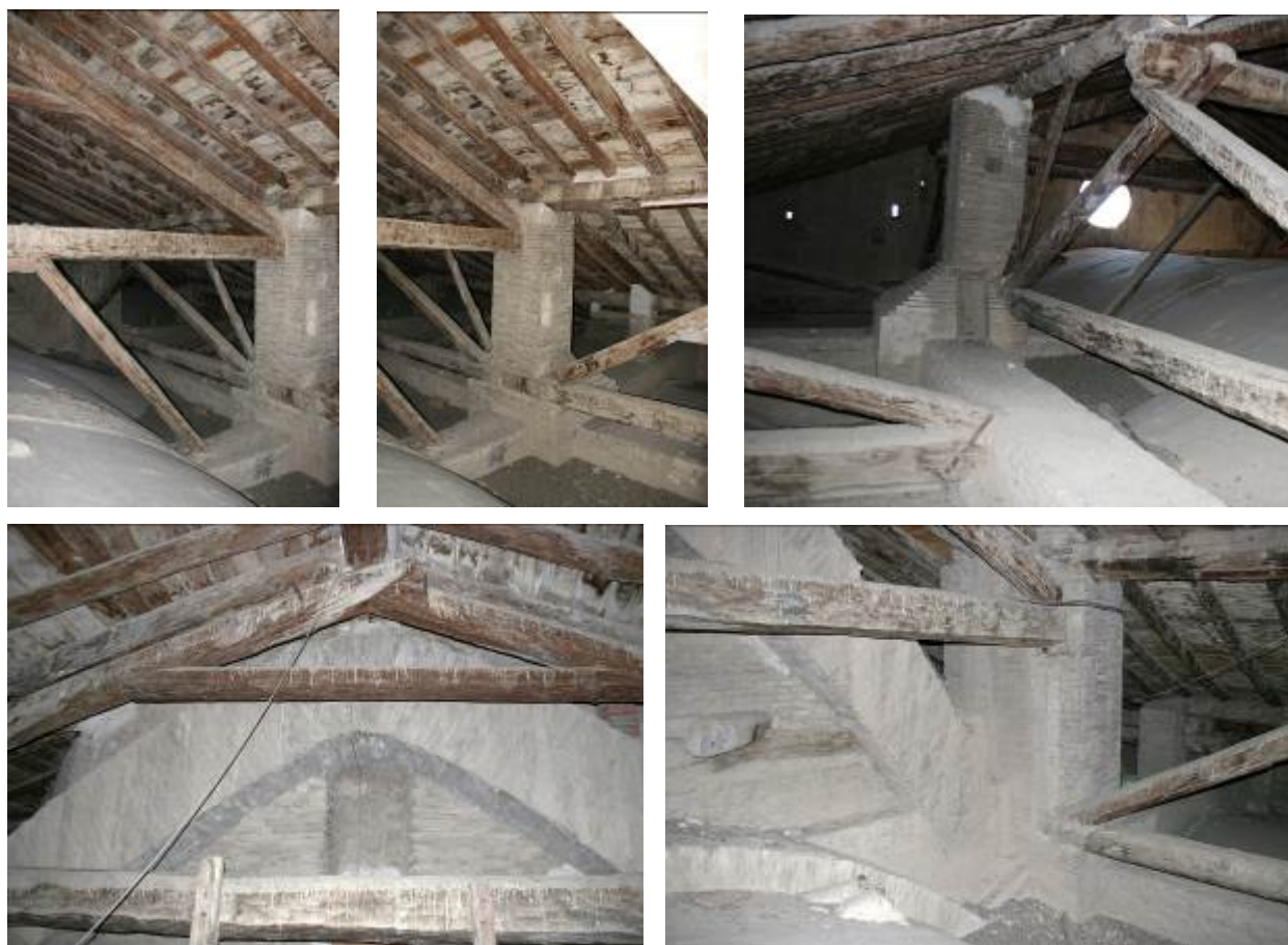
Fig.117 Extradós de la Col·legiata d'Alcañiz, agost 2015. S'observen les pilastres sobre les quals recolzen les encavallades de la coberta. Aquestes encavallades tenen tornapuntes que recolzen al replè dels ronyons. Per a la formalització de la cúpula, que és una volta de mocador, es construeix una doble entramada d'arcs sobre els arcs torals.
