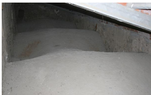
Fig.24 Voltes d'Algèria amb una capa de formigó
