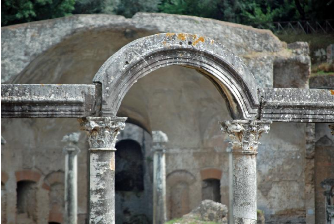
Fig. 155: Detalle de la logia del Canopo de villa Adriana, Tivoli (autor).
