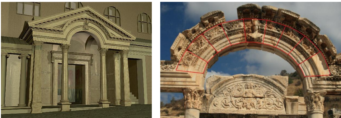
Fig. 120: a) Reconstrucción ideal (Quatember 2013, fig. 9) y b) esquema del dovelaje (esquema del autor) del templo de Adriano, Éfeso.
