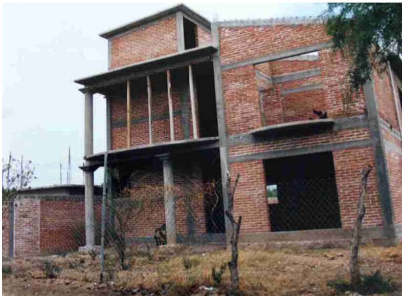
Casa de trabajadores migrantes a los E.U.A., en construcción en Guelavía
