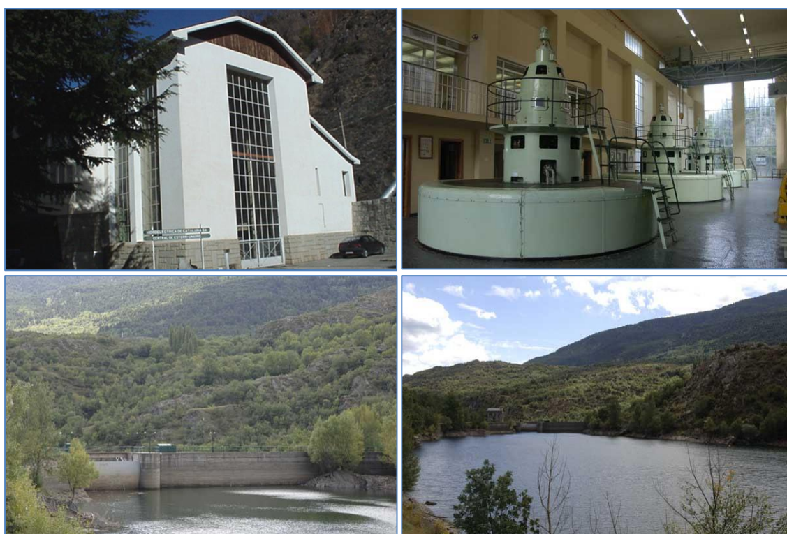
Figura 10. Edificio principal de la central hidroeléctrica de Esterrri-Unarre y sus tres turbinas Francis. Las dos imágenes inferiores muestran el embalse de Borén desde dos puntos de vista diferentes. Fotografías facilitadas por ENDESA.
