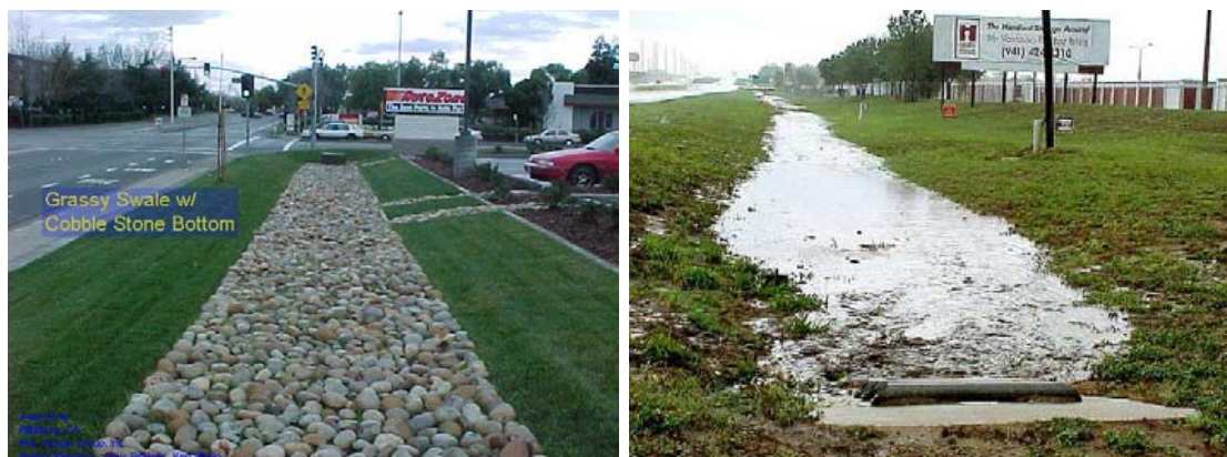
Figura I-2. Ejemplos de bandas verdes. Drenaje sostenible
