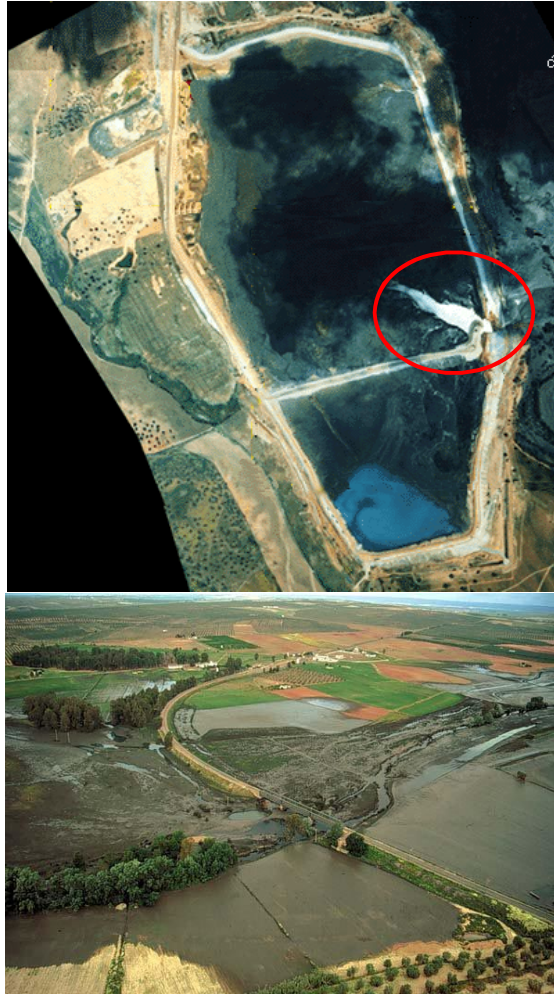
Figura 21. Vista aérea de la balsa de decantación afectada en Aznalcóllar. Vista del avance de los lodos (abajo).
