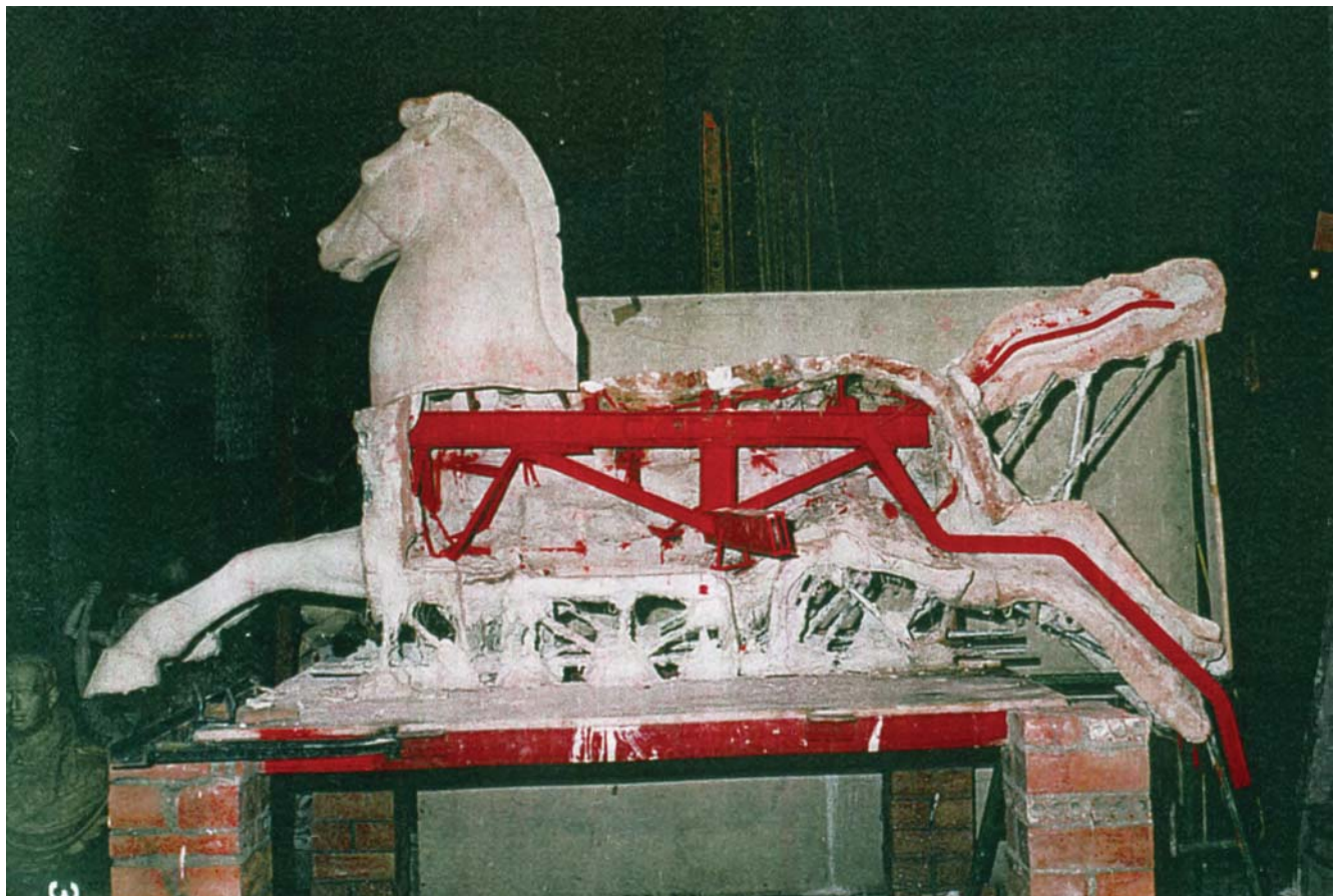
▷▽812 y 813. Estructuras interiores de hierro para soportar el modelo de yeso, Pau Gargallo, 1989. Barcelona
