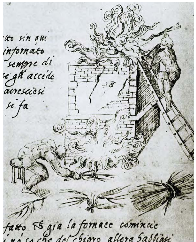
△745 y 746. Horno Italiano del S. VI, dibujo de Los tres libros del arte del ceramista de Cipriano
