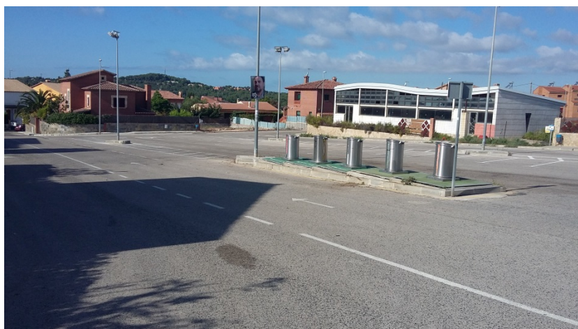
Doc. 52: Explanada de asfalto con equipamiento abandonado a medio construir al fondo. Fuente: elaboración propia
