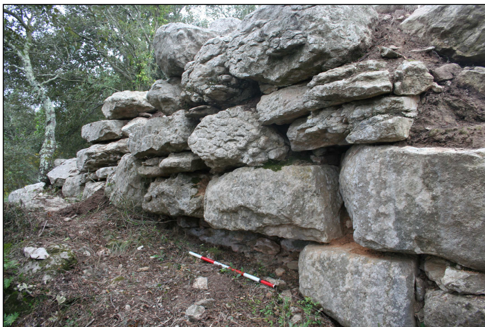
Fig. 75. Imatge de la fonamentació de la Torre de Puig d'Àlia (Amer, la Selva), directament sobre la roca mare (Padrós 2016b, fig. 3).
