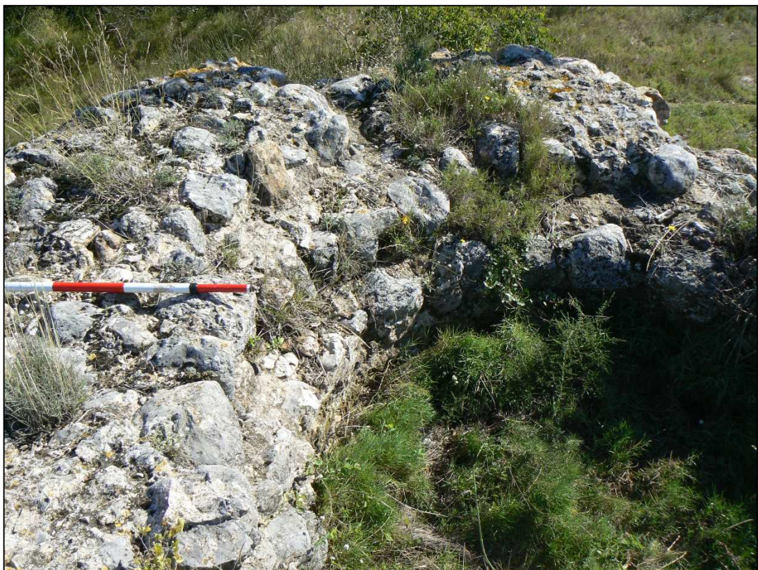
Fig. 81. Imatge de la torre del Castellot d'Avinyonet de Puigventós (Avinyonet de Puigventós, L'Alt Empordà).
