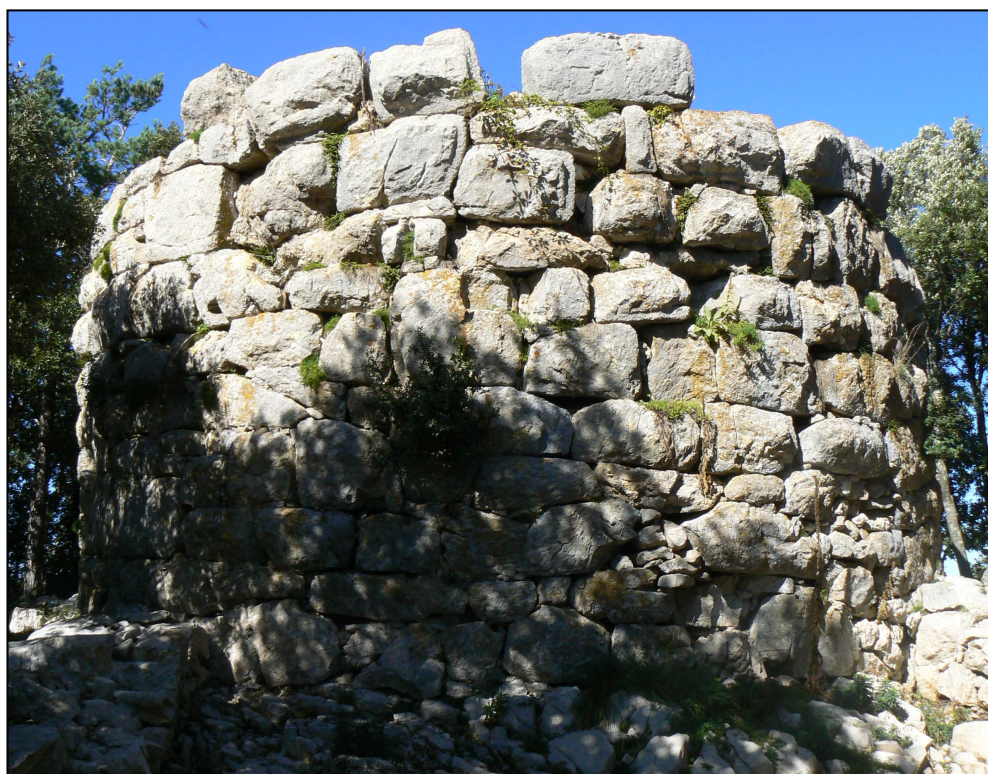
Fig. 79. Imatge de la torre del Castell de Falgars (Beuda, La Garrotxa), amb el seus grans carreus i l'encoixinat d'alguns d'ells.
