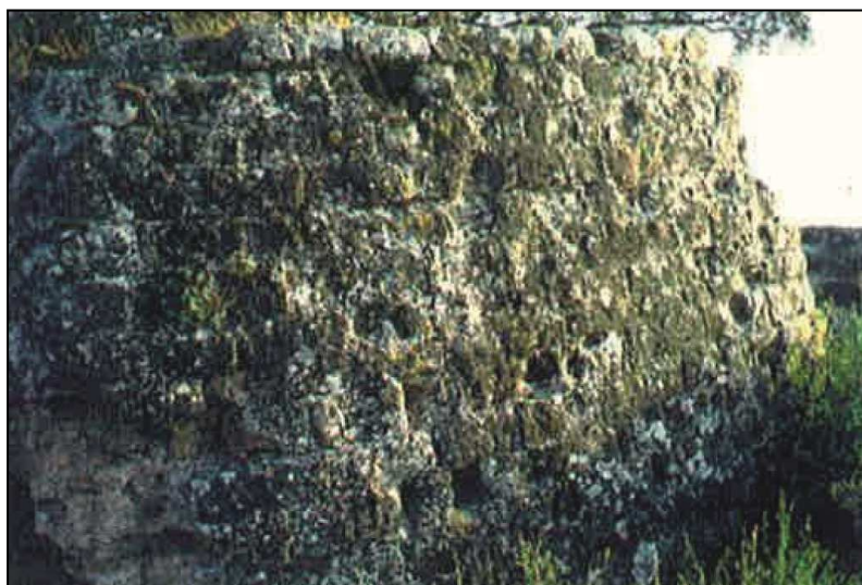
Fig. 32. Imatge de l'aparell constructiu a partir d' opus vittatum de la torre del Castell de Ponts (Ponts, La Noguera) (Navarro et al. 2000, fig. 15).
