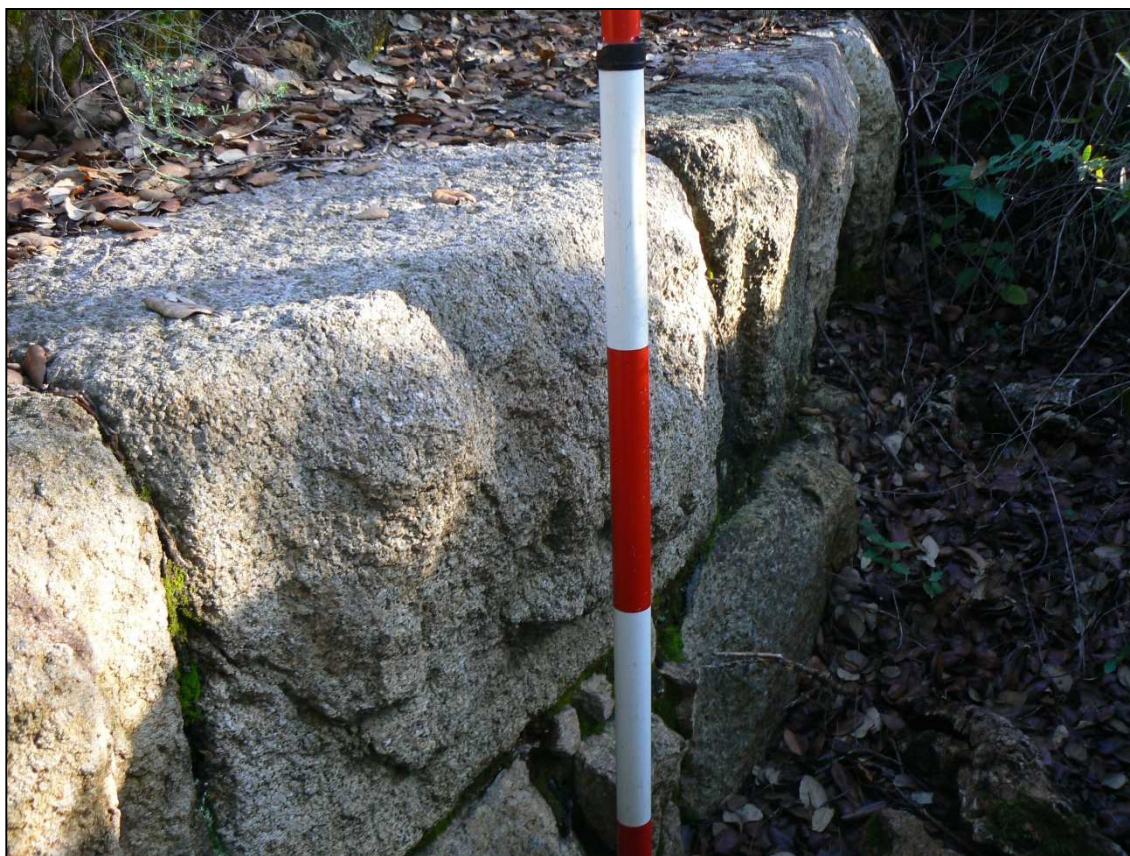
Fig. 72. Imatge de detall de la fonamentació de la Torre de la Mora (Sant Feliu de Buixalleu, La Selva) a base de dues filades de carreus de granit encoixinats.
