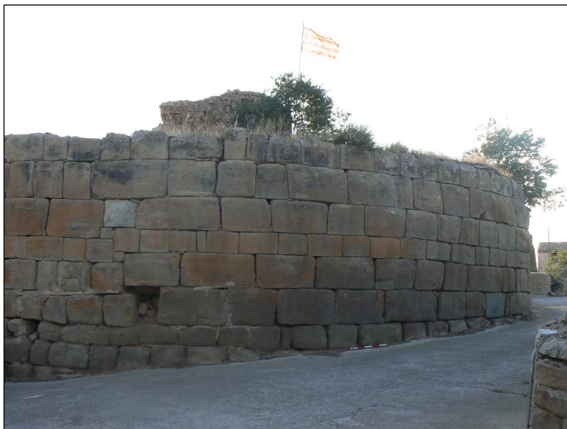
Fig. 28. Imatge del parament extern del Castell Lliuró (Ossó de Sió, L'Urgell), a partir dels seus grans carreus.
