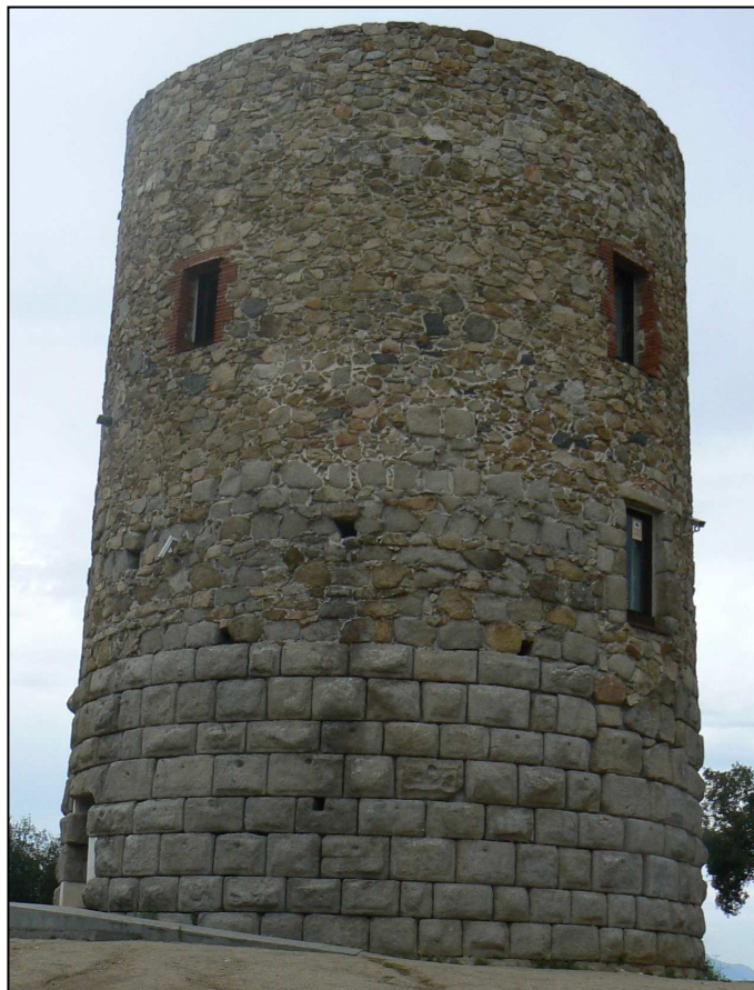
Fig. 67. Imatge de la Torrassa del Moro (Llinars del Vallès, Vallès Oriental) des del sud. S'aprecien les nou filades de carreus encoixinats a la part inferior.
