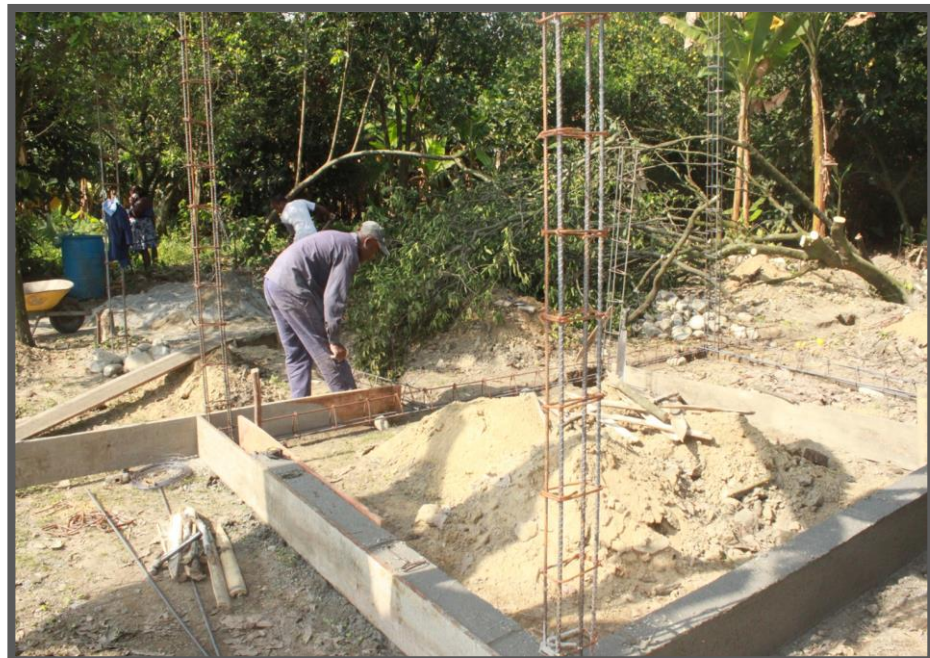
Inicios de la construcción de una vivienda con la remesa obtenida en Catalunya. Norte del Cauca, julio de 2013.
