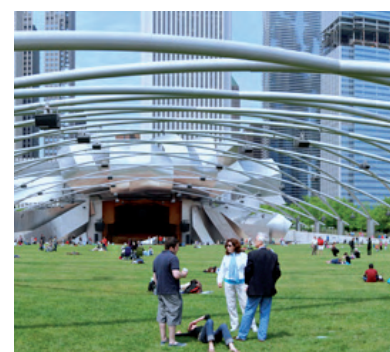
F.25. Cubrición del Millennium Park de Chicago, diseñada por SOM Architects (Skidmore, Owings & Merrill) en 1999-2002.
