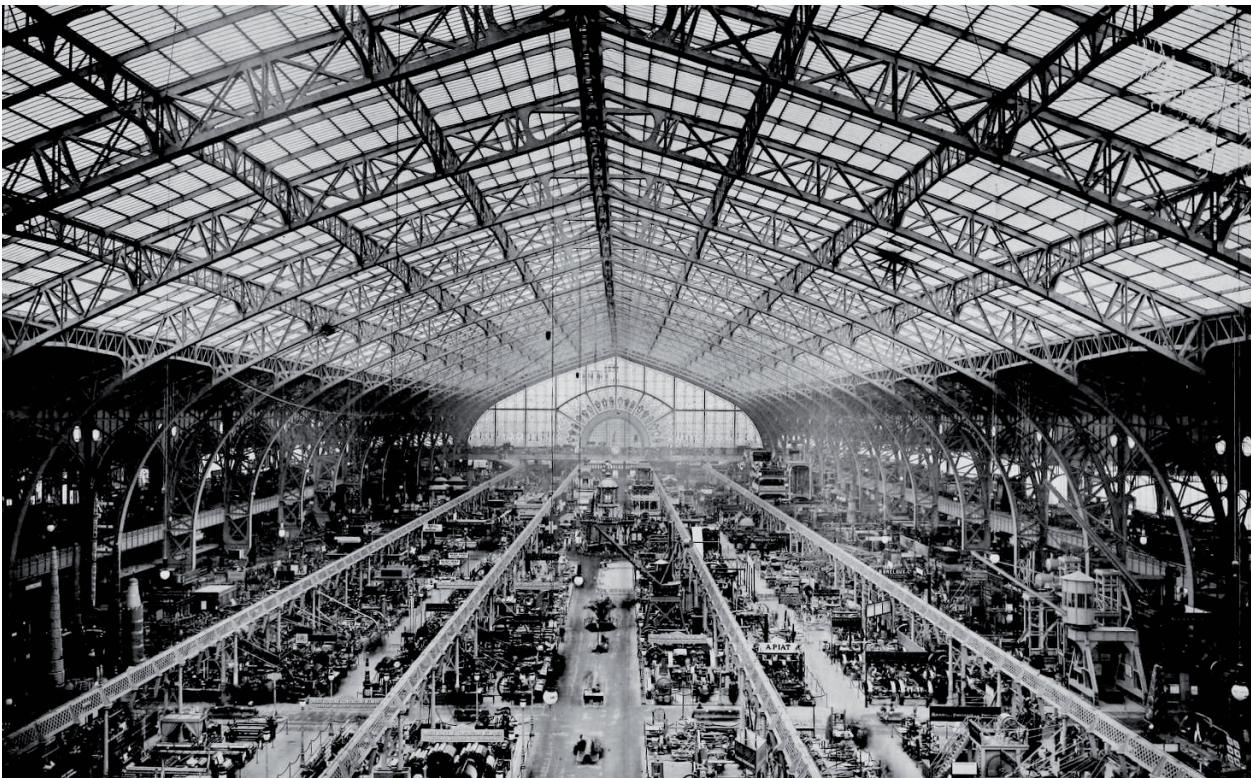
F.12. Interior de la gran nave central del Palais des Machines con la maquinaria expuesta.
