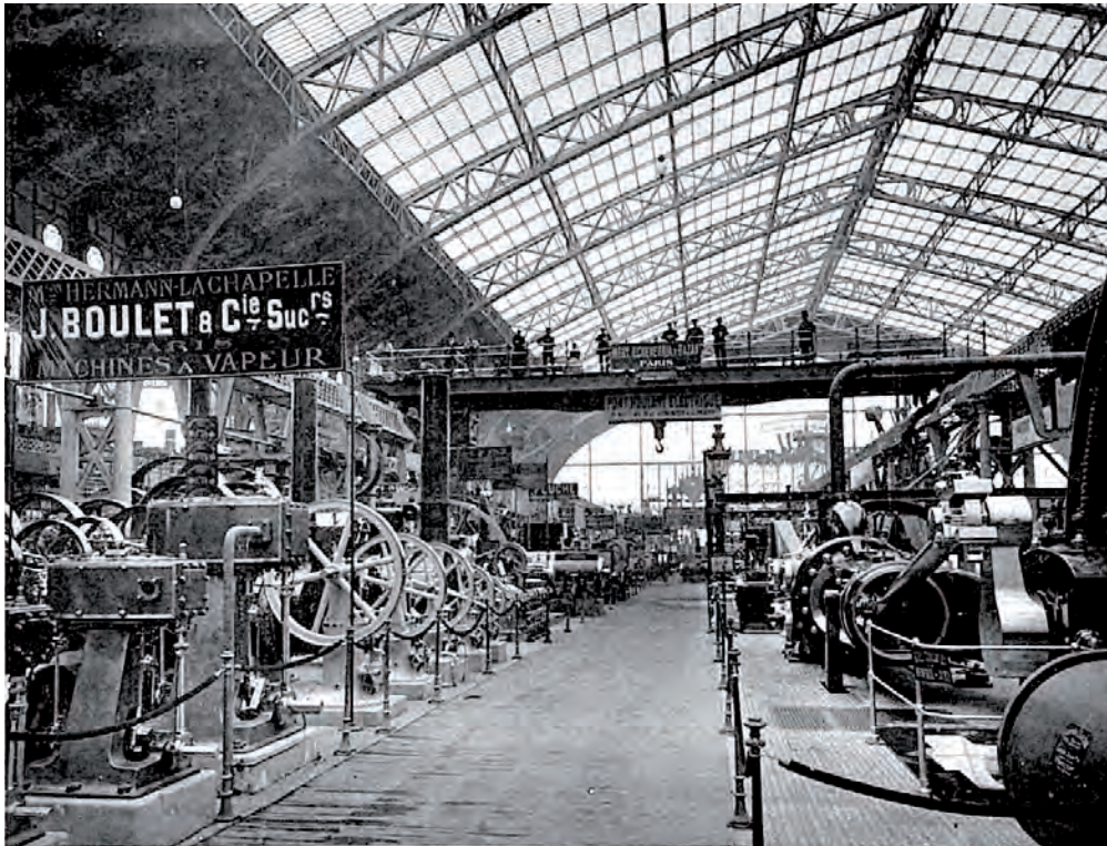
F.26. Nave central vista desde la planta baja. La ausencia de sombras arrojadas se debe al carácter difuso de la luz, obtenido por el estriado interior y el blanqueado del vidrio de cubierta. http://expos-expos.blogspot.co.uk
