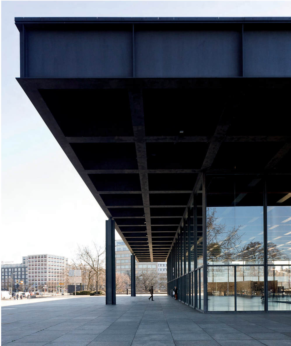
F.23. El porche como proyección del plano de cubierta más allá del cerramiento. www.markushattwig.de
