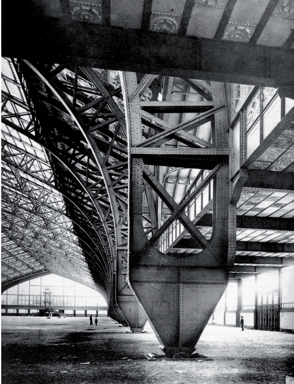
F.17. Visión del apoyo del pórtico sobre la articulación inferior. STAMPER, John, W.: The Galerie des Machines of the 1889 Paris world's fair . En THORNE, Robert (ed): Structural Iron and steel, 1850-1900 . Aldershot: Ashgate, 2000, p. 263
