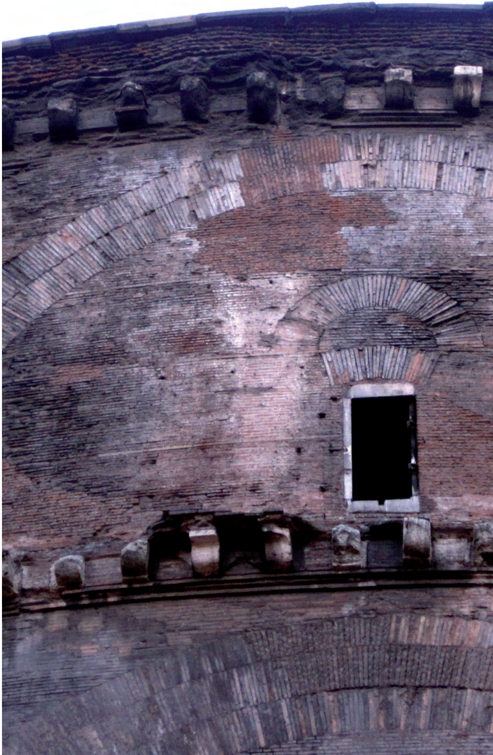
F.65. Arcos de descarga del muro exterior del Pantheon. Fotografía del autor.
