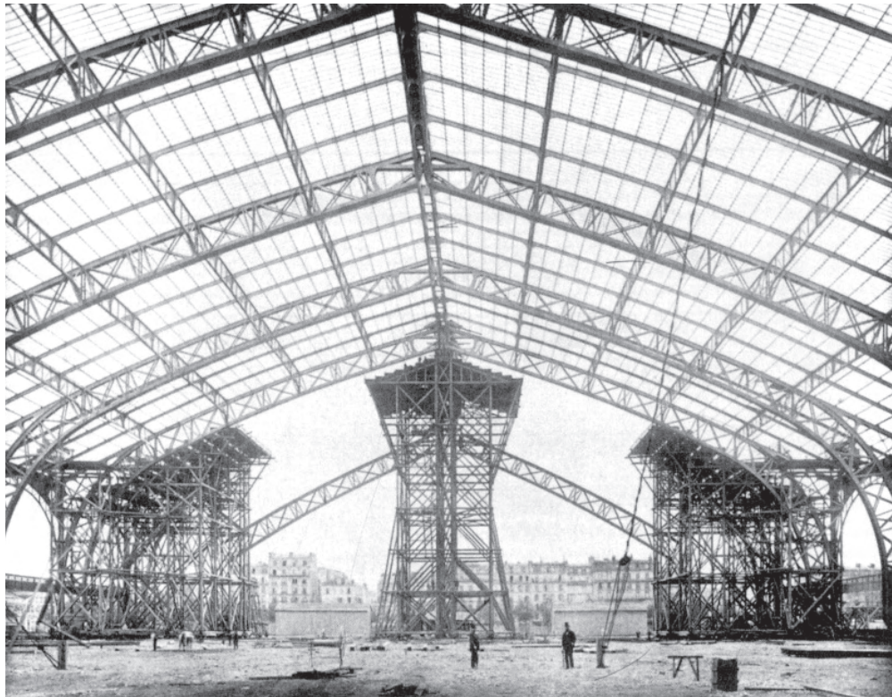
F.22. Espacio abierto definido por la sola estructura, abierta y permeable a la luz. Imagen tomada durante la construcción de la gran nave central. GIEDION, Sigfried: Building in France, building in iron, building in ferro-concrete . Santa Monica: Getty Center for the History of Art and the Humanities, 1995, p. 70
