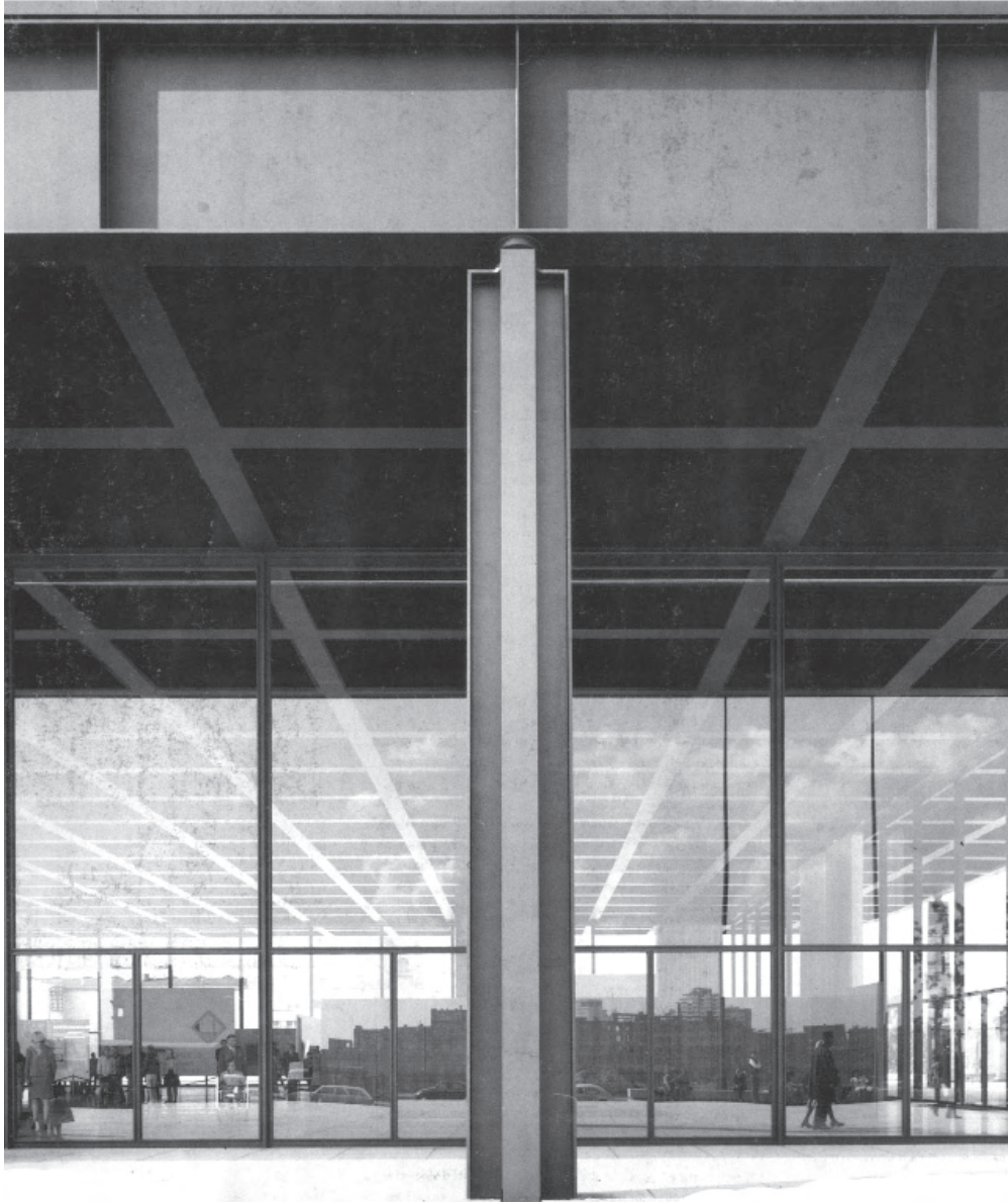
F.37. Unidad estructural abstracta formada por un entablamento moderno y una columna sin basa ni capitel. VANDENBERG, Maritz: New National Gallery, Berlin: Ludwig Mies van der Rohe . London: Phaidon, 1998, p. 15
