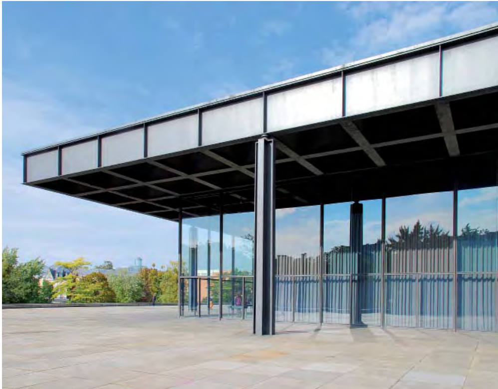
F.57. Imagen reflejada en el cristal. La sombra proyectada por la cubierta y la presencia de las cortinas potencian el reflejo. www.flickr.com
