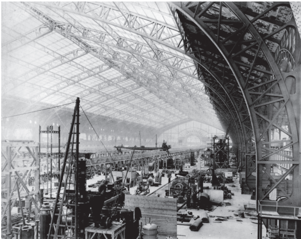
F.31. Contraste entre la luminosidad de la cubierta central acristalada y la oscuridad de la cubierta opaca lateral. www.loc.gov/pictures
