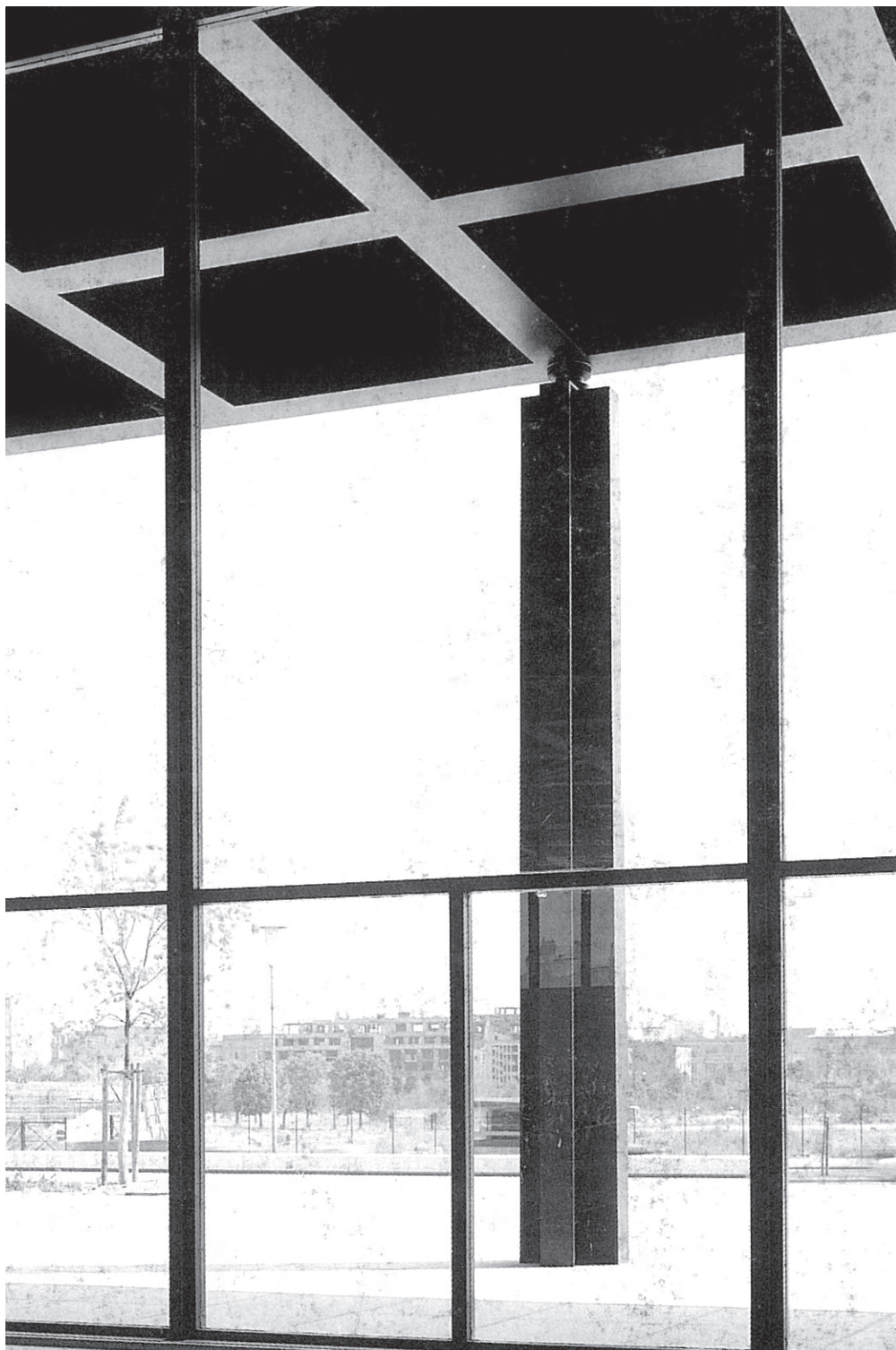
F.45. Imagen del pilar desde el interior del recinto acristalado.
