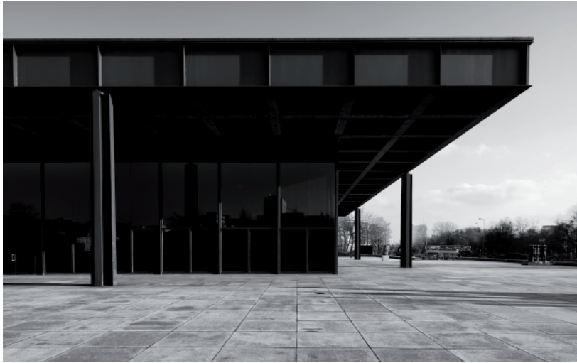
F.43. Esquina en voladizo de la Neue Nationalgalerie. www.flickr.com (Johannes Lietz)
