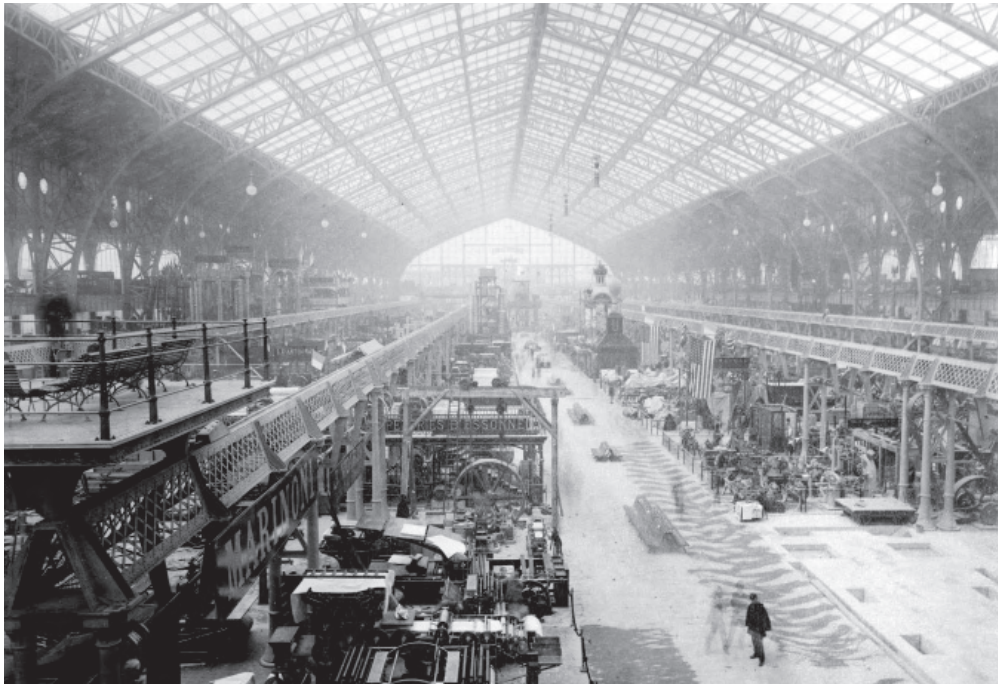
F.30. Visión axial de la nave central desde la planta primera. Espacio de luz difusa en ausencia de sombras arrojadas. www.loc.gov/pictures
