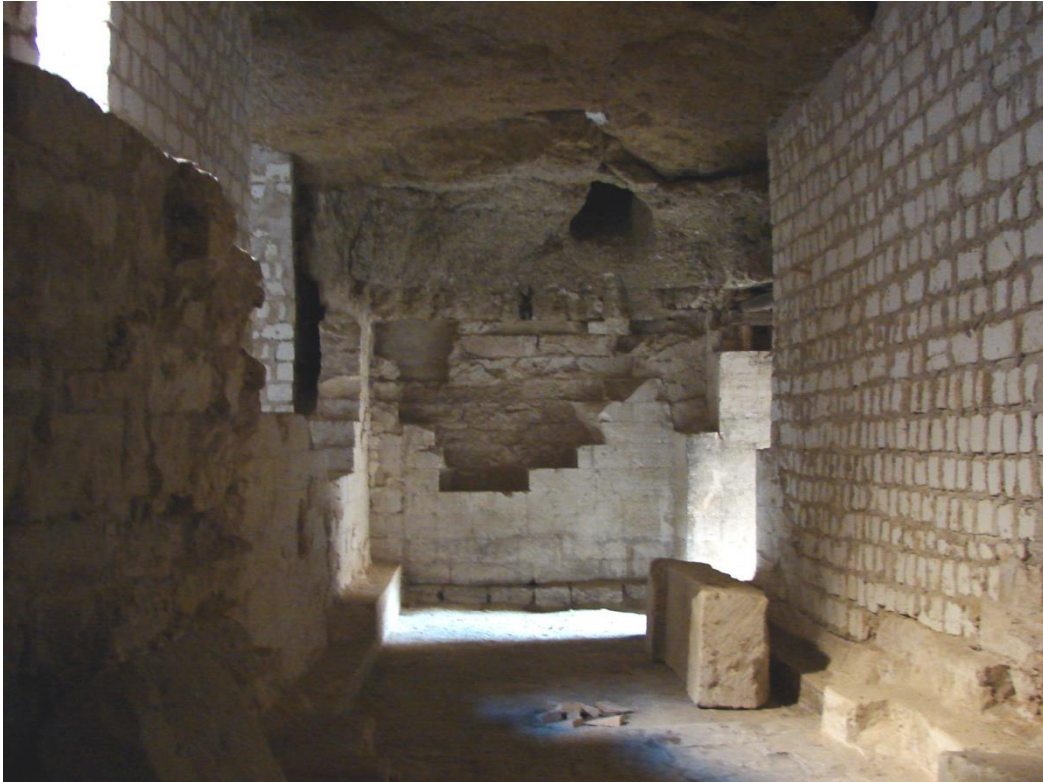
Fig. 54. La sala 2C. Al fons de la imatge el mur nord. A la dreta el mur est reconstruït i a l'esquerra el mur oest a mig desbastar. Sobre el paviment el petit foc.
