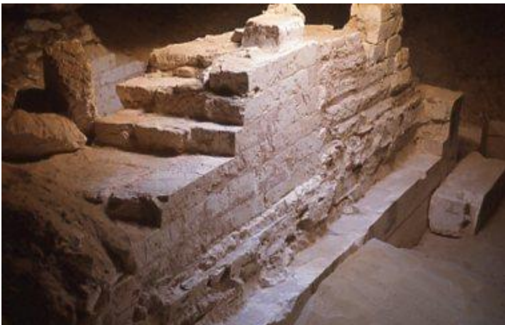
Fig. 57. Mur (U.E.15014) que separa les dues grans sales de culte. Podem veure-hi les diferents fases constructives i l'arrencament de la volta.
