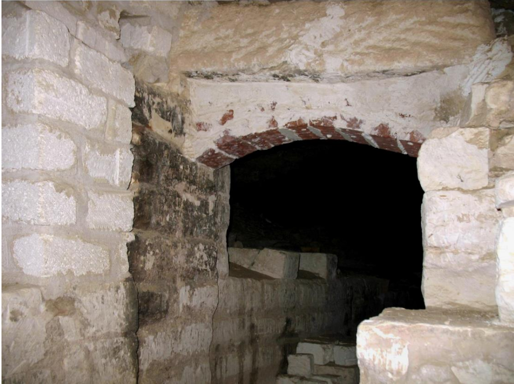
Fig. 62. Entrada a la galeria1. Hi podem veure els carreus pintats de negre i la consolidació de la llinda.
