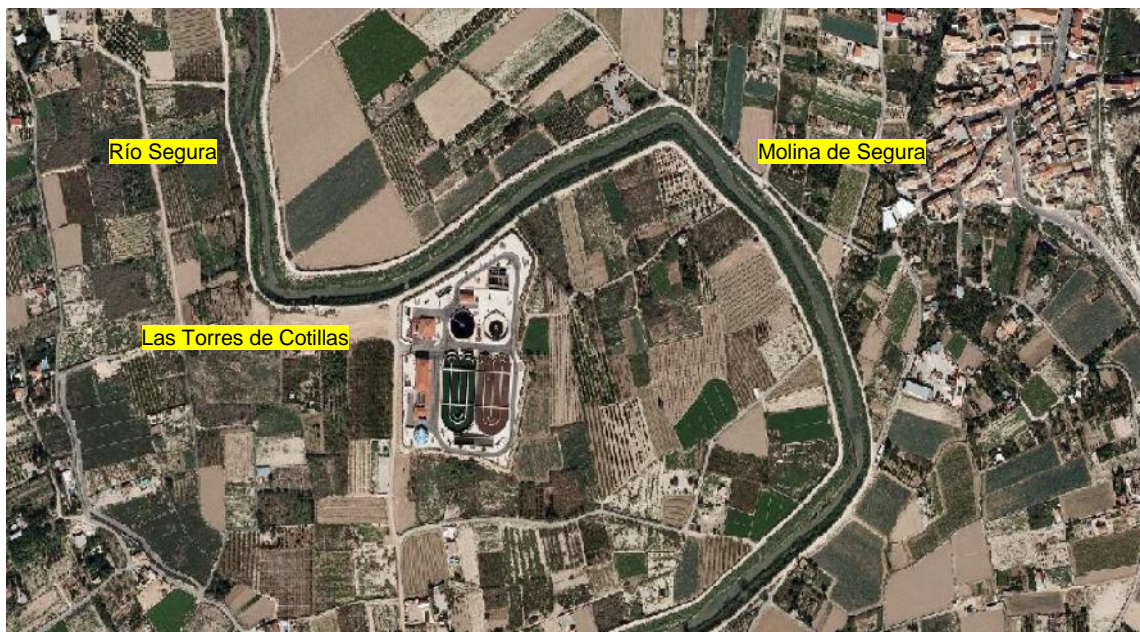
Figura 5.48. Estación depuradora de Las Torres de Cotillas.
