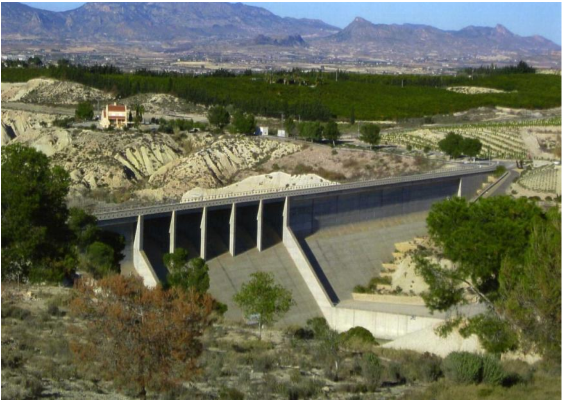
Figura 2.72. Presa de Los Rodeos.
