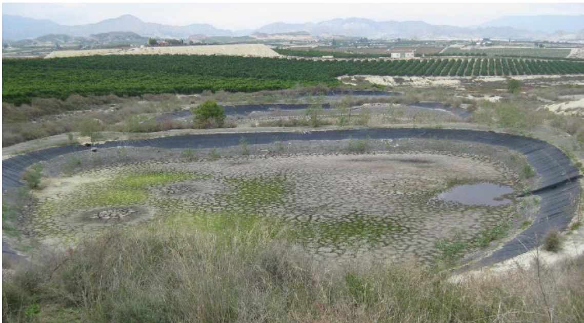
Figura 5.53. Situación actual de las lagunas de depuración Ceutí-Lorquí.
