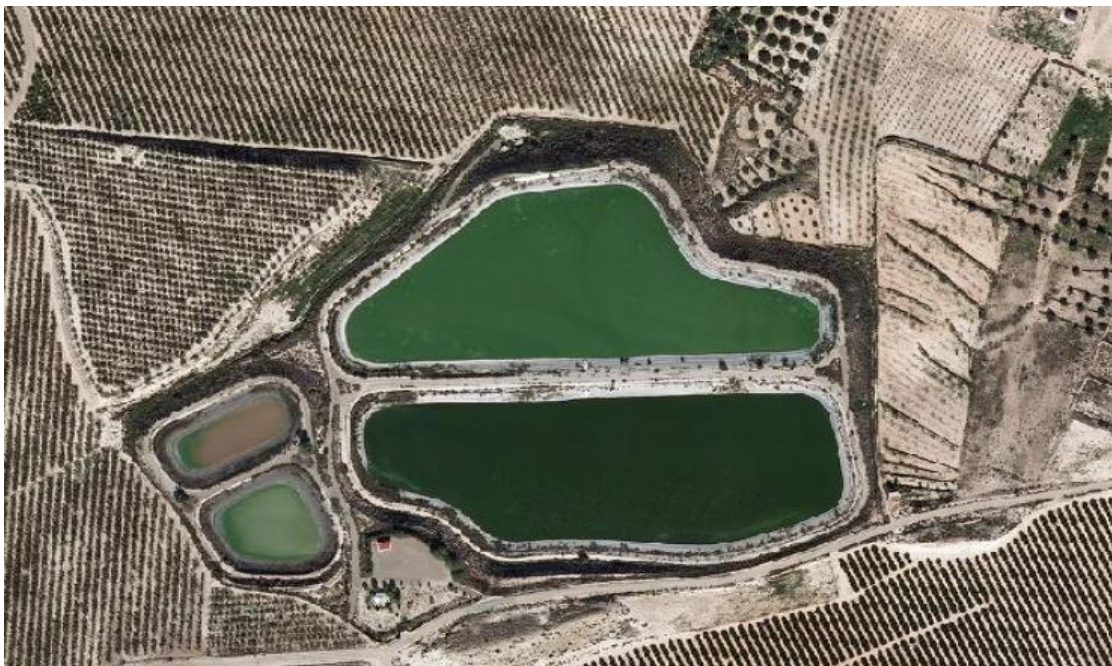
Figura 5.55. Depuradora de lagunaje Las Torres de Cotillas. Fuente:Cartomur
