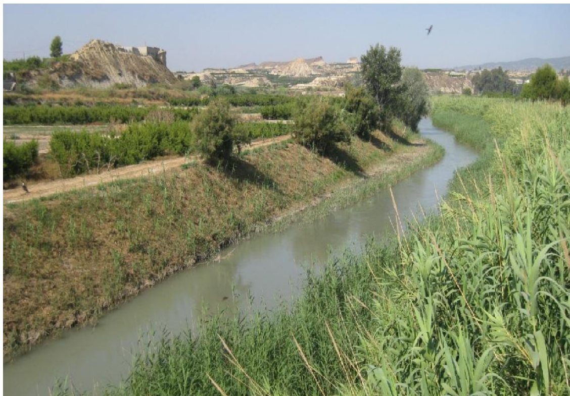
Figura 2.76. Limpieza del cauce del río para evitar desbordamientos.
