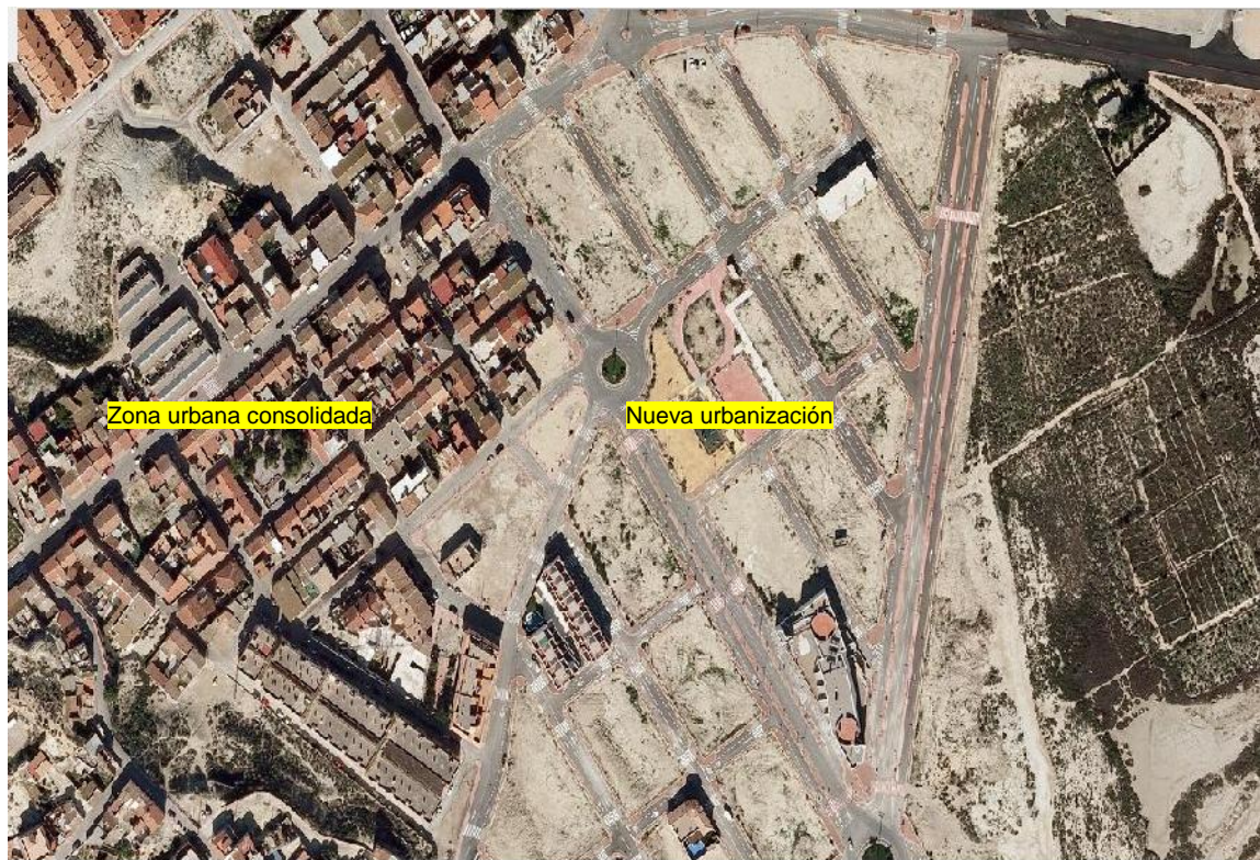
Figura 4.56 Lorquí. Casco urbano y nueva urbanización.
