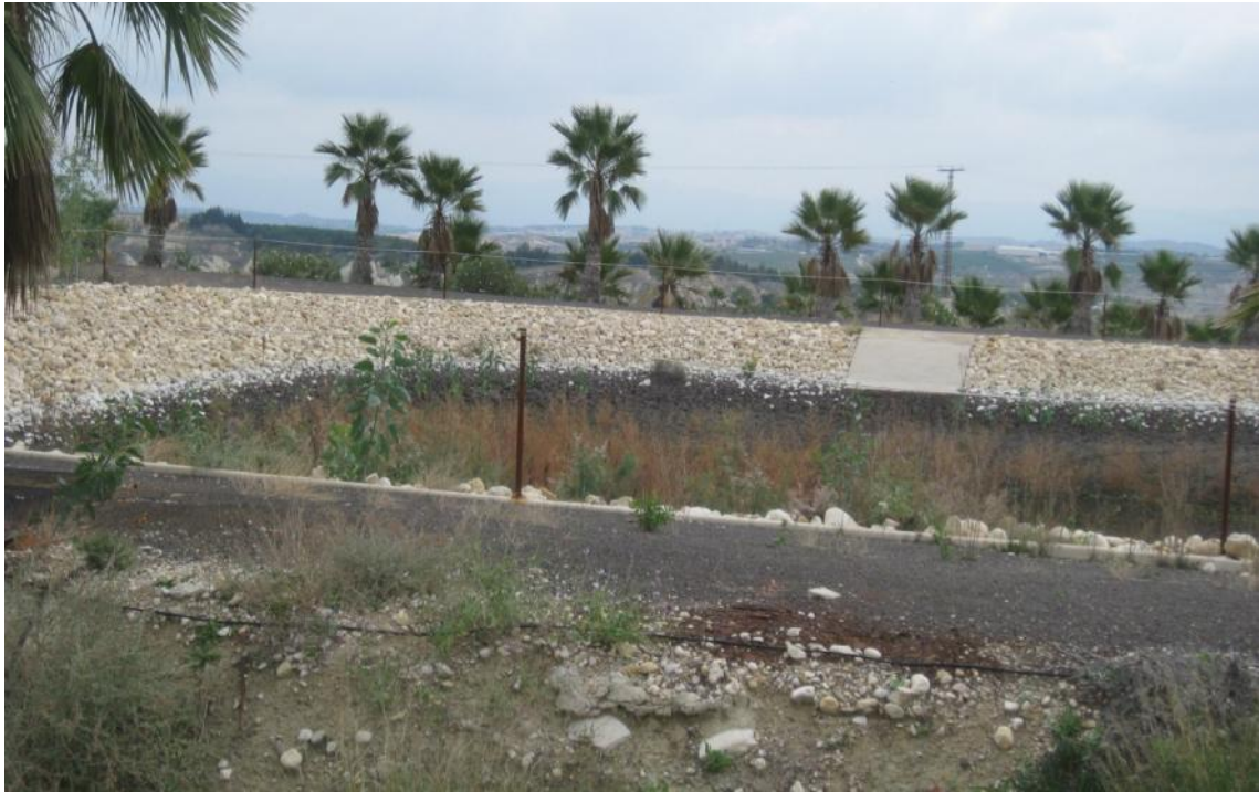
Figura 5.54. Situación de abandono de las lagunas de depuración Alguazas
