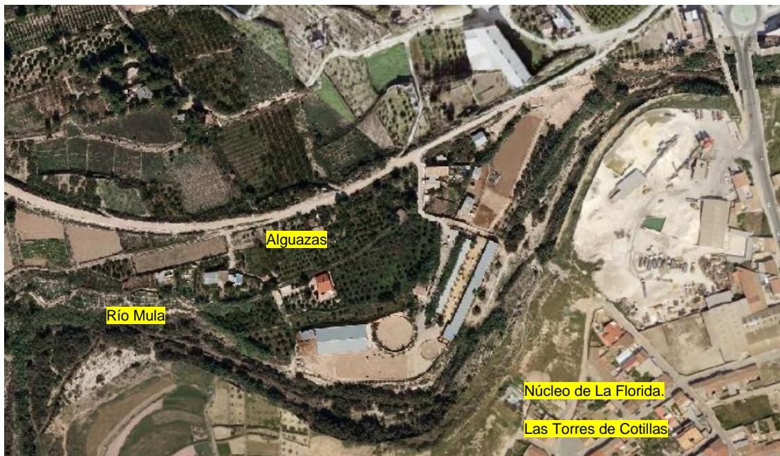
Figura 5.49. Estación depuradora de Alguazas.
