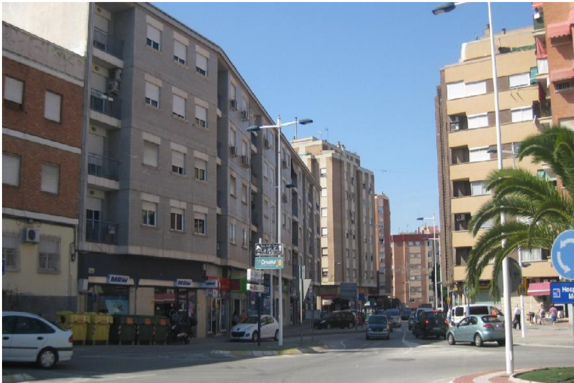
Figura 4.97. Centro de Molina de Segura.
