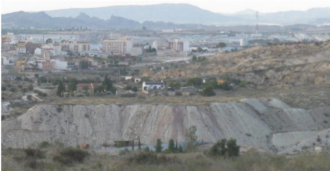
Figura 5.39. Escombrera colmatada y "sellada" de Molina de Segura.
