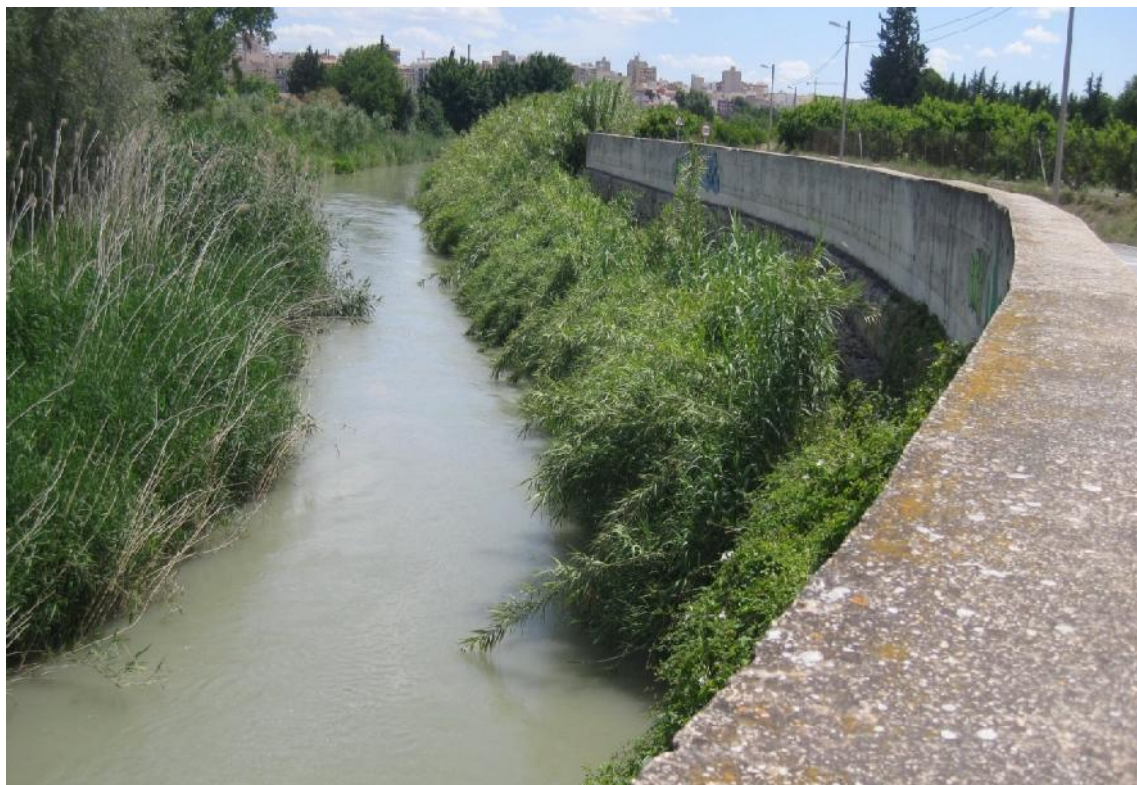
Figura 2.77. Reforzamiento de la mota del Río Segura.
