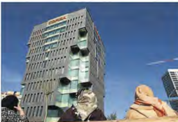
La sede central de Copisa en l'Hospitalet de Llobregat
