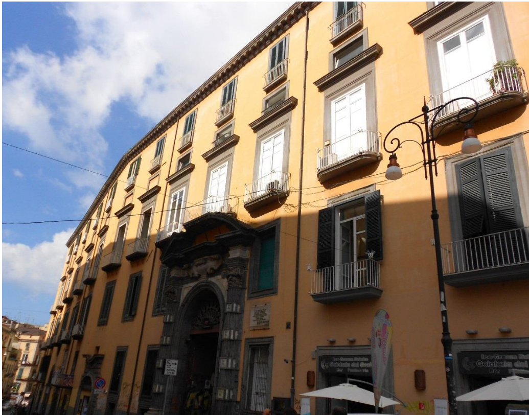
Fig. 222. Ferdinando Sanfelice, Palazzo Pignatelli . 1715-1720. Nápoles. Foto: Sara Caredda.
