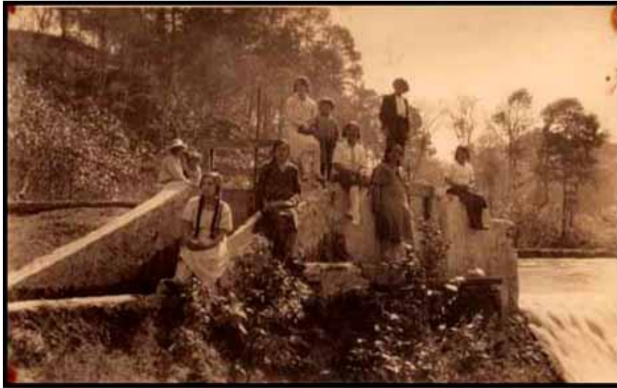
XXXIX. Visita a la cortina de la hidroeléctrica del Cerrito de Guadalupe. 1929. Gilberto Anaricio. Tlatlauqui.
