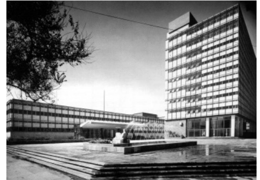
(19462-63) Edificio para la Tesorería del D.F.
