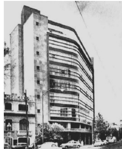
228. Vista edificio Reaseguradora Alianza, desde Calle Hamburgo.
