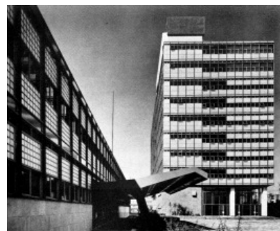
59. Edificio de la Tesorería D.F. 1962-63.
