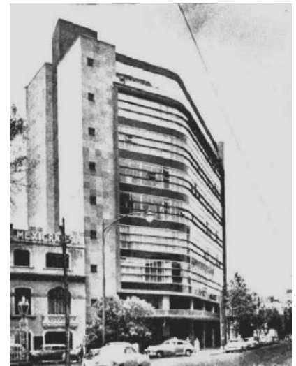
Edificio Reaseguradora Alianza 1951-52.
