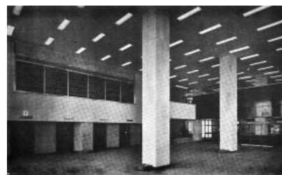
63. Edificio de la Tesorería D.F. 1962-63.
