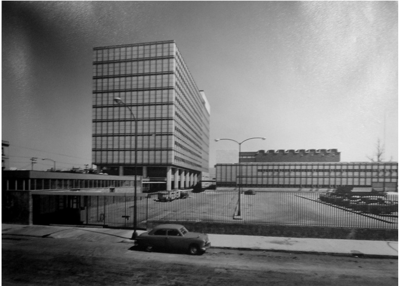
68. Edificio de la Tesorería D.F. 1962-63.
