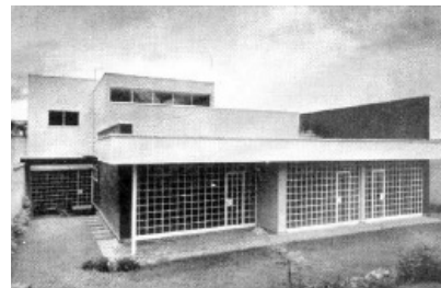
151. Fachada Posterior. Casa Alpes
