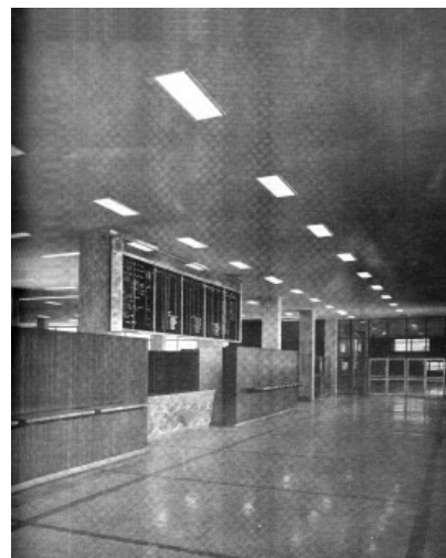
62. Edificio de la Tesorería D.F. 1962-63.
