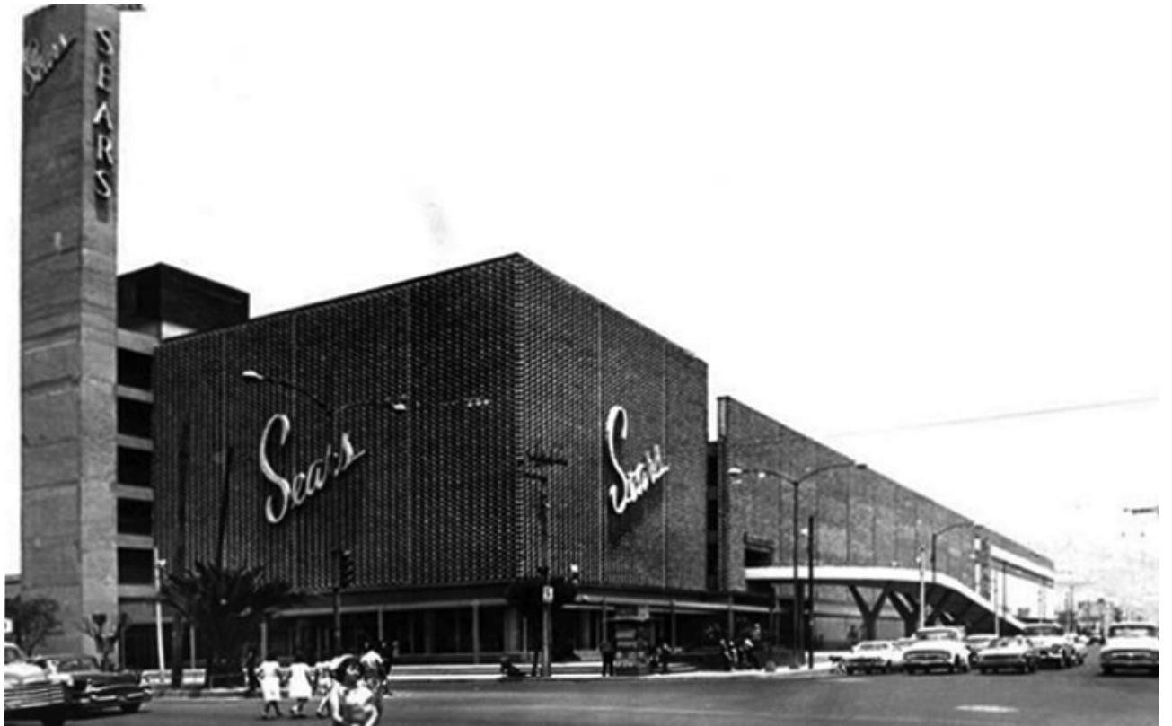
103. Edificio de estacionamiento Sears. 1963-1964
