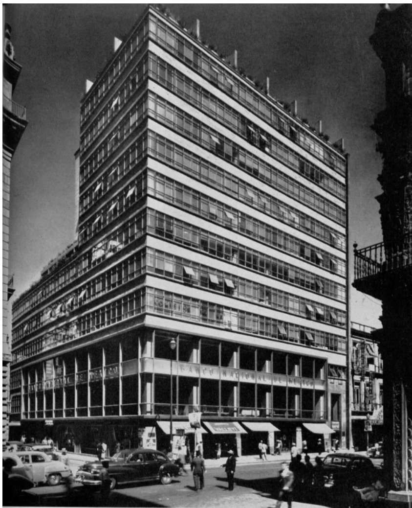
246. Edificio 5 de Mayo y Condesa. Vista calle 5 de Mayo
