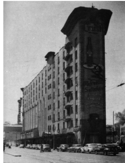
12. Edificio Reforma. Juan Segura..
