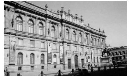
29. 1904 Edificio de Comunicaciones / Arq. Silvio Contri
