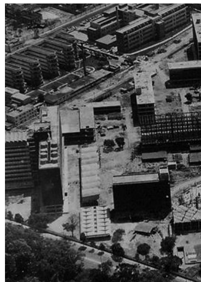
89. Vista aérea del Centro Médico Nacional en construcción. Al centro lavandería central 1956-57
