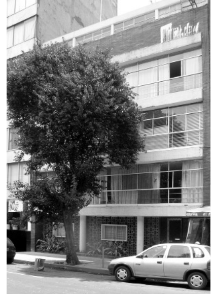
182. Fachada Hamburgo. Edificio Hamburgo
