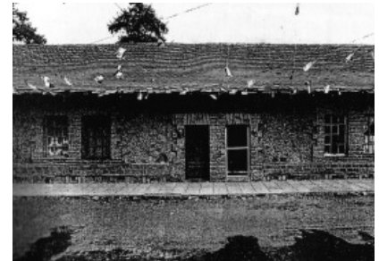
19. Vivienda para obreros en Metepec, Puebla. 1886
