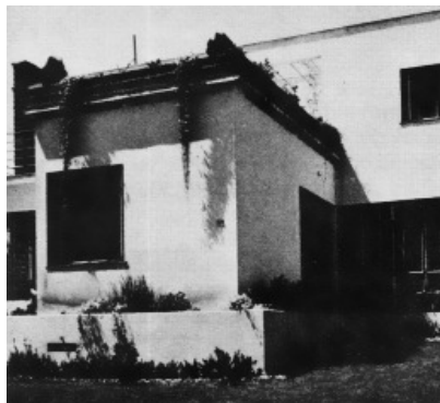
58. Vistas vivienda principal
