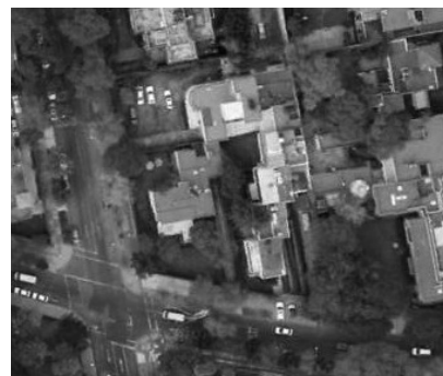
52. Vivienda y 4 apartamentos en Monte Altai 525. 1937
