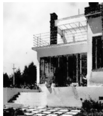
57. Vistas vivienda principal
