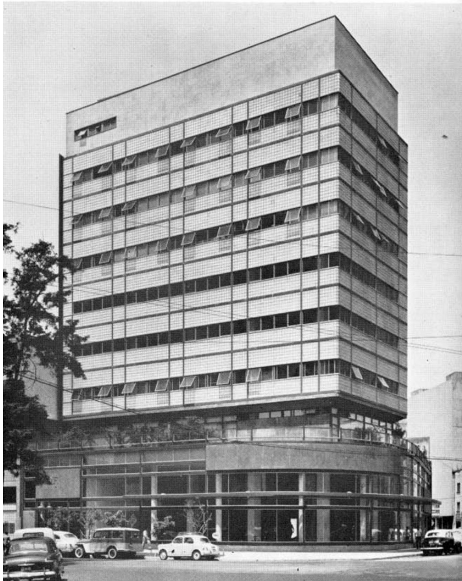
39. Edificio de la Industria Química farmacéutica 1958.
