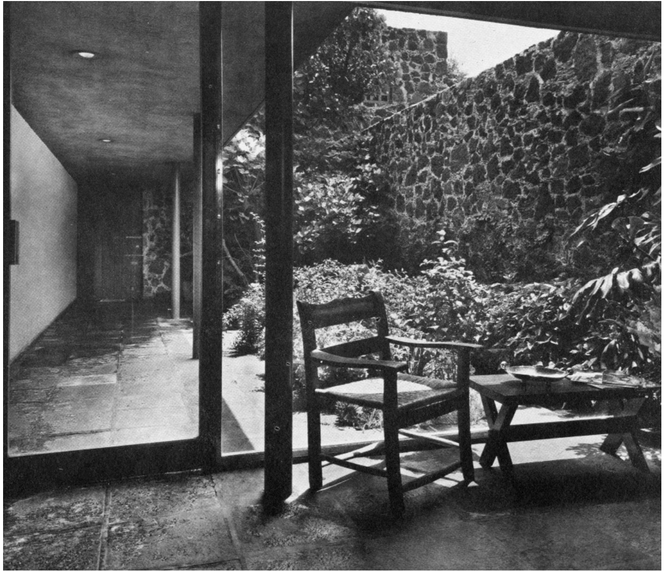
32.1. Casa Quintana. 1954-56. Vestíbulo
