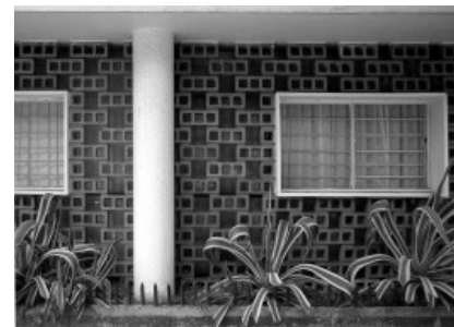
180. Detalle Planta Baja. . Edificio Hamburgo
