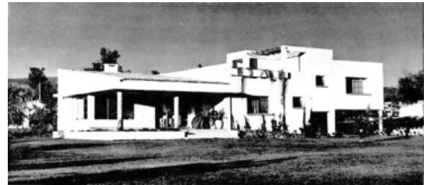
18. Casa Guieu, fachada suroeste
