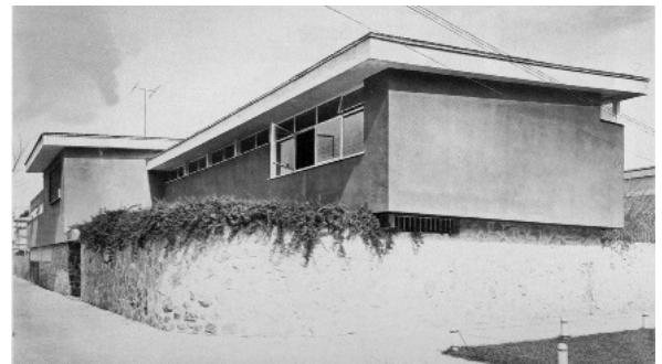
176. Fachada exterior. Casa Tennyson
