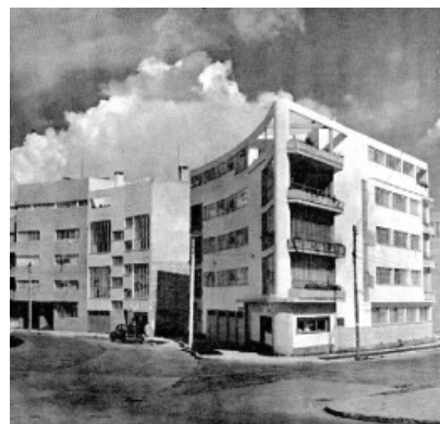
70. Edificio de apartamentos Plaza Melchor Ocampo 64
