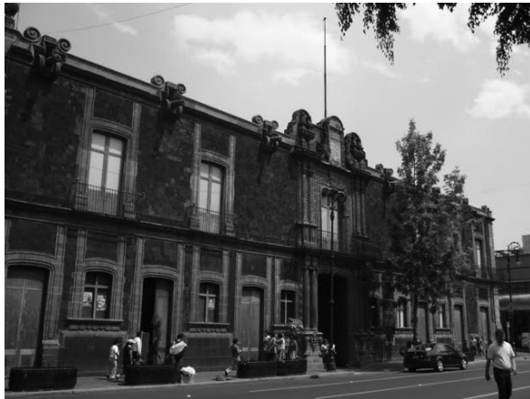
10. Fachada Casa de los Condes de Calimaya
