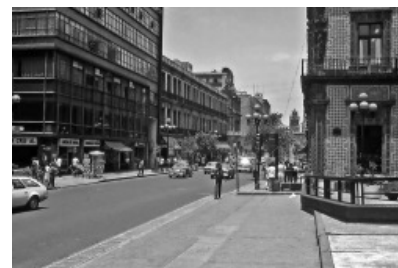
245 Edificio 5 de Mayo y Condesa. Vista calle 5 de Mayo
