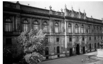
18. 1902-1911 Edificio de Comunicaciones / Arq. Silvio Contri.
