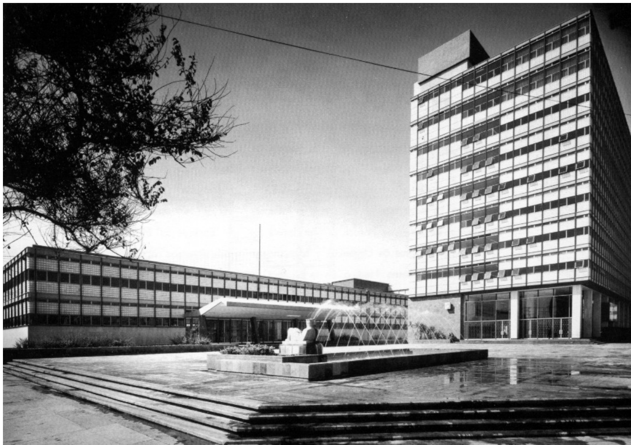
61. Edificio de la Tesorería D.F. 1962-63.
