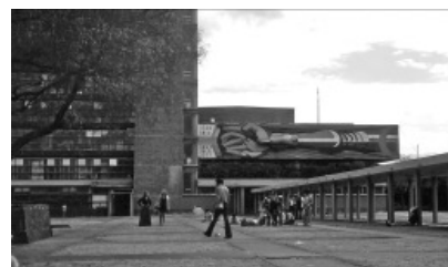
312.. Vista lateral edificio Rectoría CU
