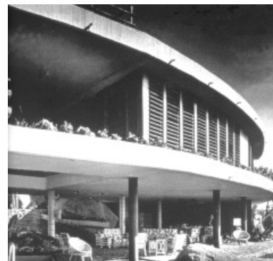
93. Viviendas Sr. Luis Montes. 1950
