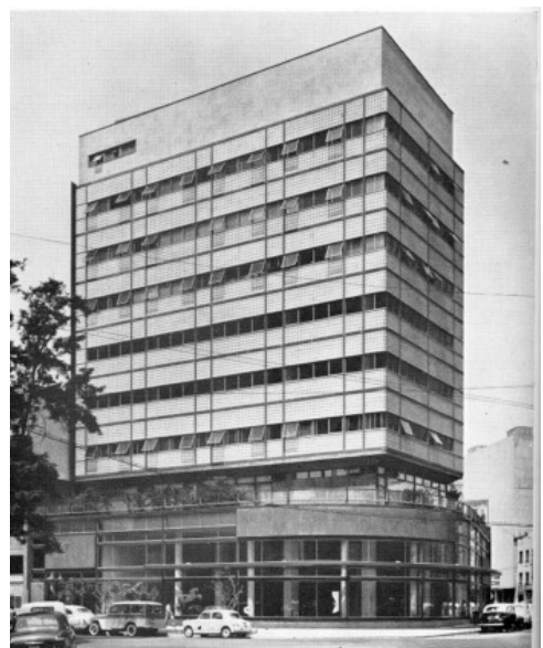
(1958) Edificio para la industria Química farmacéutica.
