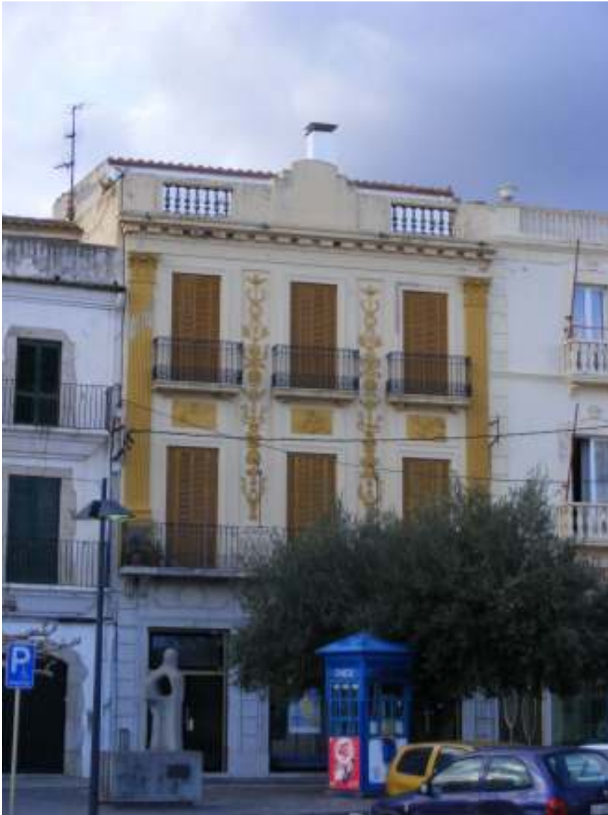
Imatge 5. Façana principal de la Casa Rahola de Cadaqués. Foto: www.invarquit.cultura.gencat.cat [en línia]. (Patrimoni Generalitat – Arquitectura-).
