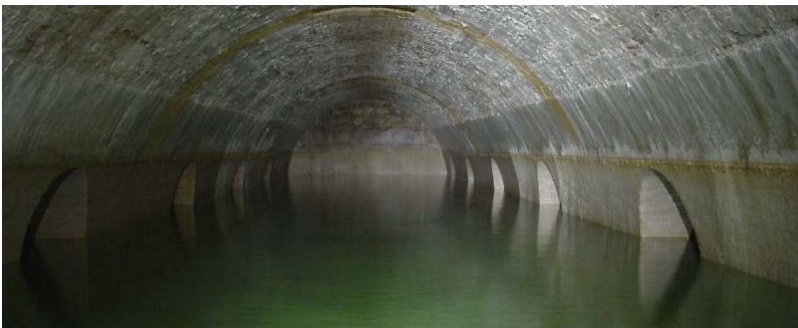
Imatge 6. Vista contraposada a la imatge anterior, on s'aprecia el mur de contenció final de l'aigua i els túnels de connexió amb la resta de cisternes 374 .
