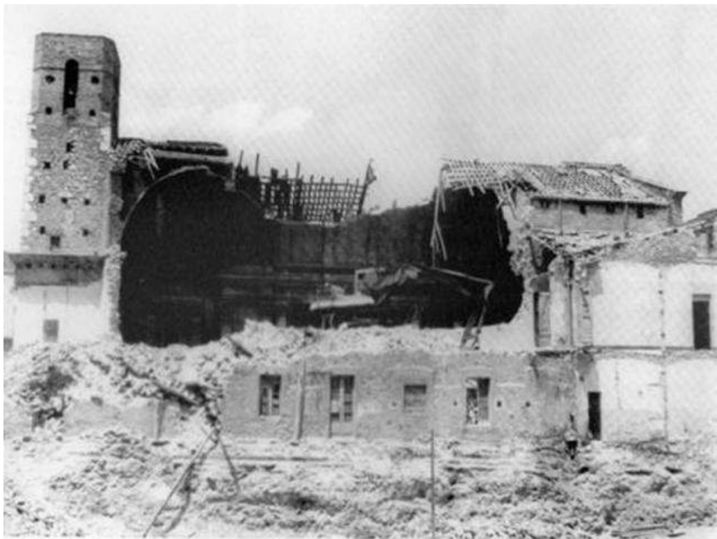
Imatge 31. Vista de la Divina Providència durant el seu enderroc 429 .
