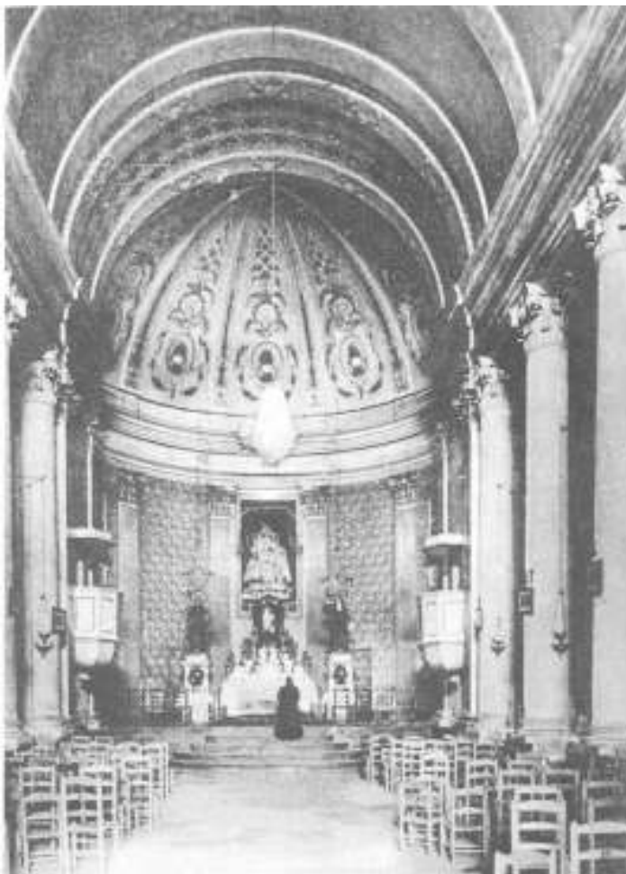
Imatge 30. Interior de la Divina Providència abans del seu enderroc 428 .
