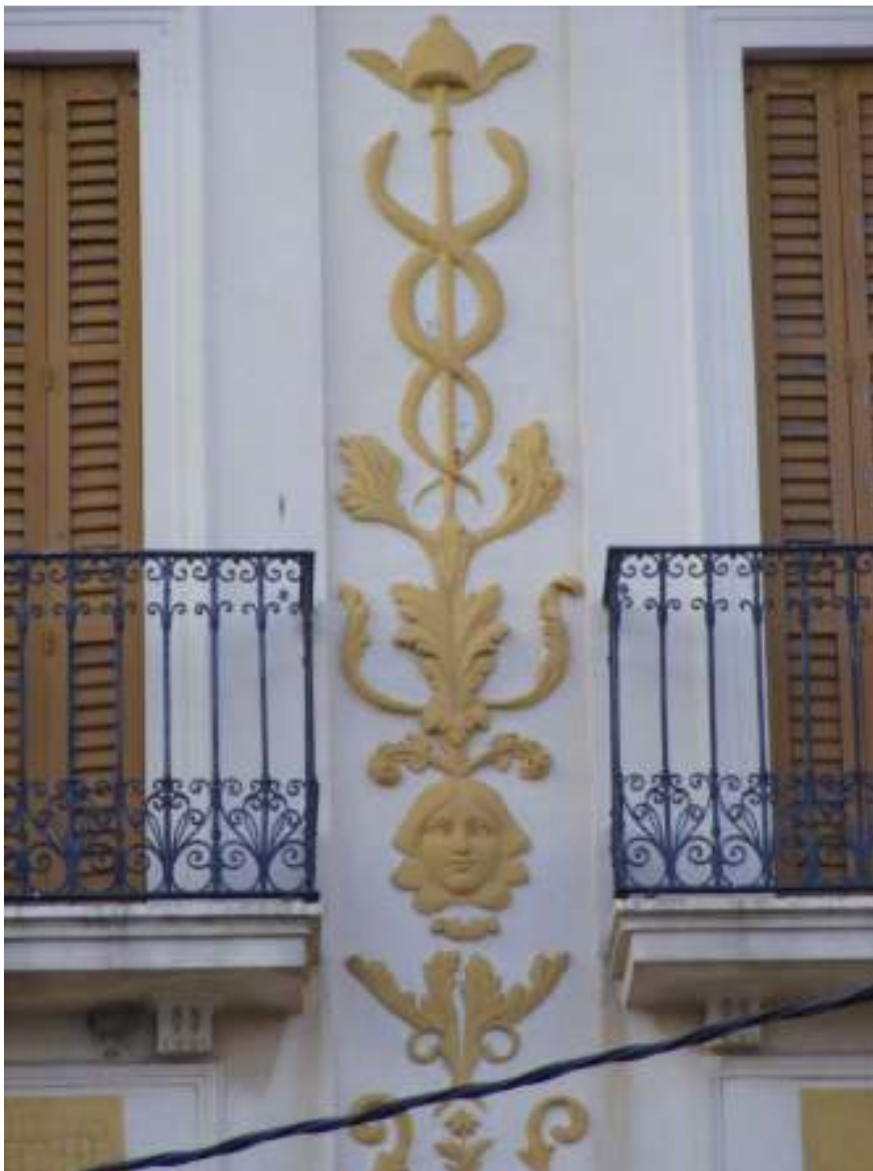
Imatge 6. Detall de l'ornamentació al·legòrica entre els cossos de l'edifici, llosetes polides del balcó i forja de les baranes. Foto: www.invarquit.cultura.gencat.cat [en línia] (Patrimoni Generalitat – Arquitectura-).
