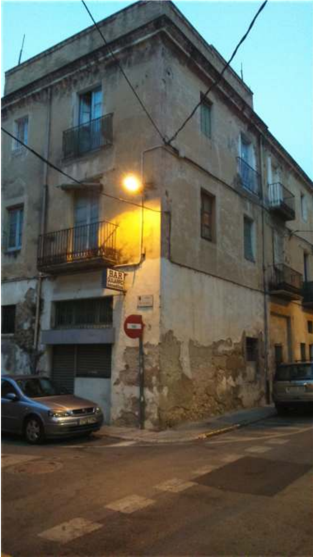
Imatge 16: Foto. Alfons Martínez Puig. Residencial situada al carrer Olot cantonada amb carrer de la Rosa de Figueres.
