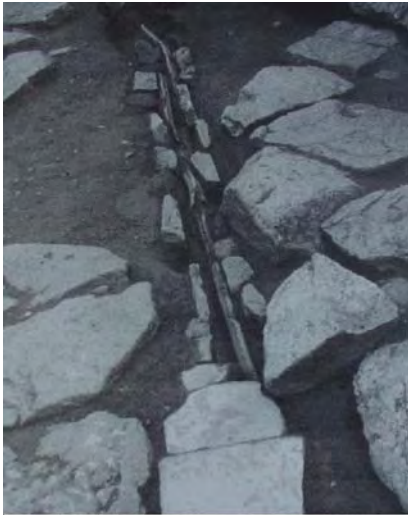
Foto 30: Tubería de agua en Merida (Alba, 2000)
