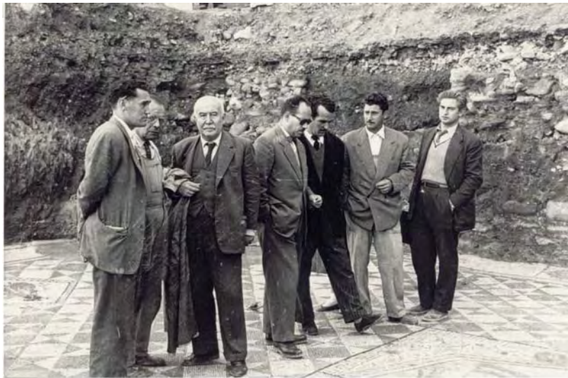
Foto 313: Excavación del solar de la Lira (Sagunto) (CAS)
