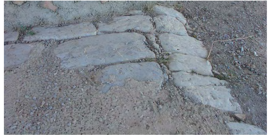
Foto 133: Detalle del enlosado bajo el puente de Ferrocarril (Sagunto)
