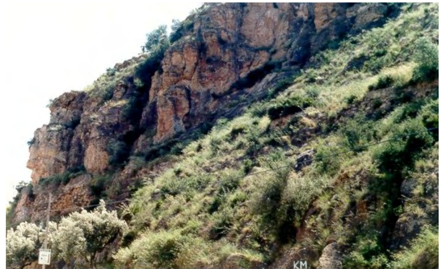
Foto 4: Acueducto de Sagunto segun E. Ripolles (AA. VV., 1985-2008)
