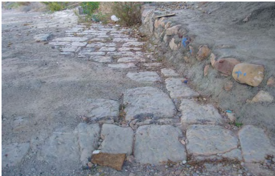
Foto 134: Enlosado bajo puente ferrocarril (Sagunto)
