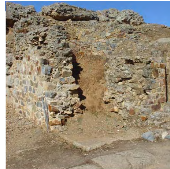
Foto 210: Relleno del anfiteatro de Mérida
