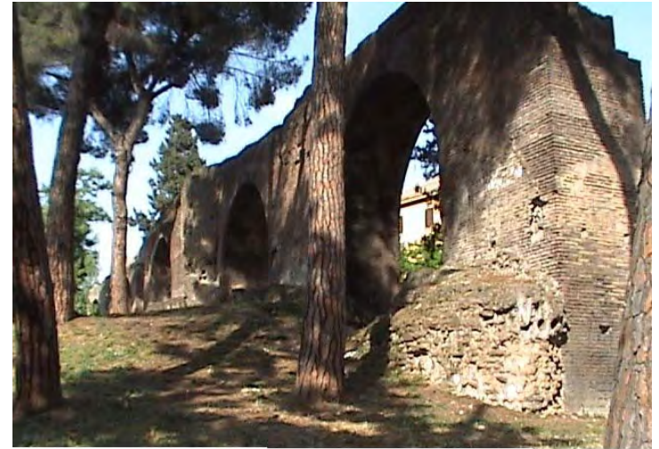
Foto 6: Acueducto de Via Statilia - Roma
