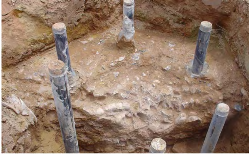
Foto 279: Cimentación del arco de la Moreria (Sagunto)
