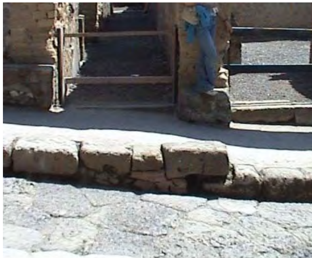
Foto 45: Conexión entre desague de vivienda y acera (Herculano)
