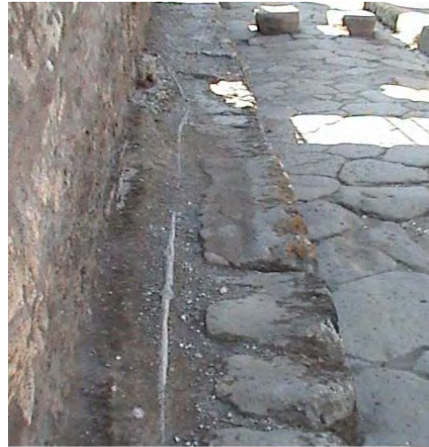
Foto 31: Tubería de plomo en Pompeya
