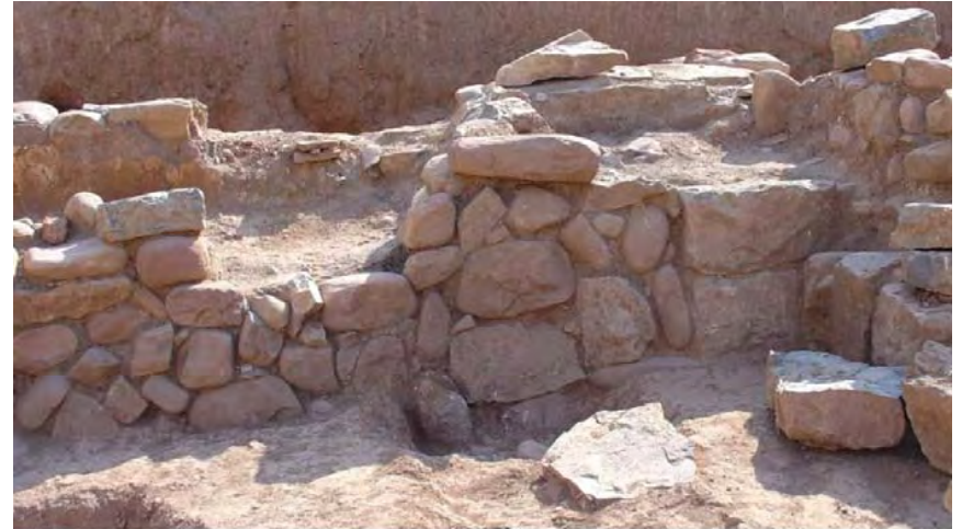
Foto 483: Cerramiento de vanos (Morera - Sagunto)
