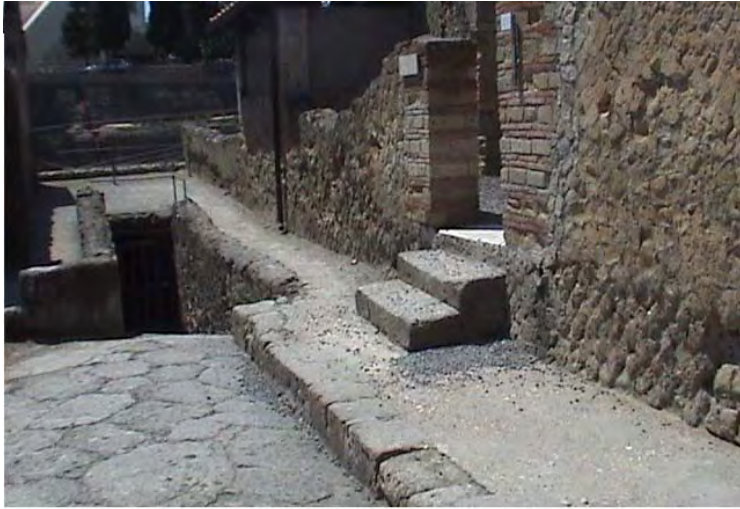
Foto 107: Desnivel entre acera y umbral (Herculano)
