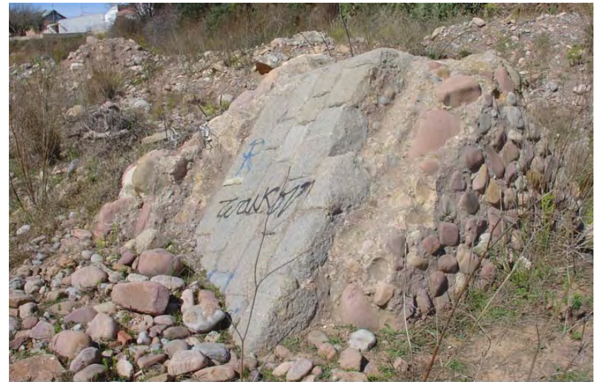
Foto 16 : Restos del puente romano de Sagunto
