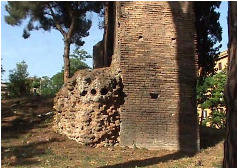
Foto 7 : Acueducto de Via Statilia - Roma
