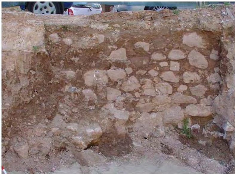
Foto126: Detalle del acueducto de la Calle Huertos - Sagunto
