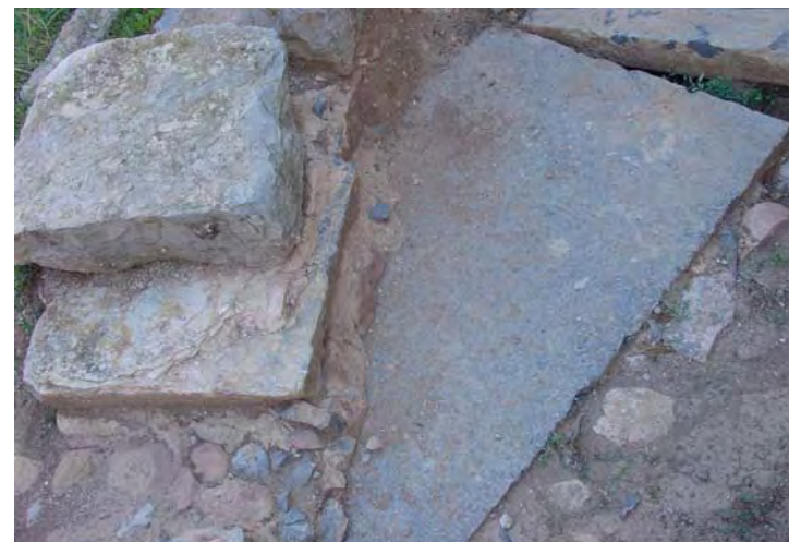
Foto 302: Fachada del edificio y gran cloaca
