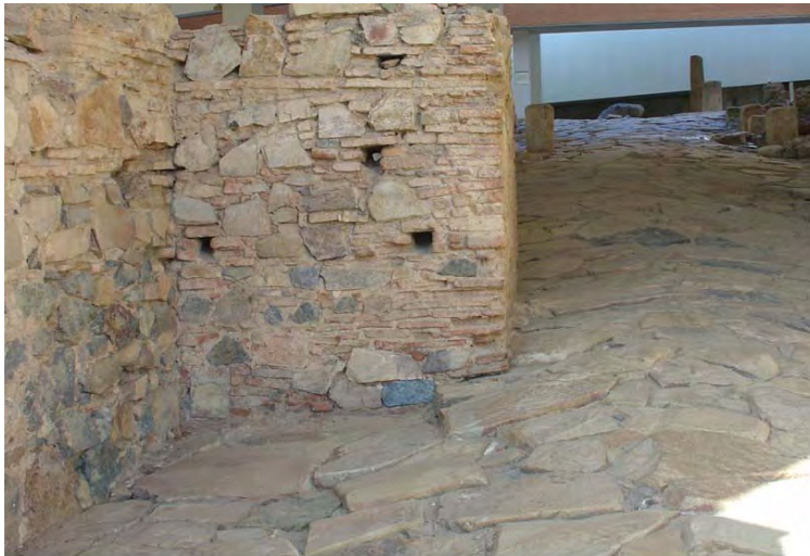
Foto 118: Detalle de la ocupación de la calzada en Mérida (Moreria)
