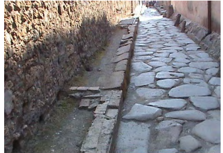
Foto 32: Entrada de tubería de agua a una casa en Pompeya
