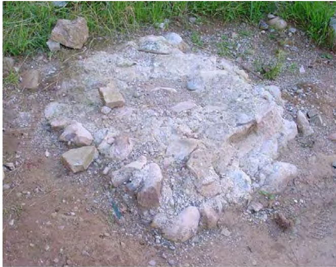
Foto 303: Cimentacion de pilar del solar de Quevedo
