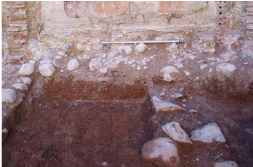
Foto 297: Cimentaciones bajo el edificio romano del solar de Quevedo
