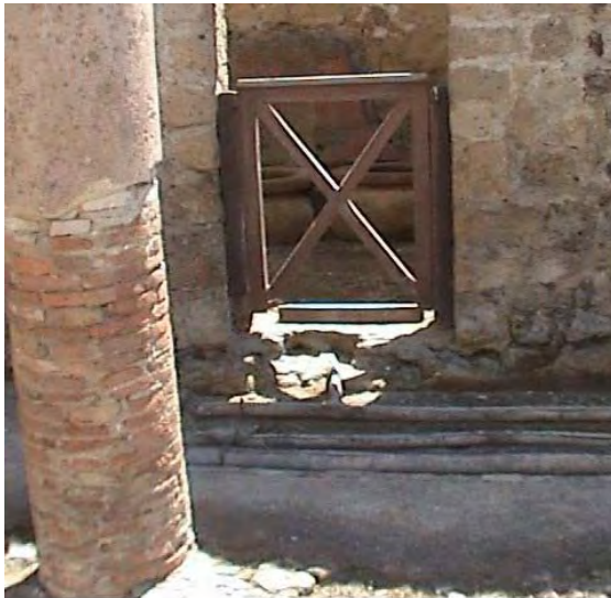
Foto 33: Entrada de casa y tuberías en la acera en Pompeya
