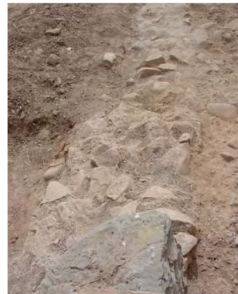
Foto 300: Cimentación del edificio
