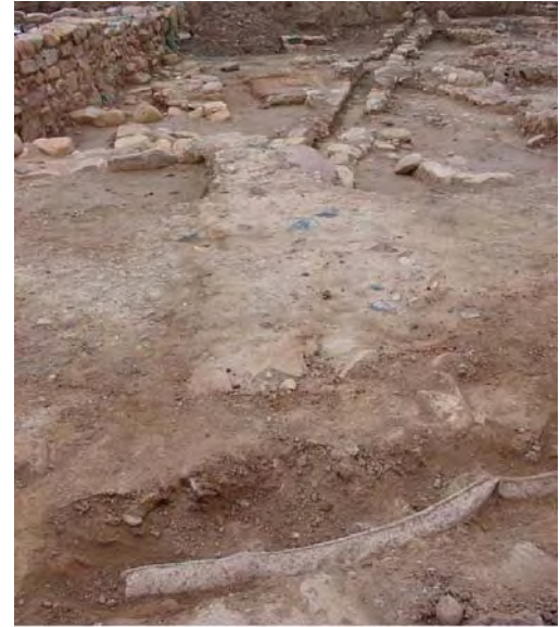
Foto 167: Cruce de tubería sobre desague (Morería - Sagunto)
