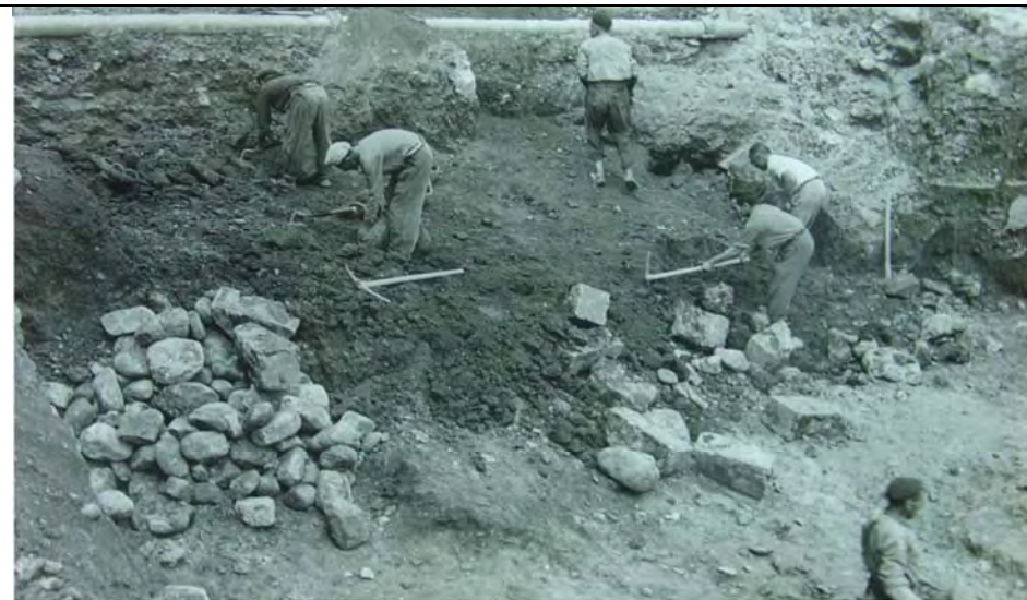
Foto 316: Excavación del solar de la Lira (CAS)
