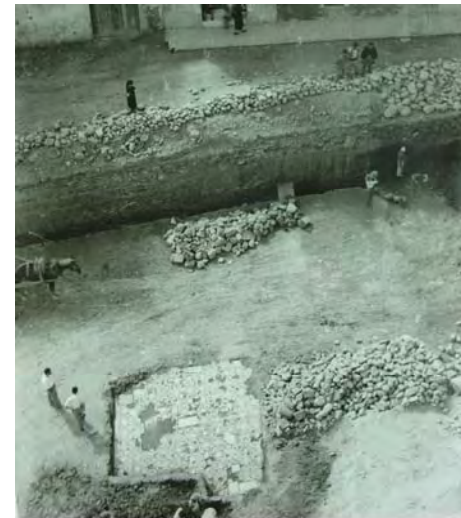
Foto 314: Excavación del solar de la Lira (Sagunto) (CAS)
