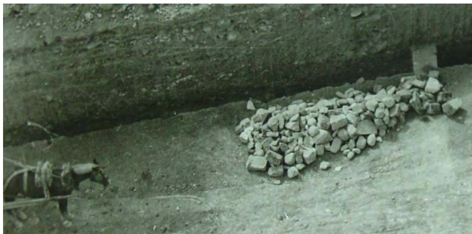
Foto 319: Excavación del solar de la Lira (Sagunto) (CAS)
