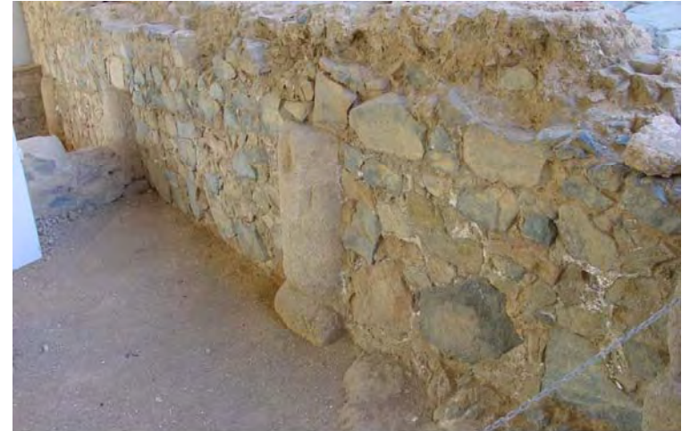
Foto 163: Cerramiento de portico (Morera - Mérida)
