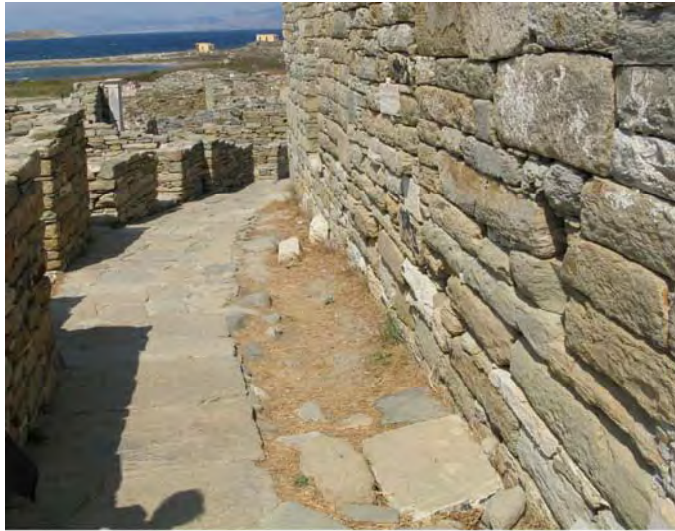
Foto 47: Salida de desagüe a la calle (Delos)
