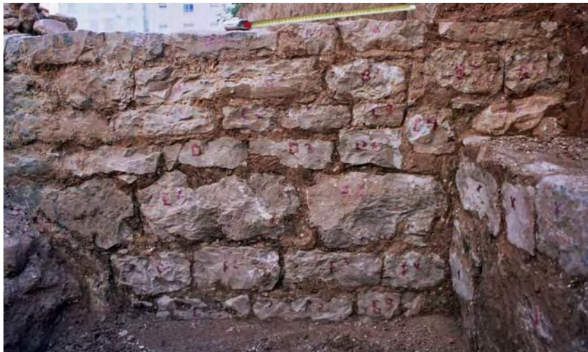
Foto 426: Interior del podio del templo 2 ( la Moreria - Sagunto)
