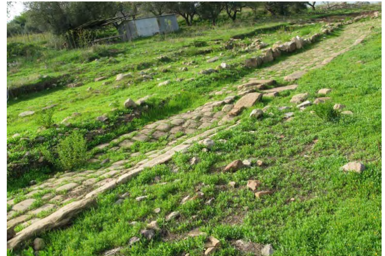
Foto 86: Pliegue en la calzada debido a un terremoto (Tyndaris)
