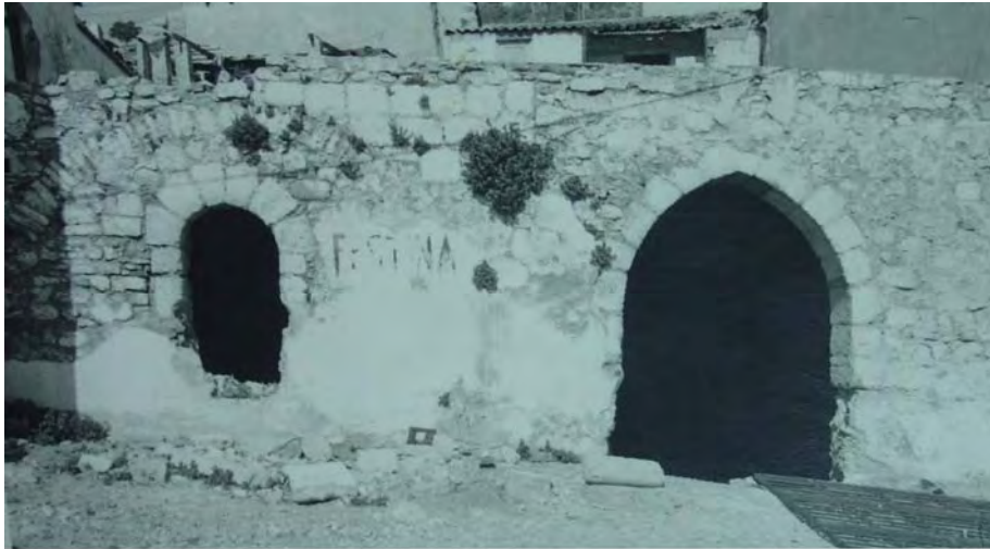
Foto 5: Deposito de agua (Sagunto - Av. del Pais Valencia) - Foto C.A.S.
