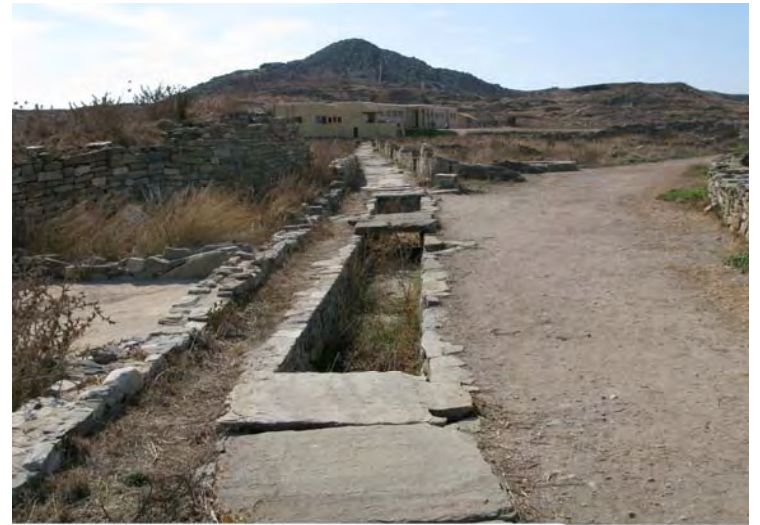
Foto 38: Cloaca lateral transformada en central - Delos (Grecia)
