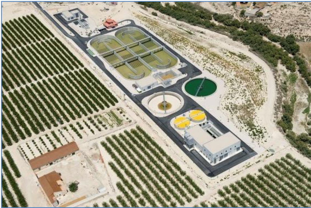
Vue aérienne de la station de traitements des eaux usées de Alguazas (Murcie), entourée d'arbres fruitiers utilisant des eaux réutilisées, sur la rive droite du fleuve Mula (©taylor 2014)
