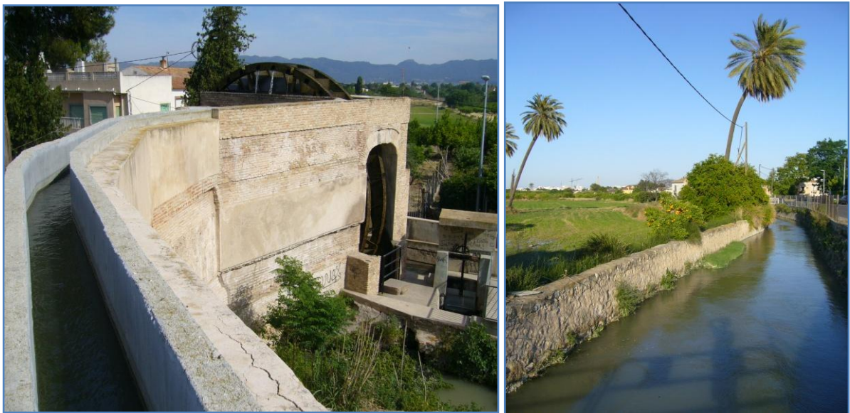
À gauche infrastructure hydraulique héritée des arabes. Il s'agit de la noria (rue) de La Ñora, une machine hydraulique permettant d'élever l'eau. À droite l' acequia mayor de l'Aljufia, principale canalisation de la rive gauche du système d'irrigation de la huerta de Murcia. (©salinaspalacios, 2013)
