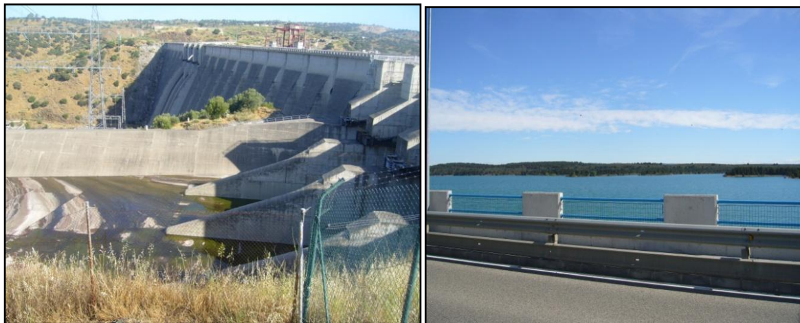
Des photos du barrage hydroélectrique d'Alcantara II , près de la frontière avec le Portugal(©salinaspalacios2012)
