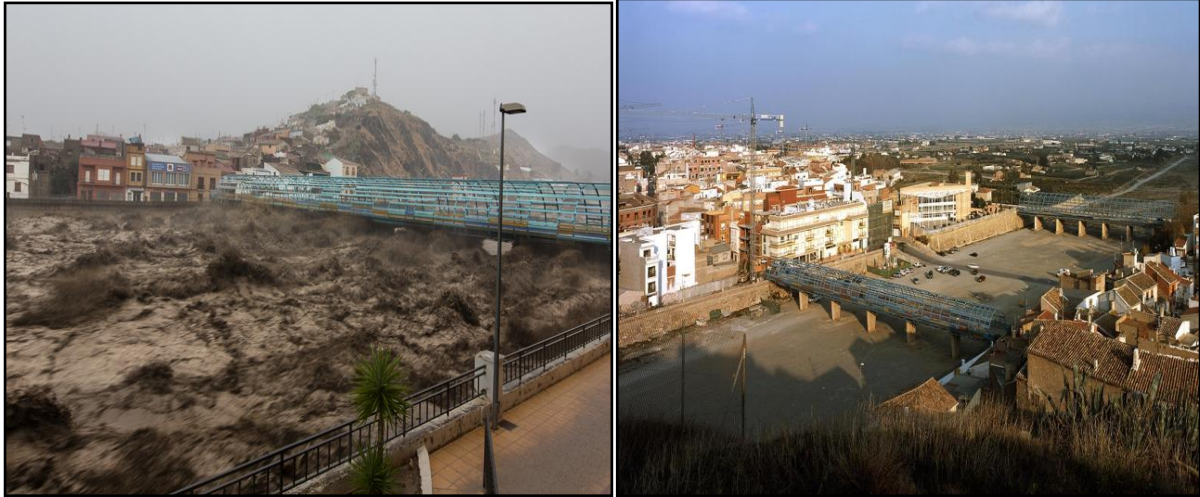
À gauche, la rambla de Nogalte, à Puerto Lumbreras pendant les inondations du 12 septembre 2012. À droite, la même rambla dans des conditions hydrologiques normales. (© La verdad, 2012; ©salinaspalacios, 2014)
