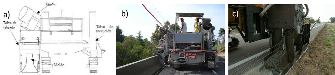
Figura 2.6. Esquema máquina deslizadora (a) (TEMAC, 2009) y construcción de una barrera de hormigón in situ (b) i (c) (Fuente: Servià Cantó, 2013).
