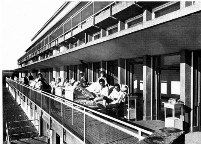
Krankenhaus Waiblingen: Erdgescholterrasse an einem Sonnentag im November 1928. Einblick rechts in das dahinter liegende leere Krankenzimmer, Besonnung desselben durch die über dem Schuttdach angeordneten Oberlichtfenster. Bei dem niedrigen Sonnenstand vollständige Besonnung der Terrasse.
