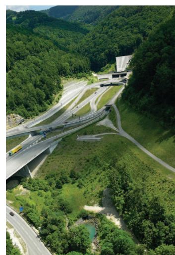
[s23] Las bocas de túnel como hitos directos
