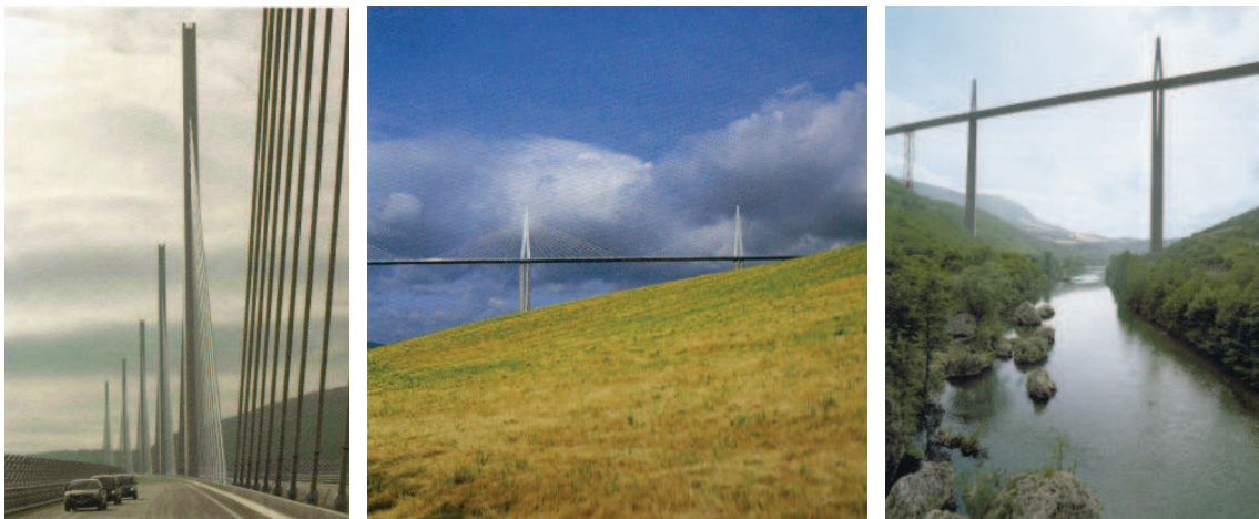
[s25] Viaducte de Millau.
