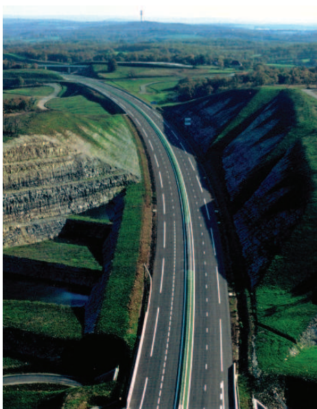
[s46] Tractament paisatgístic autopista A20. La longitud del tram és d'aproximadament 120 km i està integrat per diferents seqüències. Malauradament, però, en l'execució final s'han desestimat moltes de les idees inicials.
