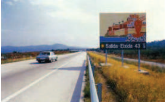
[s65] Senyalització a l'autopista A7.
