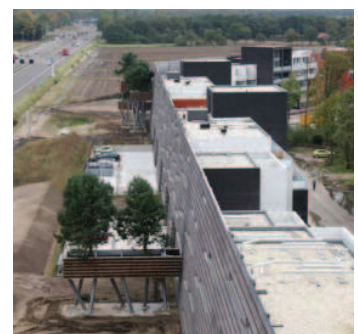
[s26] Relación contrastada entre las dos caras del cerramiento en el proyecto residencial de Buro Lubbers.
