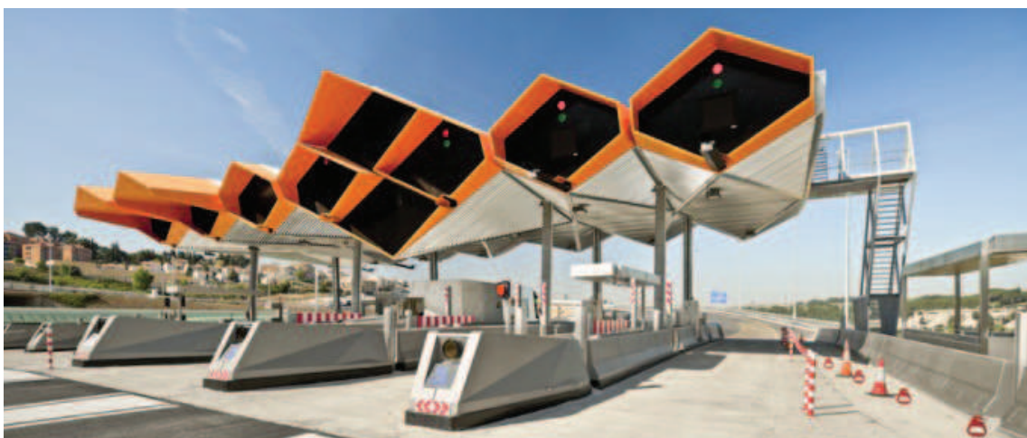
[s19] Marquesines i edificis annexos AP-7.
