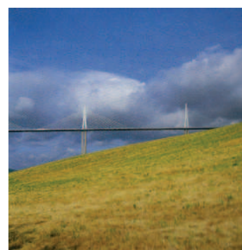
[s25] Viaducto de Millau, un ejemplo de secuencia lineal abierta.
