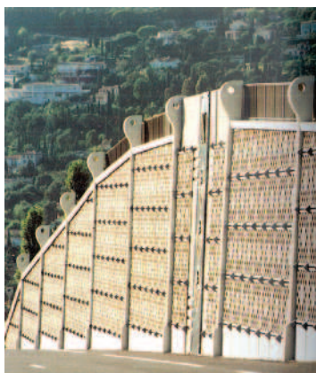
[s33] Condicionament de l'autovia Cannes-Grasse. Intervenció en una carretera escènica que combina la plantació d'arbrat, pantalles acústiques i murs de contenció. La protecció acústica consisteix en unes pantalles blanques de formigó prefabricat col·locades en paral·lel a l'eix de la via. Les superfícies d'aquests elements compten amb una sèrie de motius destinats a recordar el caràcter històric de la via i a suscitar cert interès turístic.
