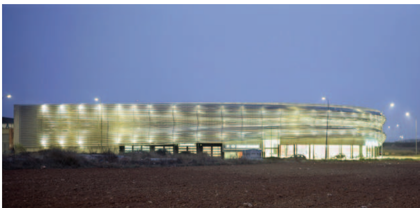
[s27] Edifici BMW Motor Munich. El tancament es basa en una reinterpretació estilitzada d'un component funcional del paisatge de l'autopista, una rèplica gegantina de vioncs metàl·liques.
