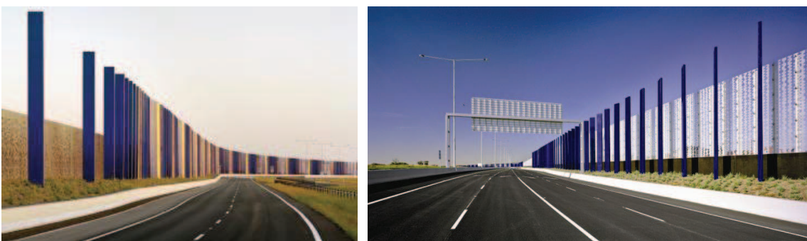
[s37] Craigieburn Bypass: Scrim Wall. En el tram corresponent al suburbi de Thomastown prop de Melbourne, un seguit de lamel·les blaves acompanya la curvatura del traçat. Aquests prismes verticals exempts es giren lleugerament per tal d'aconseguir diferents efectes segons la distància de l'observador. La disposició pautaada i les diferents orientacions incrementen la sensació que produeix el gir i la velocitat.
