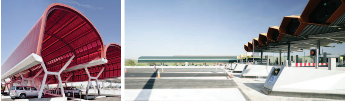
[s19] Marquesines i edificis annexos AP-7.
