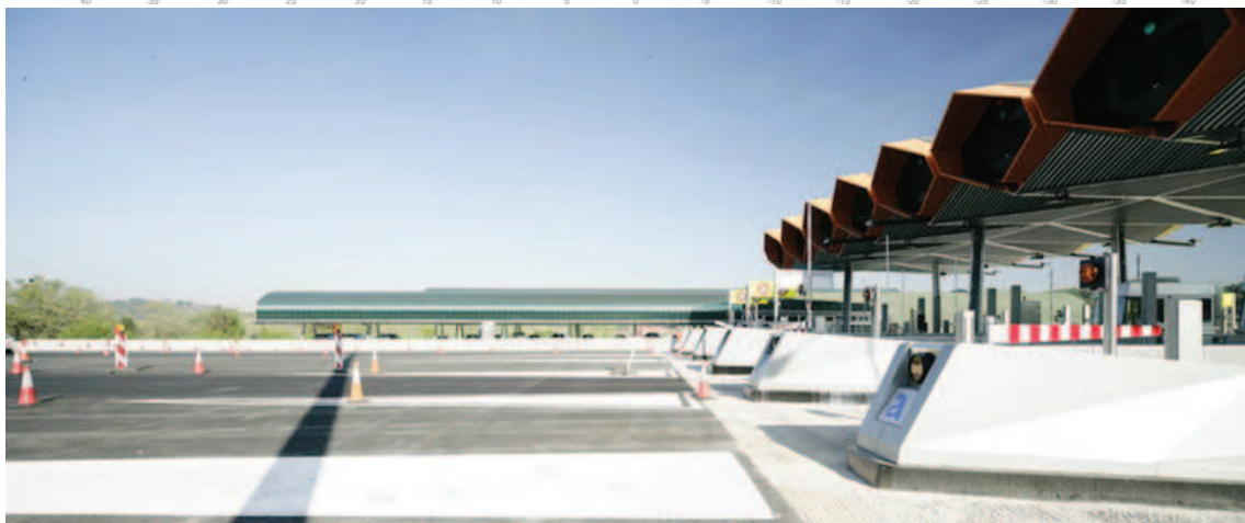
[s19] Marquesines i edificis annexos AP-7. Igual que la seqüència [s20], el disseny del peatge combina l'atenció a l'escala del vianant i a la de l'automòbil.
