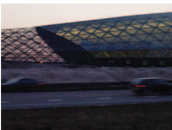
[s29] Detalle de la transición entre edificio y barrera en los extremos.
