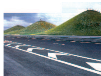
[s11] Área en Troyes. Los montículos actúan de filtro o barrera según la velocidad del desplazamiento.
