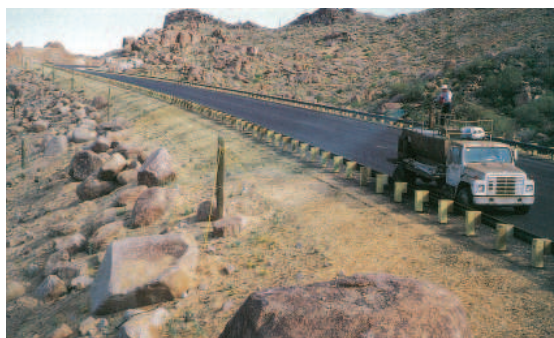
[s53] Beeline Highway. Salvar les plantes natives del desert és una pràctica comú en la majoria d'obres públiques d'Arizona. Allò inusual a la Beeline Highway és l'escala del projecte.
