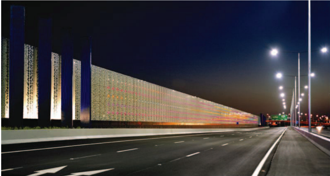
[s37] Craigieburn Bypass: Scrim Wall. La transformació nocturna del mur va permetre a l'artista George Owen utilitzar el tancament com un llenç en blanc on importar imatges en forma de mapa de bits i arxius de vídeo. La programació dels LEDs depèn de la informació dels sensors i reproduceix en temps real el volum de trànsit de l'autopista.
