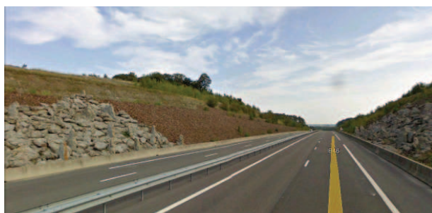
[s47] Les Ardenes Autopista A34. Secció en desmunt on es recull l'aigua a la part superior del talús amb la intenció de crear salts d'aigua en la intersecció amb l'autopista.
