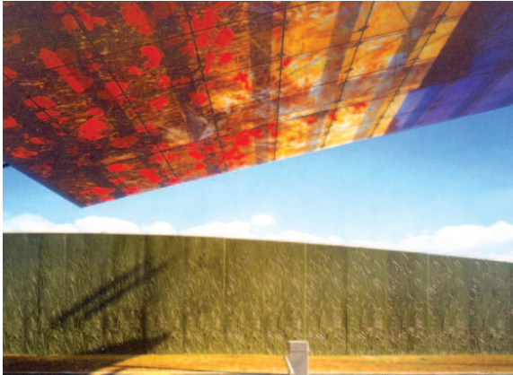
[s20] Peatges d'autopista A16. El peatge combina l'atenció a l'escala del vianant i a la de l'automòbil.
