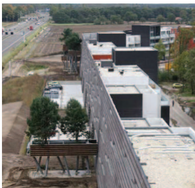
[s26] Edifici residencial Boschkens. Amb més de 700 m de llarg i 14 m d'alt, la barrera no és un simple pla, té un gruix que és capaç d'acollir 170 habitatges amb vistes a la via i al bosc proper.
