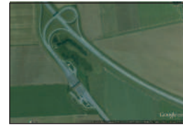
s20 Peatges d'autopista A16, A16 Saily-Fibeaucourt, França, 1998.
