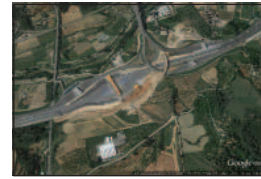
s19 Marquesines i edificis annexos AP-7, AP-7 La Jonquera-Salou, Espanya, 2011.
