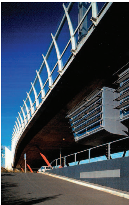
[s24] Viaducte d'autopista i centre d'operacions a Nanterre.
