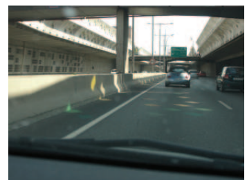
[s34] Paneles acústicos en la Gran Vía de Barcelona, una combinación de secuencia lineal y cerrada.
