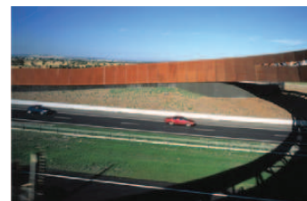
[s38] Craigieburn Bypass, tramo norte, en contacto con una zona no urbanizada.
