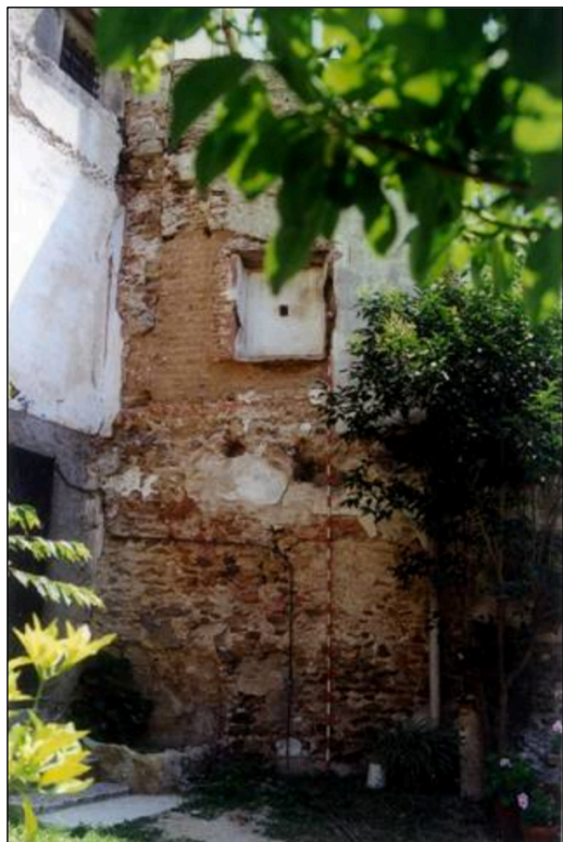
Figura 8.4: Fotografia del mur curvilini romà en l'excavació
