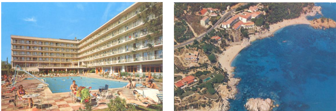
Figura 32. Establecimientos hoteleros ubicados en relación a la red viaria. El hotel Olympic en Lloret, y el Comtat de Sant Jordi en Calonge. Imágenes de los años 70
