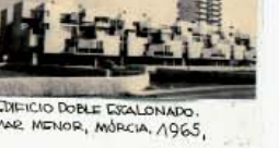
EDIFICIO DOBLE ESCALONADO, MAR MENOR, MURCIA, 1965.
