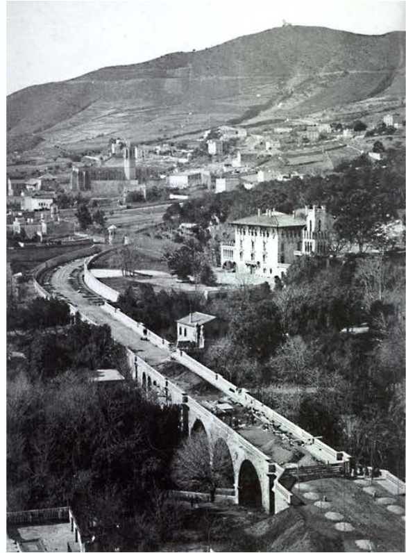
Sarrià, viaducte d'enllaç amb av. Reina Elisenda
