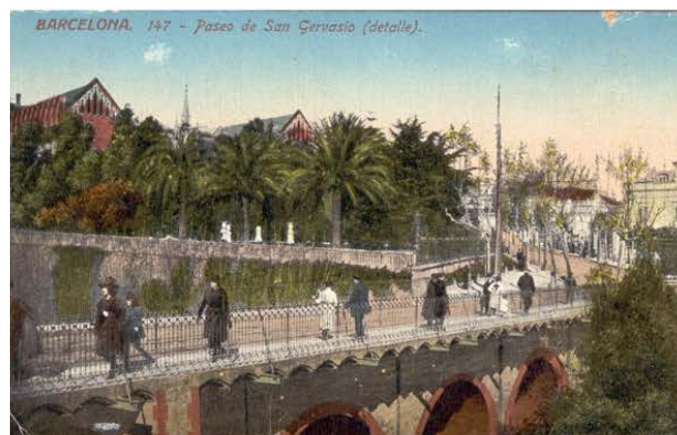
Sant Gervasi, viaducte sobre torrent de Pedralbes
