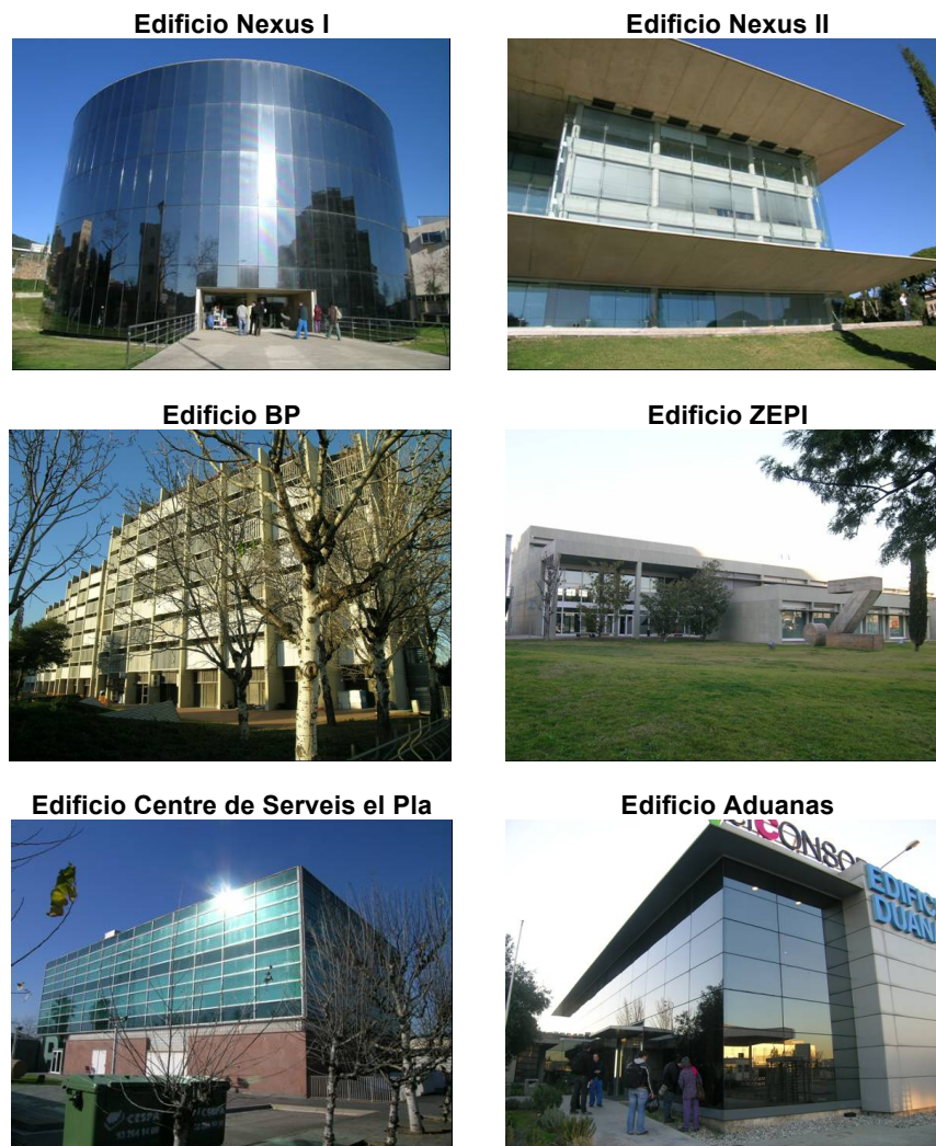
Figura 21. Imágenes de los edificios seleccionados para la monitorización. Fuente: elaboración propia
