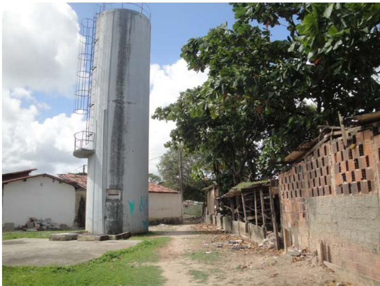
Figura 7.5 Fotografía de problema de agua Conjunto Habitacional Cordeiro
