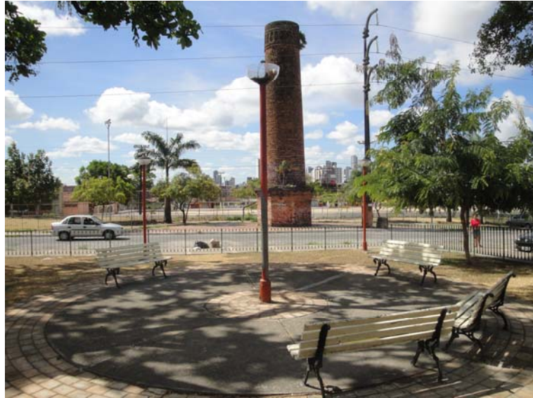
Figura 5.10 Fotografía de la chimenea de las antiguas fábricas textiles
