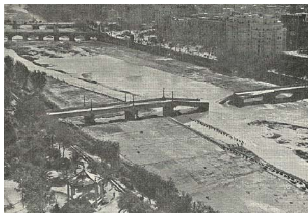
Figura 37. Fotografía, estado del cauce después de la riada. En Las inundaciones de Valencia en 1957, Historia de la riada y perspectiva de la ciudad , 1959.
