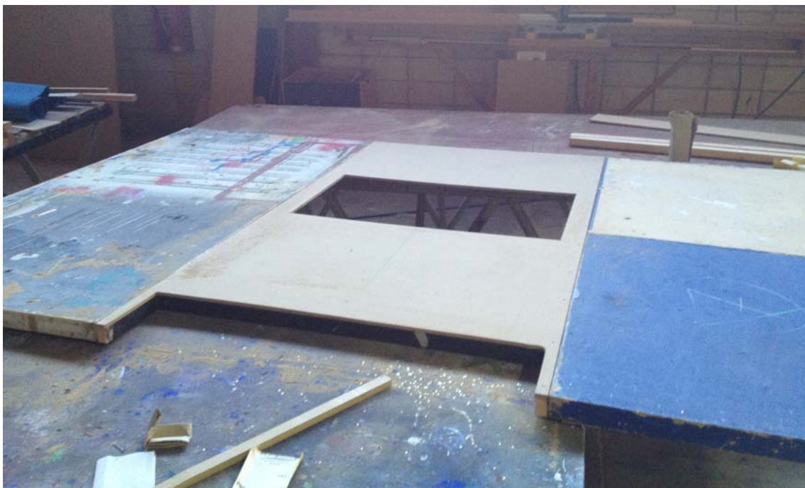
Figura 79. Fotografía de la construcción del laboratorio EEGLAB en las instalaciones de decorados de RTVE Sant Cugat del Vallès (Barcelona). Para la construcción del mismo se reciclaron varias tablas de madera y se adaptaron a las necesidades del diseño planteado para esta investigación. Una vez construido, se pintaron de negro. Fuente: fotografía del autor.
