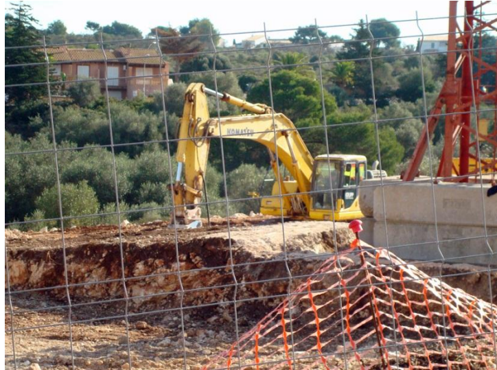
Figura 21.7: Obres de construcció d'edificis damunt de la cova Genovesa. S'ha de vigilar que no afectin a la cavitat per la salvaguarda d'aquesta i per la pròpia seguretat dels edificis (Foto J. Borrazas).
