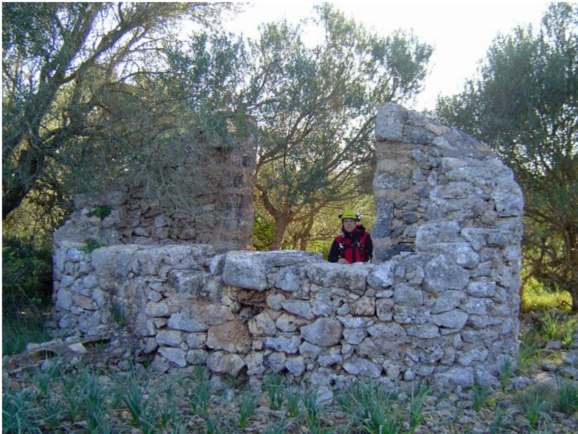
Figura 8.2.1: Bella sínia que permet l'entrada i dóna nom a la cavitat. Foto: F. Gràcia.
