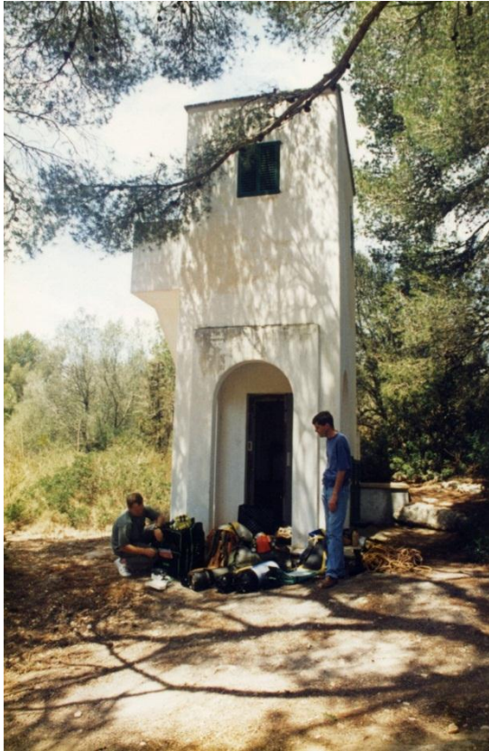
Figura 8.7.2: Caseta d'entrada a la cova de Cala Mitjana, a on es troba el pou, amb un ascensor i una escala vertical que permeten davallar fins la cavitat. Foto: F. Gràcia.
