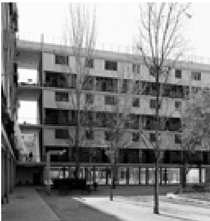
[3.19] Vista a Casa Bloc. Prolongació visual del jardí pels porxos.
