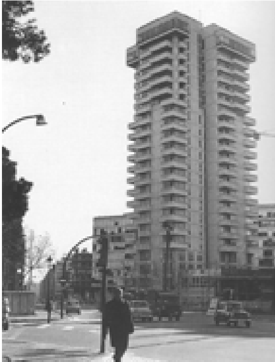
[I.b.8] Edifici Atalaya. 1966-71. F. Correa / A. Milà
