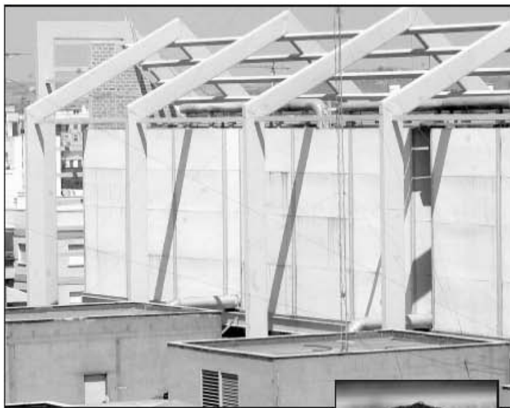
Las torres de refrigeración de El Corte Inglés en Murcia.
