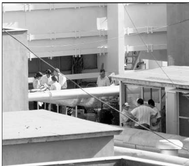
Los técnicos trabajando en las torres de refrigeración de El Corte Inglés, a las 19.30 horas de ayer.
