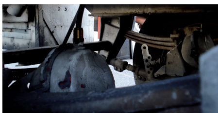
Figura 14: Tomas de presión difícilmente accesibles
