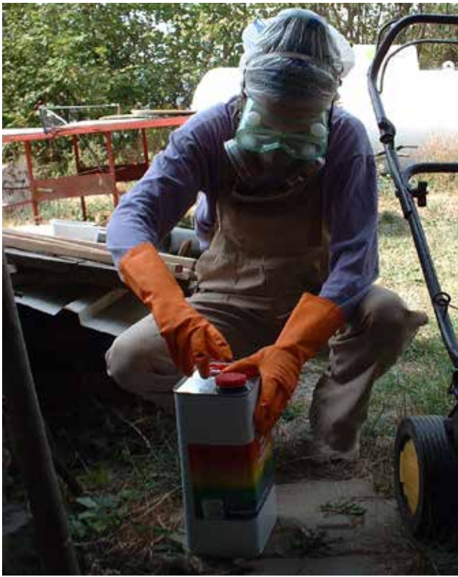
Preparació de la resina de polièster amb totes les mesures de seguretat. Màscara de gasos, guants, ulleres, roba de treball, i tot a l'aire lliure.
