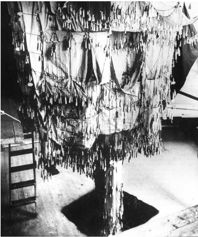
Maqueta polifuncional de cordill i saquets de perdigons de l'església de la Colònia Güell, Antoni Gaudí.
