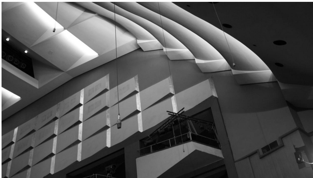
Figura 39 Muestra un ángulo detallado de la marquesina de proscenio reflejante del sonido en el Auditorium de Palma.
