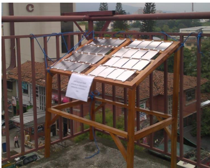
Figura 4.27 Rack de monitoreo montado
