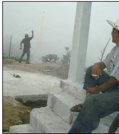
Imagen 17. Segundo día de trabajo, final de los trabajos de mantenimiento, Huahuaxtla.
